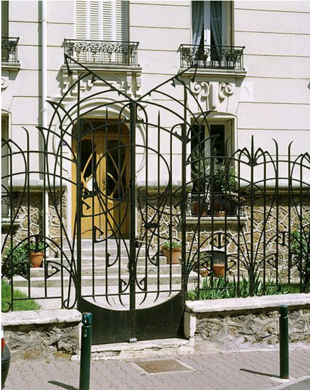
Détail de la grille d'entrée en ferronnerie d'un immeuble, 3 rue Batiÿn de Perreuse.
