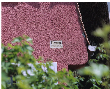
Détail de la signature de l'architecte Tsoire sur la façade d'une maison, rue Louis Léon Lepoutre. Phot. Stéphane Asseline IVR11_20049400144XA
