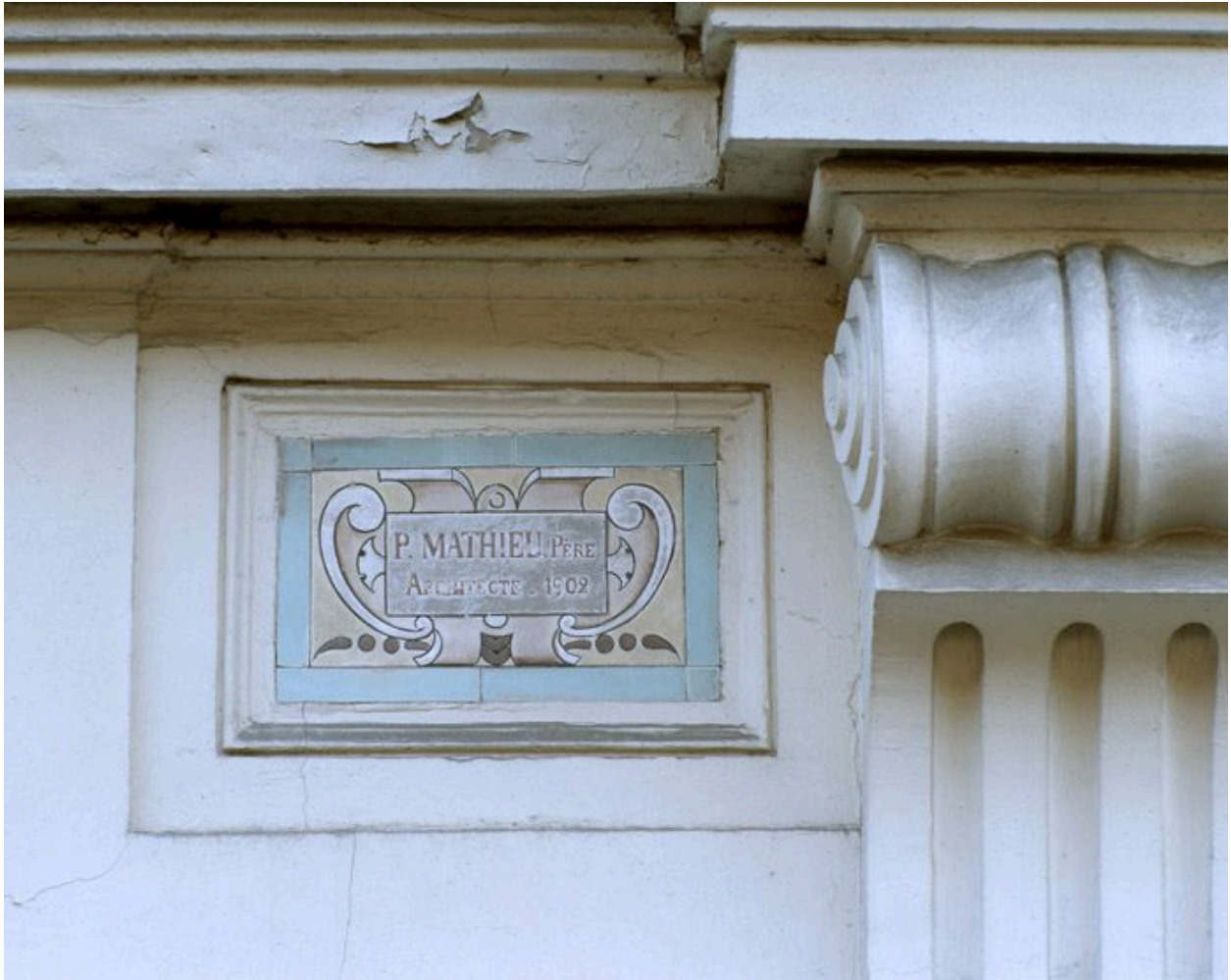
Immeuble, 6 rue Coulmiers. Détail des carreaux vernissés portant la date et signature de l'architecte "P. Mathieu père. 1902
