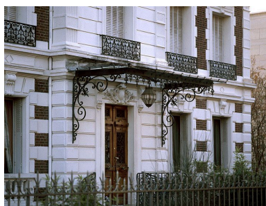
Détail de la marquise d'une maison, 6 avenue Odette. IVR11_20059400058XA
