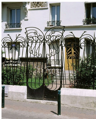
Détail de la grille d'entrée en ferronnerie d'un immeuble, 1 bis rue Bâÿyn de Perreuse. Phot. Stéphane Asseline IVR11_20049400100XA
