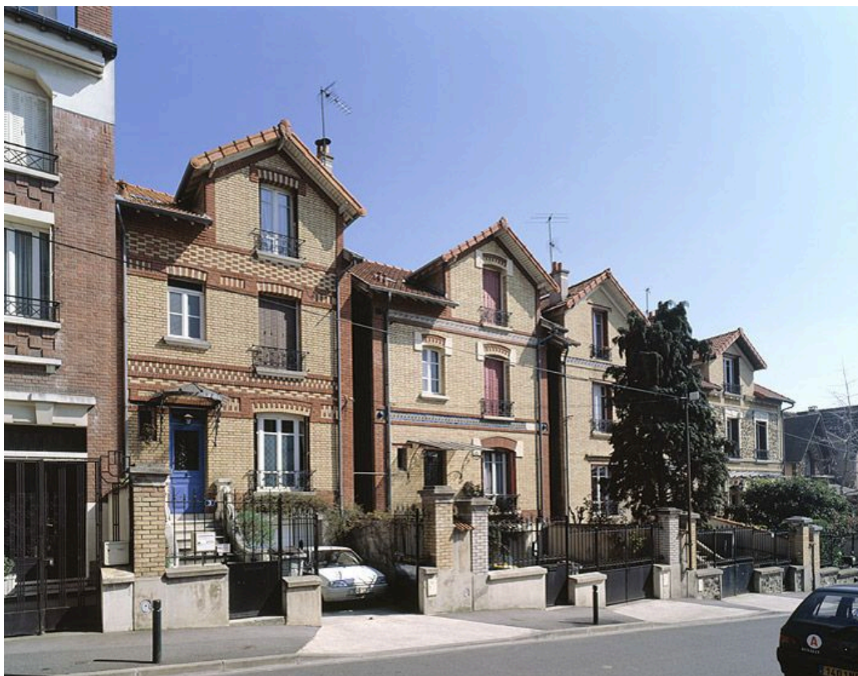
Vue d'un ensemble de 4 maisons, 3-5 rue de l'Armistice.
