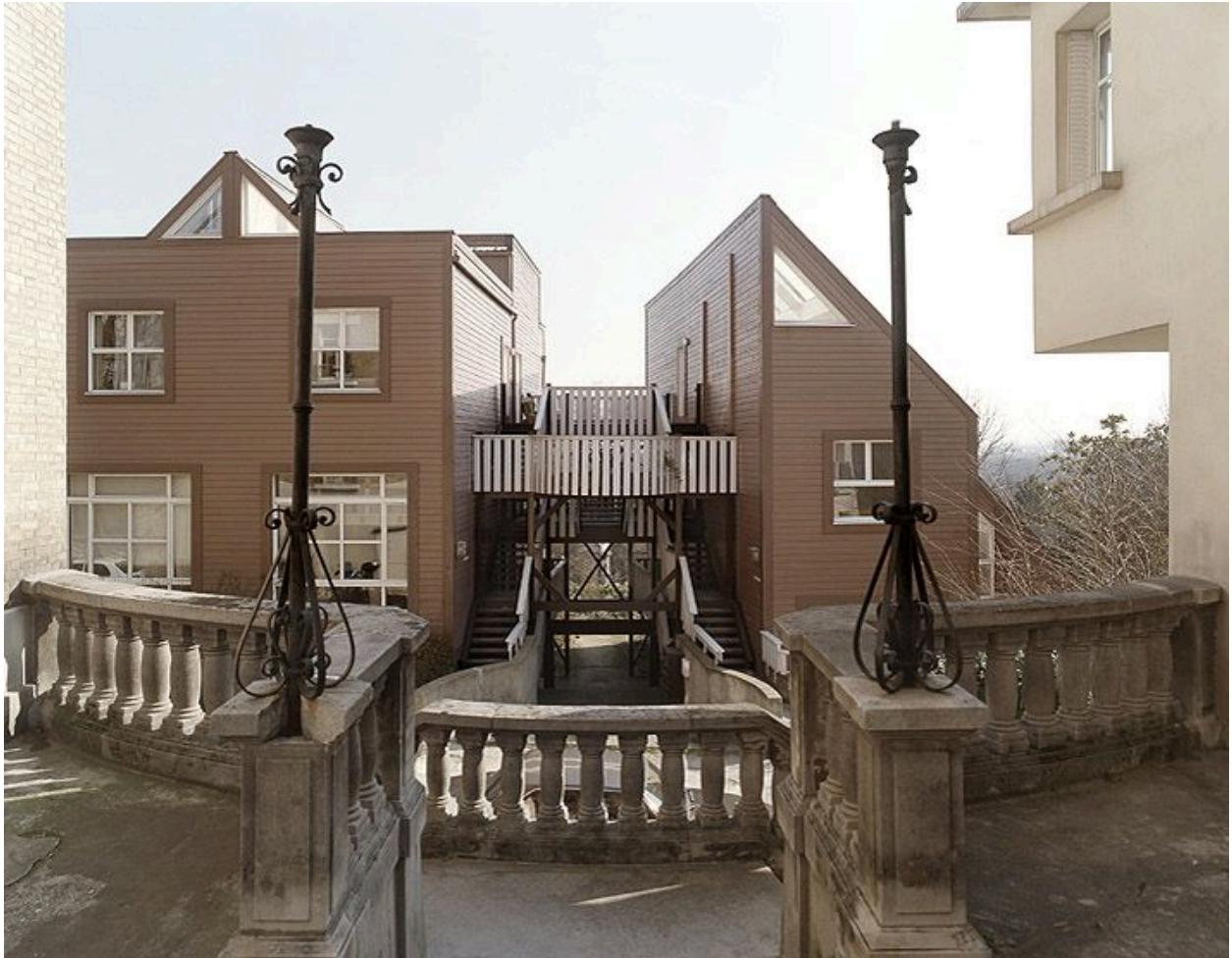
Immeuble, avenue Gugnon. Vue depuis le square de la Fontaine de l'immeuble construit vers 1980 par l'architecte Jean-Claude Bernard.
