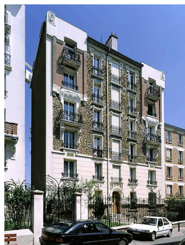
Immeuble, 3 rue Bâÿyn de Perreuse. Vue d'ensemble de la façade sur rue. Phot. Stéphane Asseline IVR11_20049400098VA
