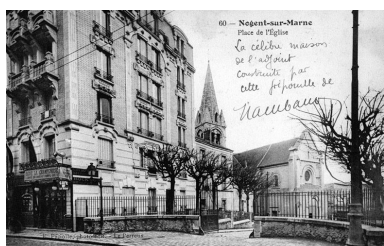
Immeuble, Grande rue Charles de Gaulle. Vue d'ensemble avec en arrière plan l'église. La carte postale, circa 1910, porte un autographe d'Albert Nachbaur. (Collection particulière) IVR11_20049400279NUCB
