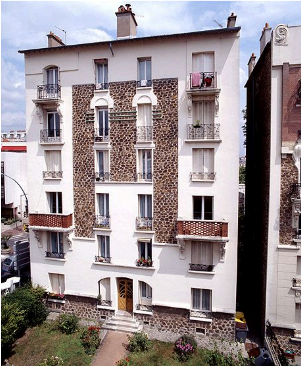
Immeuble, 1 bis rue Batiyn de Perreuse. Vue d'ensemble de la façade sur rue prise depuis l'école en face.
