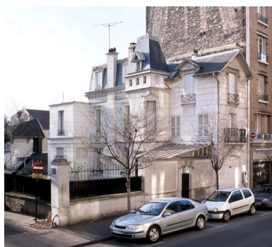
Maison, 20 Grande rue Charles de Gaulle. Vue d'ensemble. Phot. Stéphane Asseline IVR11_20059400118XA
