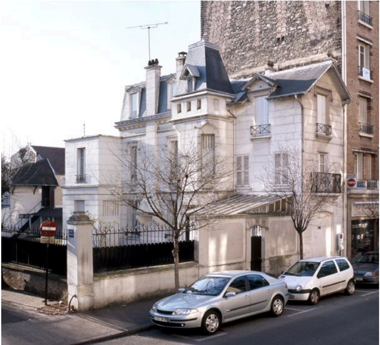
Maison, 20 Grande rue Charles de Gaulle. Vue d'ensemble.
