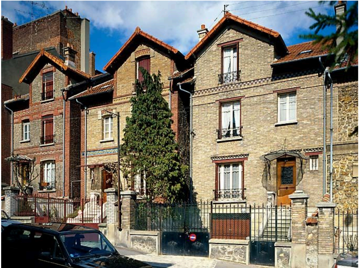
Maisons, 3-5 rue de l'Armistice. Façade antérieure.
