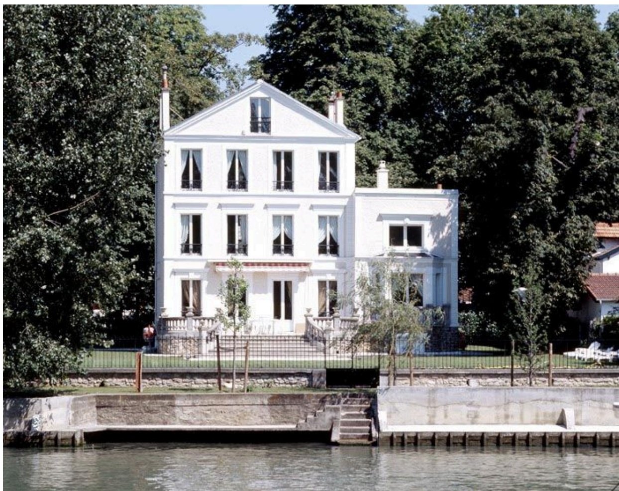
Maison, 55 île de Beauté. Vue d'ensemble depuis le quai de Champigny.
