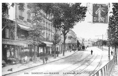
Vue d'ensemble de la Grande rue Charles de Gaulle. A droite : place de la Mairie. Carte postale. (AD Val-de-Marne) IVR11_19859400219XB
