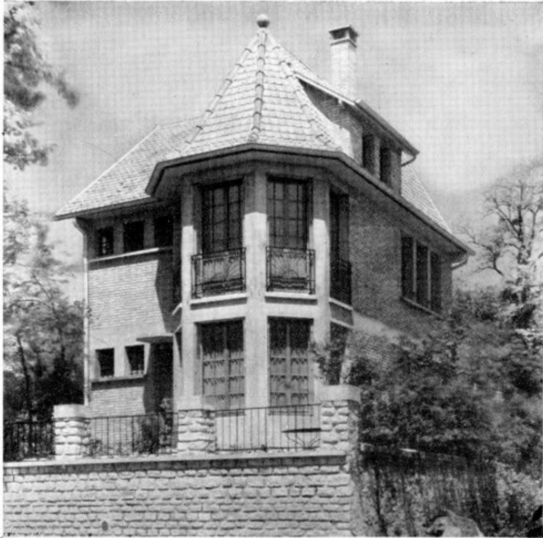
« LES PÉTUNIAS », coquette Villa construite à Nogent-sur-Marne. Comparez cette construction aux Maisons banales qui enlaidissent la plupart des banlieues. G. Tissoire, inv.)
