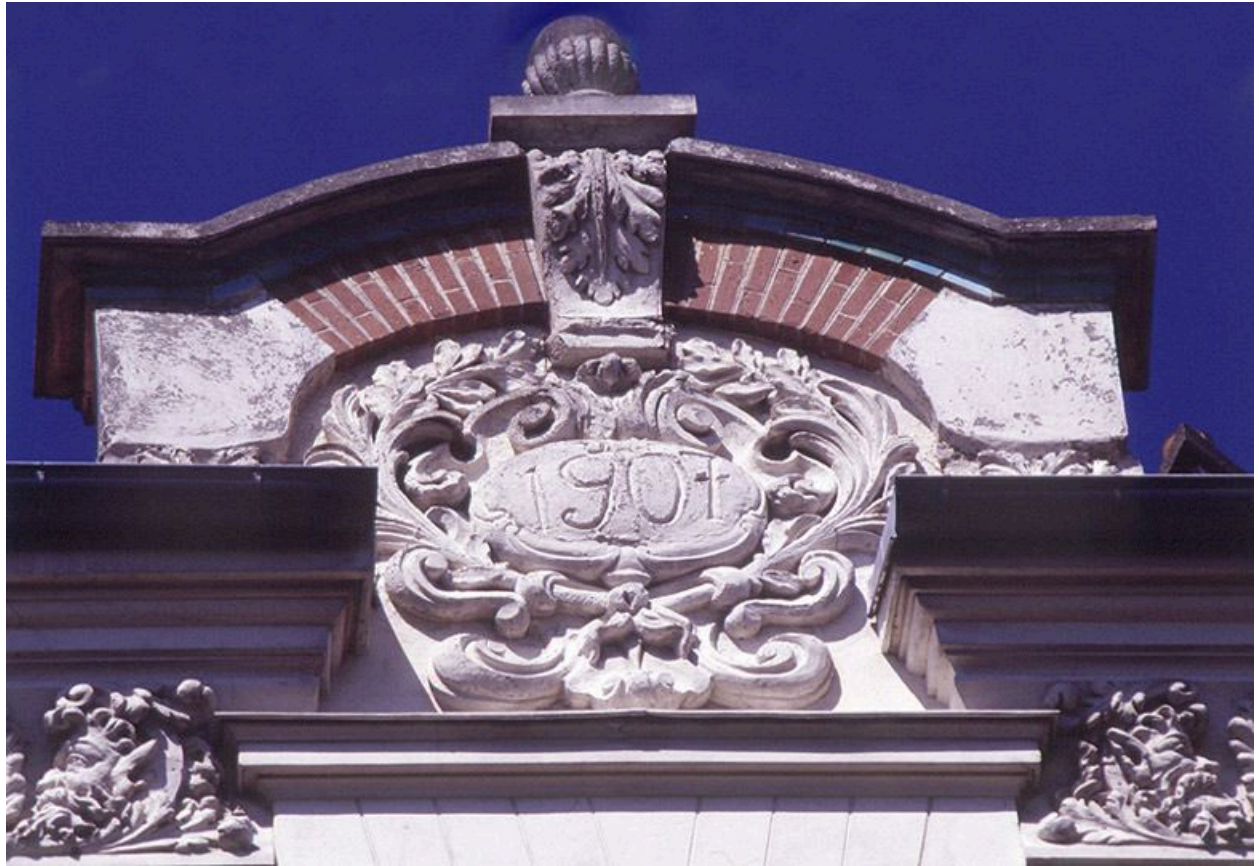
Détail du fronton d'un immeuble, 11 rue de l'Abbé Guilleminault.
