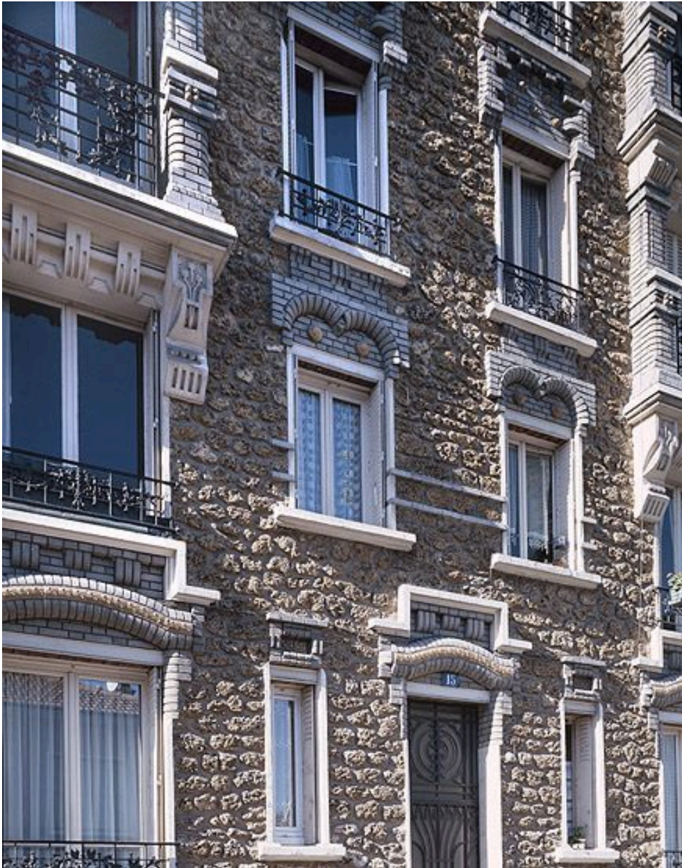
Immeuble, 15 rue Guy Moquet. Vue de la partie basse de la façade.
