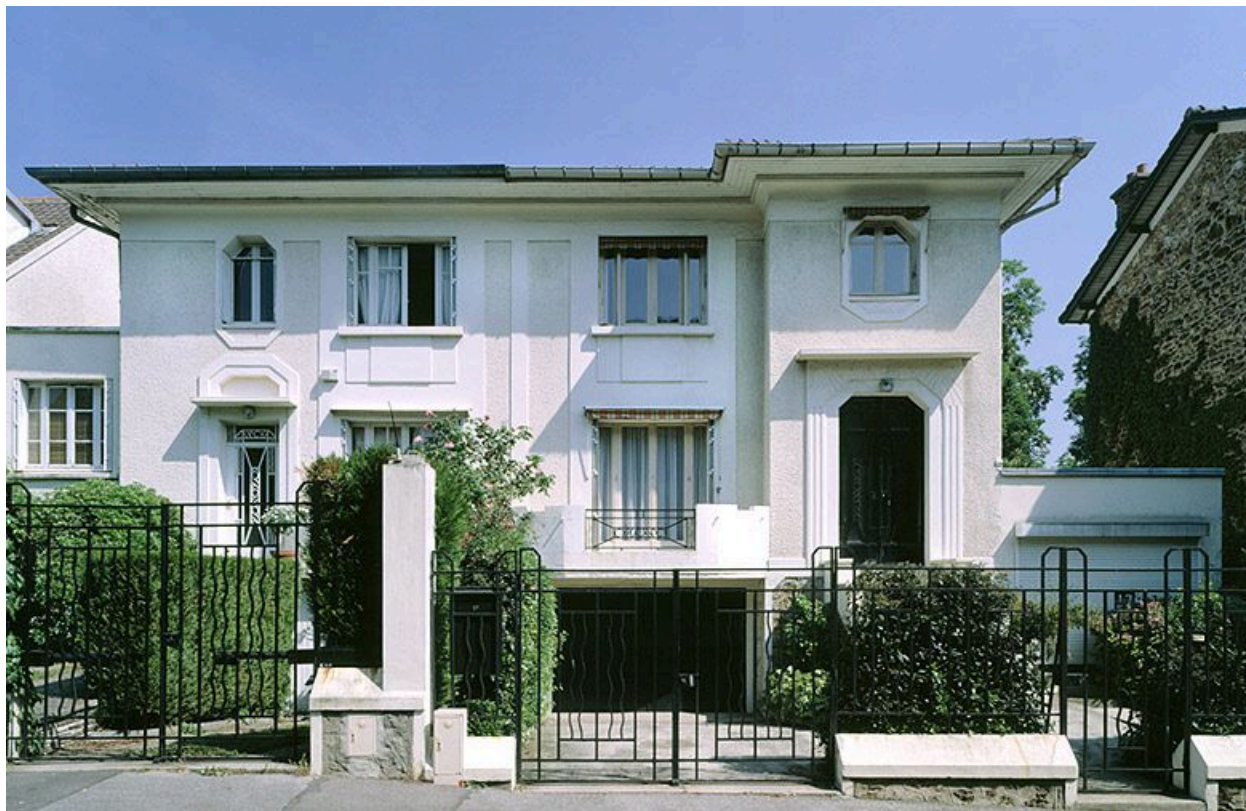
Maisons jumelles, 15-17 rue Louis Léon Lepoutre.
