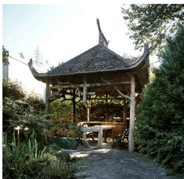
Fabrique de jardin en forme de pagode chinoise construite en béton imitant le bois, 95 rue des Héros Nogentais. Phot. Laurent Kruszyk IVR11_20049400648XA
