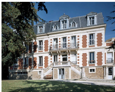
Maison, 8 rue des Défenseurs de Verdun. Phot. Stéphane Asseline IVR11_20049400765VA
