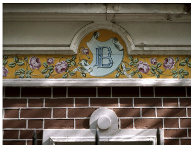
Détail des carreaux de céramique vernissée d'une maison, 53 avenue de Joinville.
