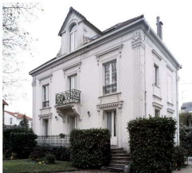
Maison, 13 avenue Charles V. Vue d'ensemble. Phot. Stéphane Asseline IVR11_20059400226VA
