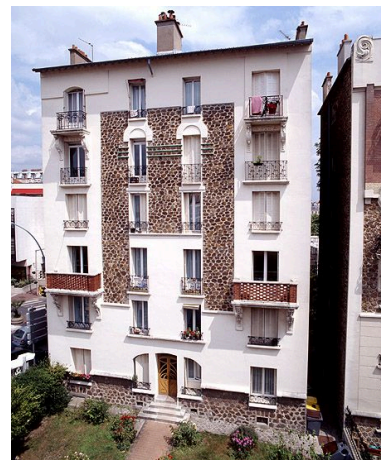
Immeuble, 1 bis rue Baiÿn de Perreuse. Vue d'ensemble de la façade sur rue prise depuis l'école en face. Phot. Stéphane Asseline IVR11_20049400445XA
