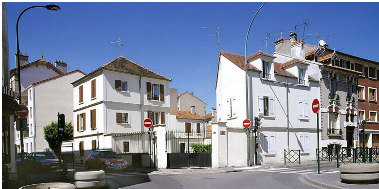
Maison, 20 rue Thiers. Vue d'ensemble.
