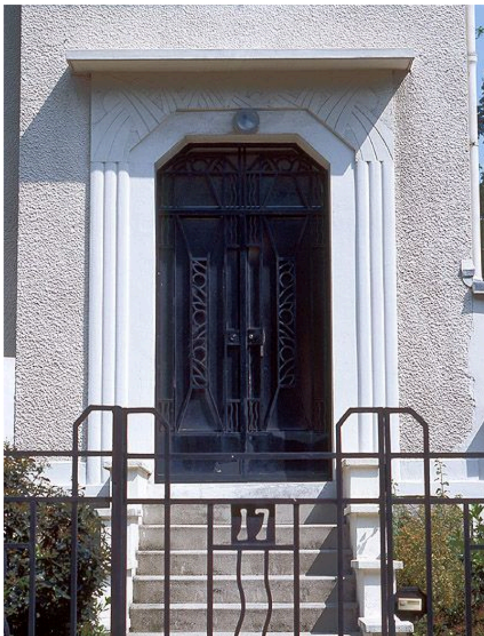
Détail de la porte d'entrée d'une maison, 17 rue Louis Léon Lepoutre.
