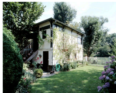
Maison, 46 île de Beauté. Vue du pavillon dans le jardin surplombant la Marne.
