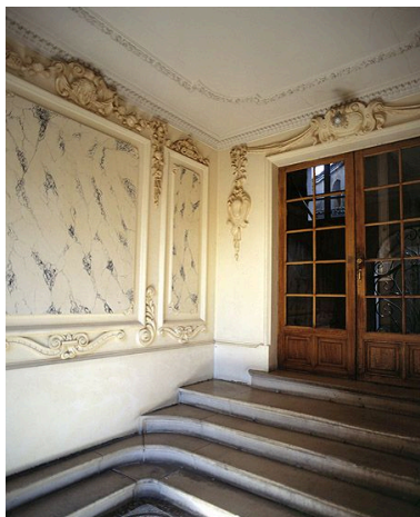
Hall d'entrée d'un immeuble, 11 rue de l'Abbé Guillaume. Vue du hall d'entrée. Phot. Stéphane Asseline IVR11_20049400116XA
