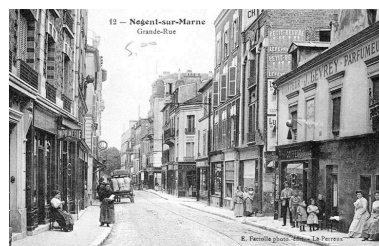
Vue de la Grande rue Charles de Gaulle, en direction de la place du Marché. Carte postale. (AD Val-de-Marne) IVR11_19859400221XB
