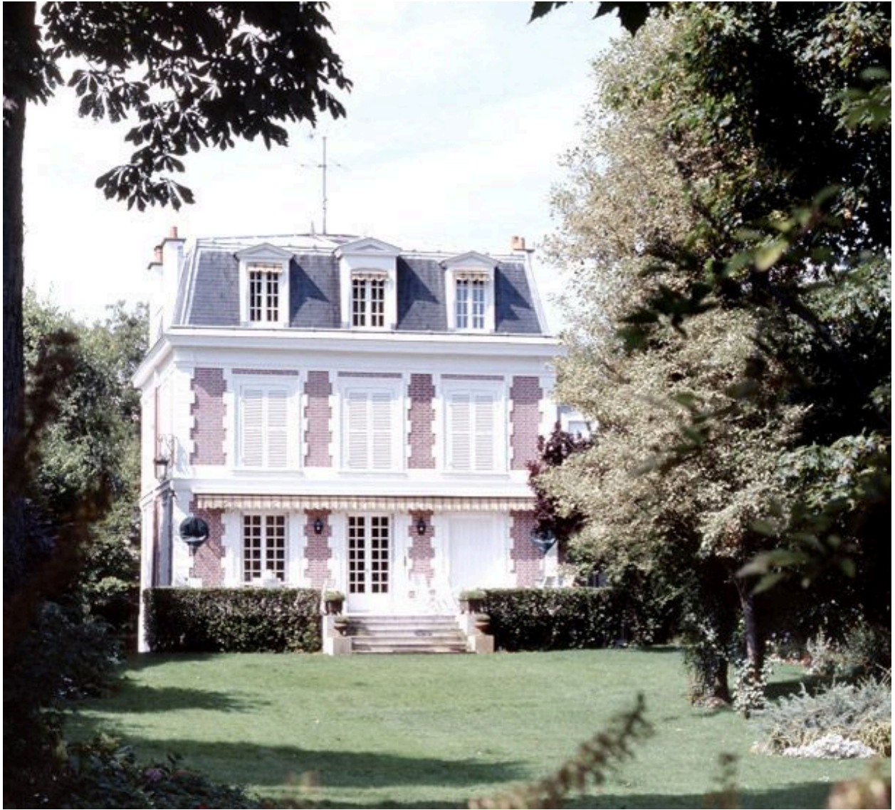
Maison, 24 bis île de Beauté. Vue d'ensemble depuis le jardin sur la Marne.
