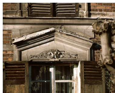
Détail de la mise en oeuvre des décors d'enduit d'une maison, 33 rue du Val de Beauté. IVR11_20059400168XA
