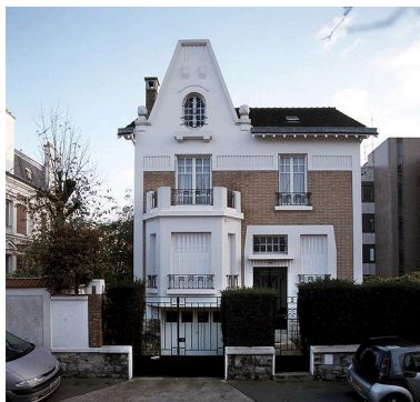
Maison, 2 rue Plisson. Vue d'ensemble. IVR11_20059400050XA
