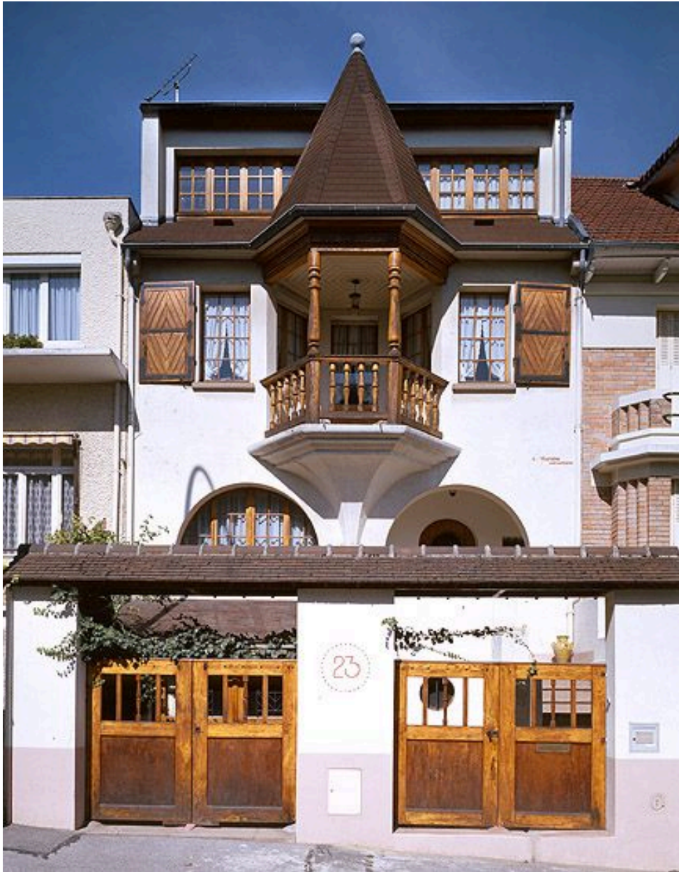
Maison, 23 rue Louis-Léon Lepoutre. Vue d'ensemble.
