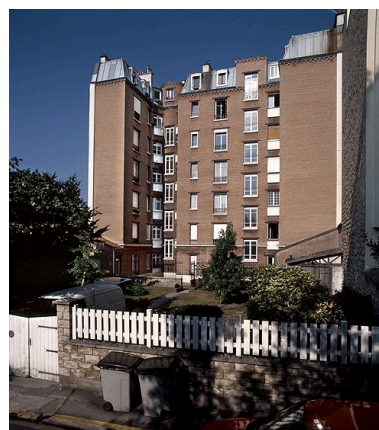
Immeuble, 3 rue Victor Hugo. Vue d'ensemble de la façade arrière. IVR11_20059400106XA
