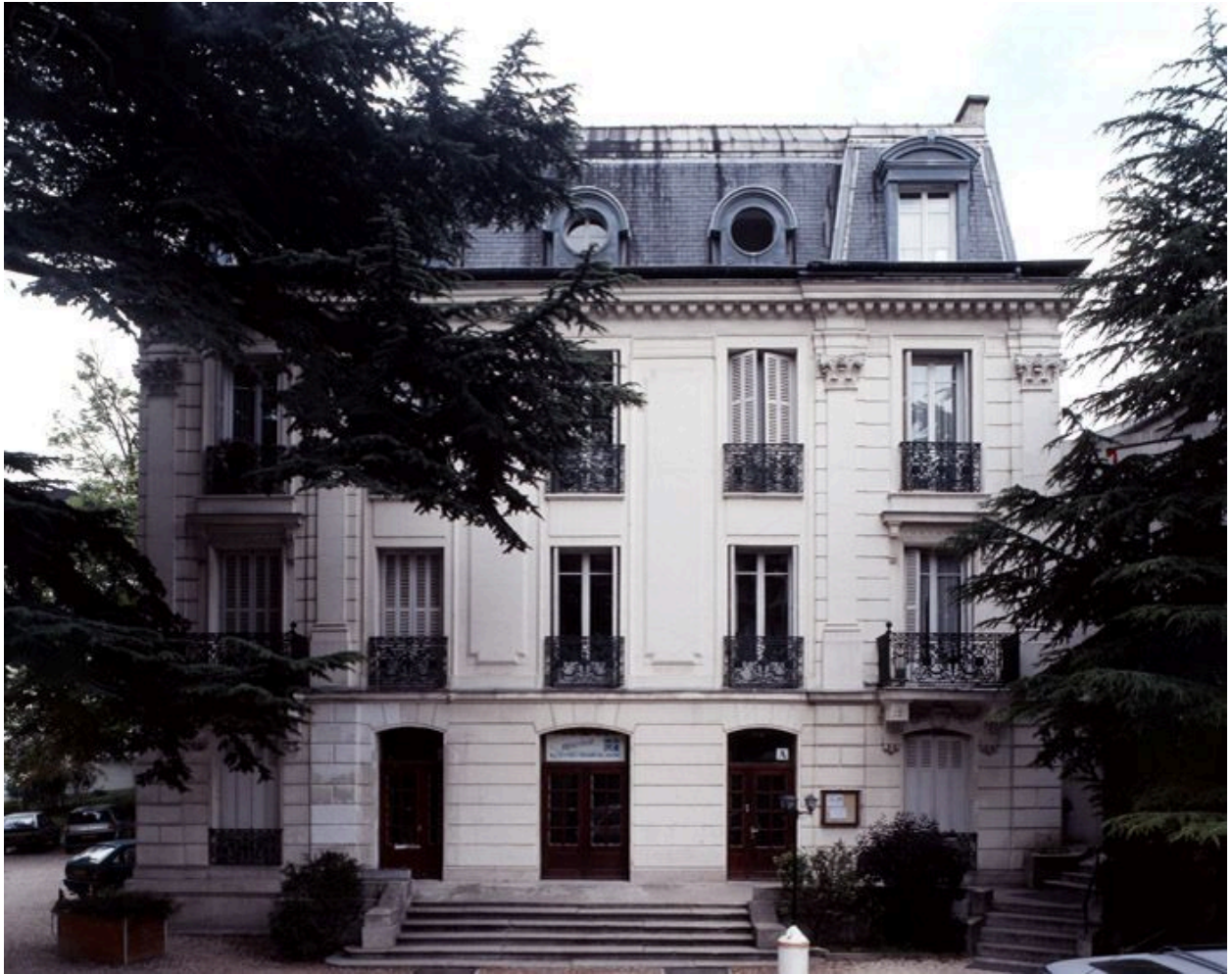
Demeure accueillant aujourd'hui un institut biblique, 39 Grande rue Charles de Gaulle. Vue d'ensemble de la façade sur la rue.
