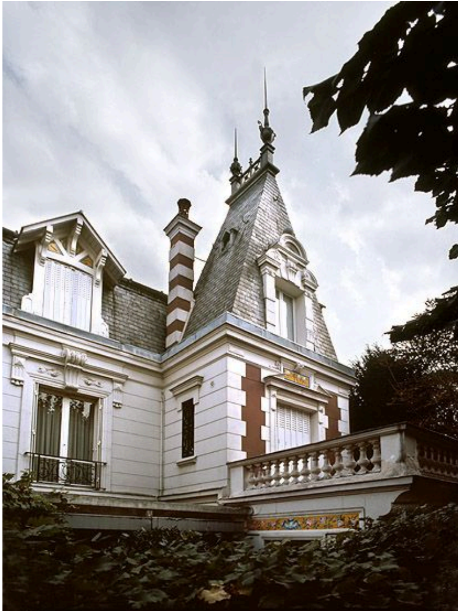
Maison, 53 avenue de Joinville. Vue depuis la rue.
