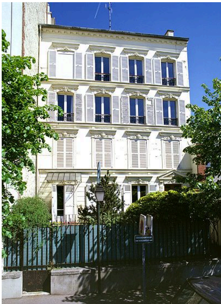
Immeuble, 8 place Pierre Sénard. Vue d'ensemble.
