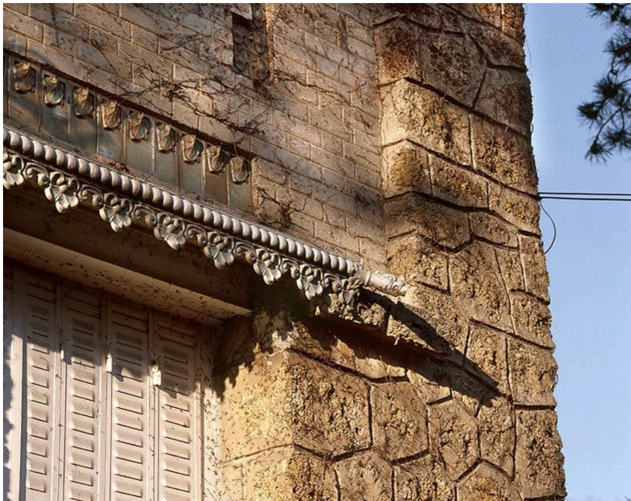
Maison de Georges Nachbaur, détail de gouttière ouvragée, 15 rue Lucien Bellivier.
