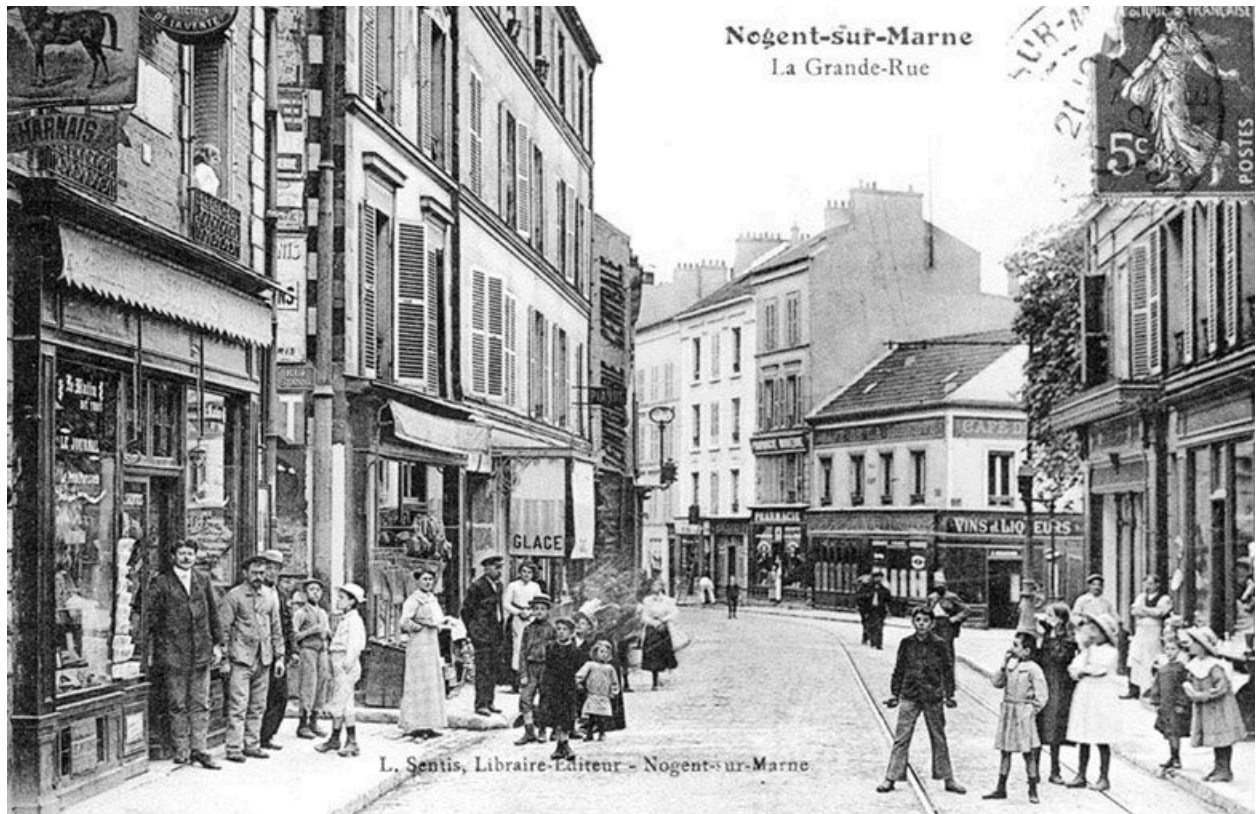
Vue de la Grande rue Charles de Gaulle, au débouché de la rue Agnès Sorel, à droite et de la rue Sainte-Anne, à gauche. Carte postale. (AD Val-de-Marne)
