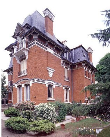
Maison, 10 rue André Pontier. Vue d'ensemble. Phot. Stéphane Asseline IVR11_20049400052VA
