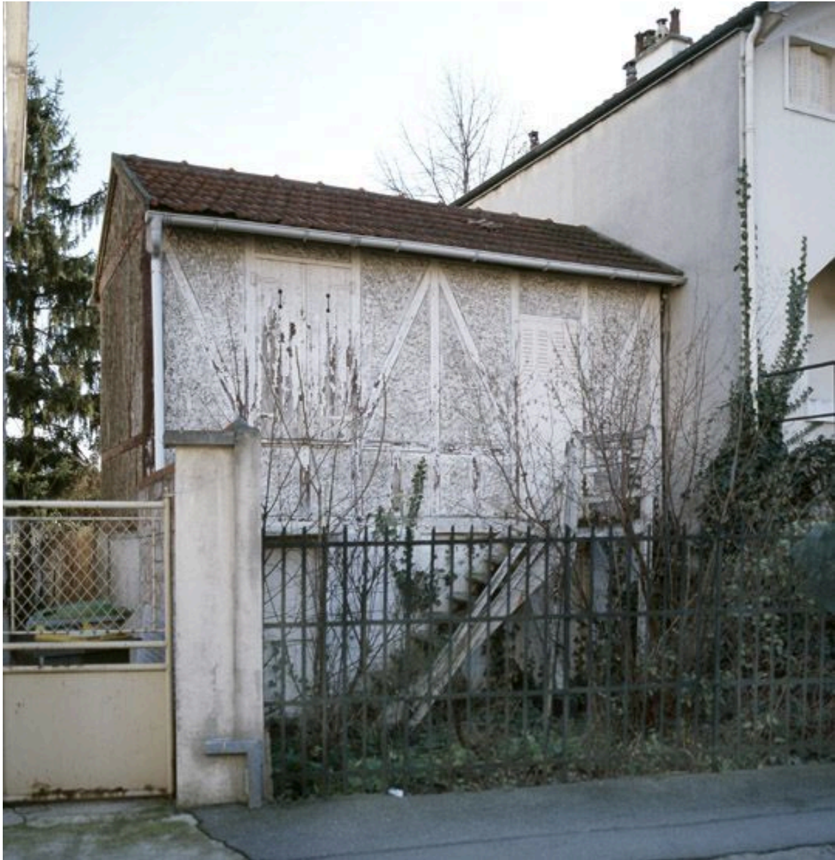
Maison dit cabanon, 50 rue de Plaisance.
