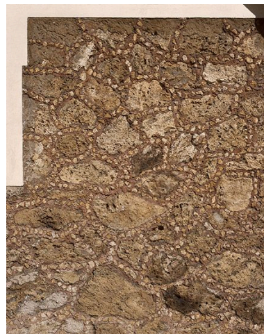
Détail de la mise en oeuvre de la meulière rocaillées en soubassement d'une maison, 8 rue des Défenseurs de Verdun. Phot. Stéphane Asseline IVR11_20049400767XA
