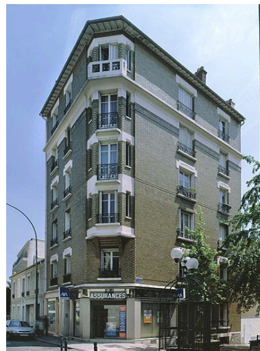
Immeuble, 70 bis rue des Héros Nogentais. Vue d'ensemble. Phot. Stéphane Asseline IVR11_20049400127VA
