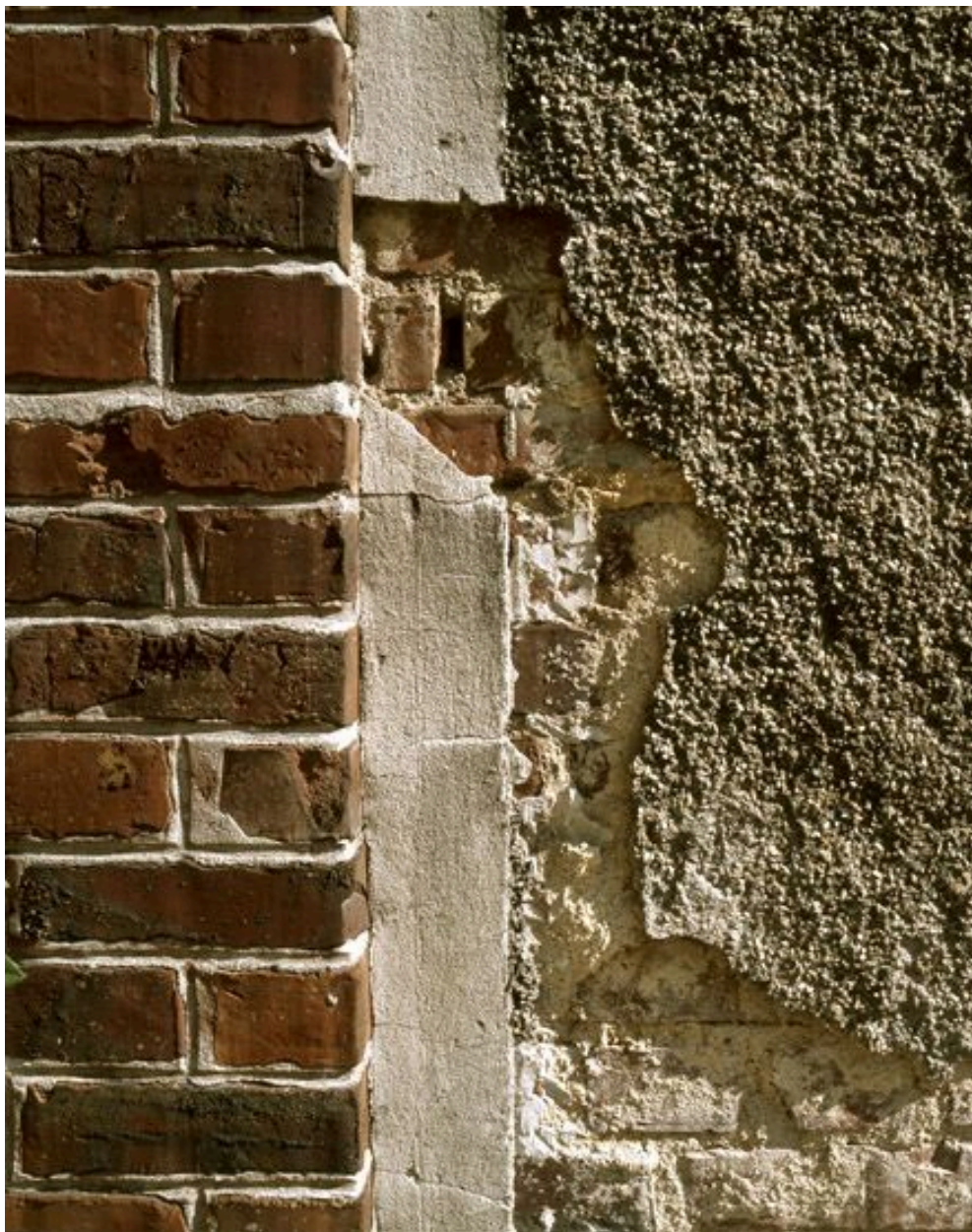
Détail de la mise en oeuvre des matériaux du logement de gardien d'une maison, aujourd'hui lycée technique, 54 avenue de la Source.
