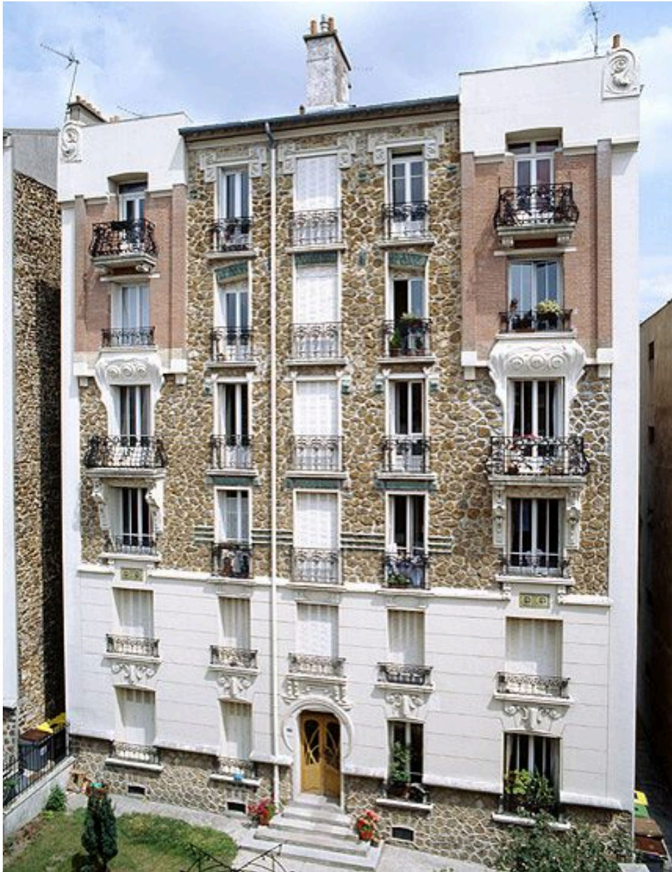
Immeuble, 3 rue Batiïn de Perreuse. Vue d'ensemble de la façade sur rue prise depuis l'école en face.
