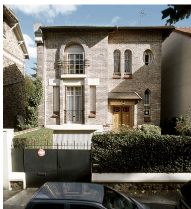
Maison, 72 rue de Coulmier. Vue d'ensemble. Phot. Laurent Kruszyk IVR11_20049400637XA
