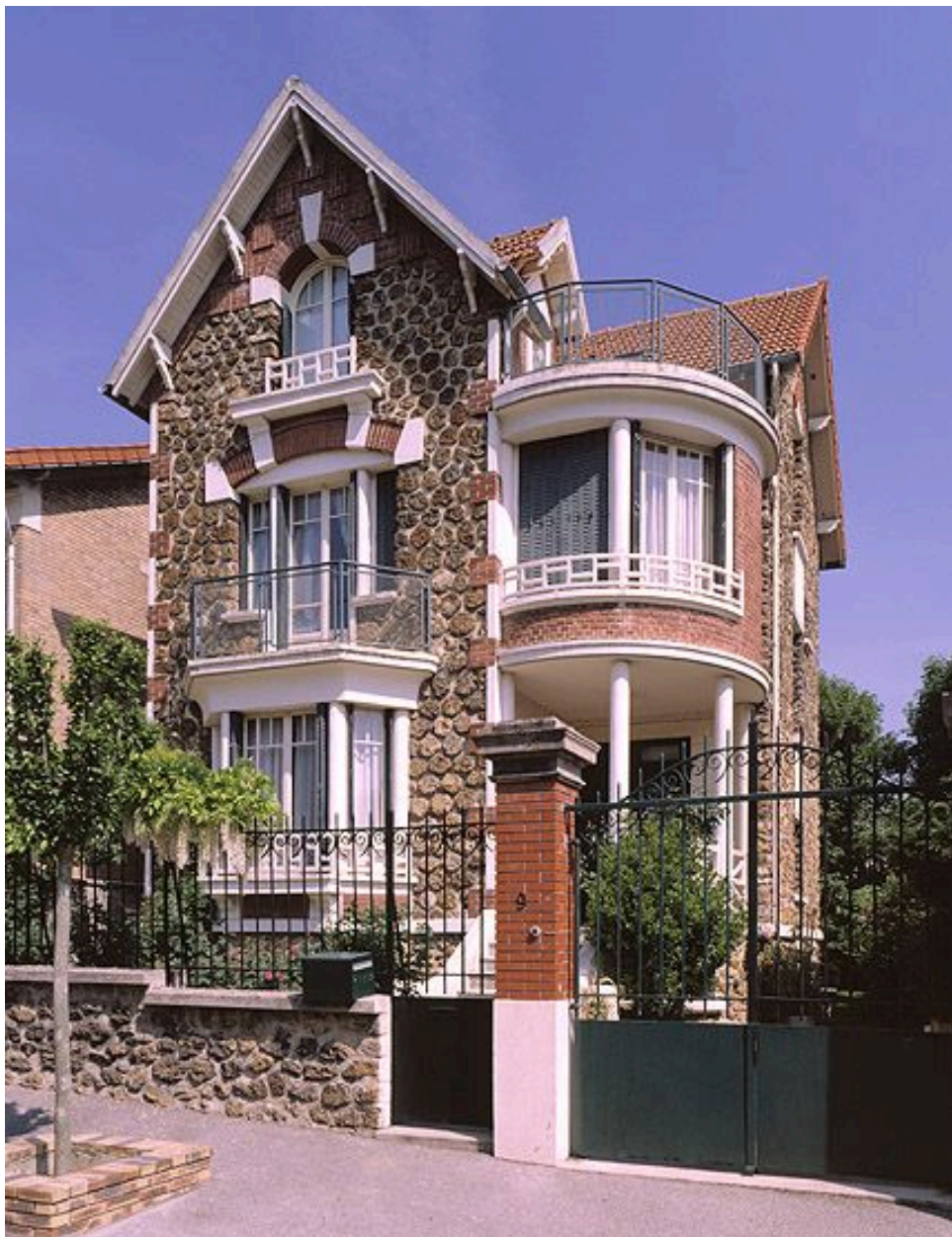
Maison, 9 rue Louis Léon Lepoutre. Vue d'ensemble.
