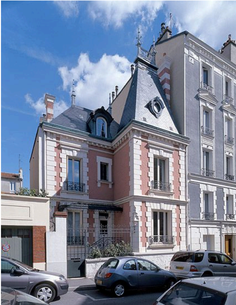
Maison, 3 rue Edmond Vitry. Vue d'ensemble depuis la rue.
