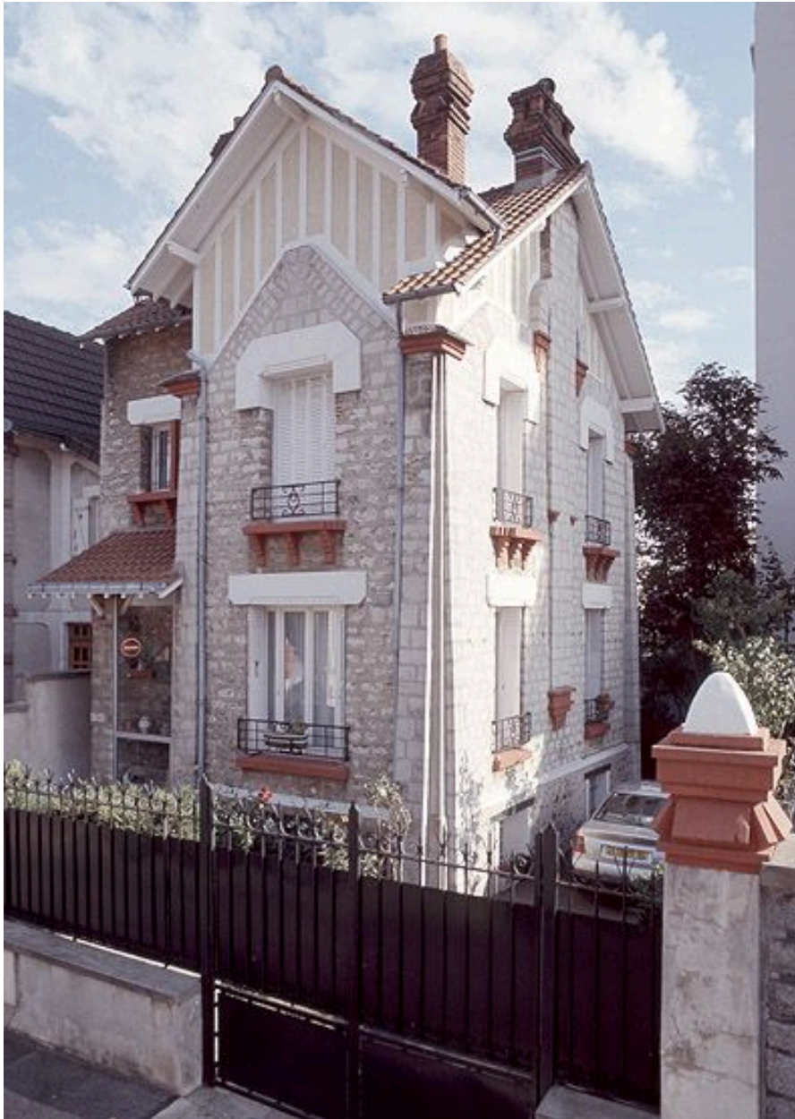
Maison, 8 rue des Clamarts. Vue d'ensemble.
