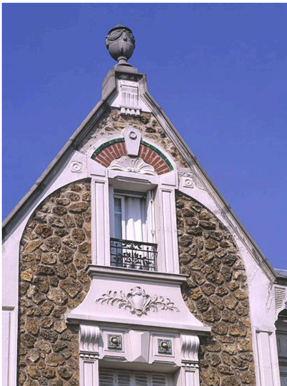
Détail du mur pignon surmonté d'un vase d'une maison, 20 rue Edmond Vitry.
