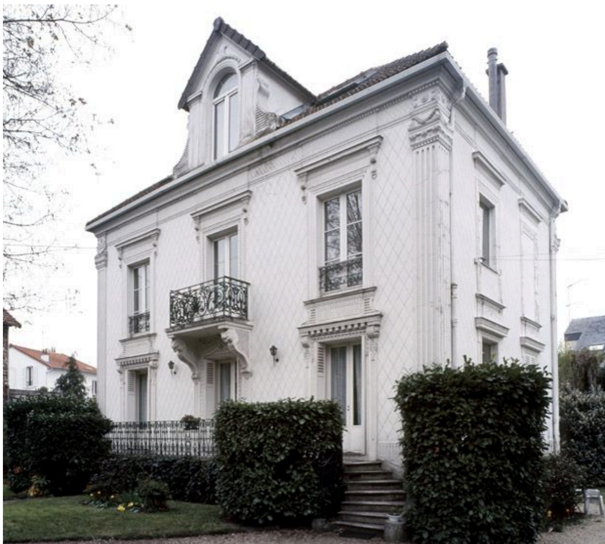
Maison, 13 avenue Charles V. Vue d'ensemble.
