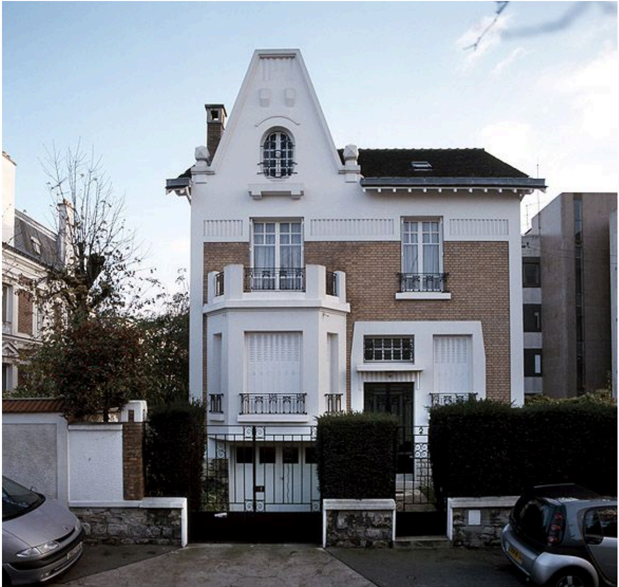
Maison, 2 rue Plisson. Vue d'ensemble.
