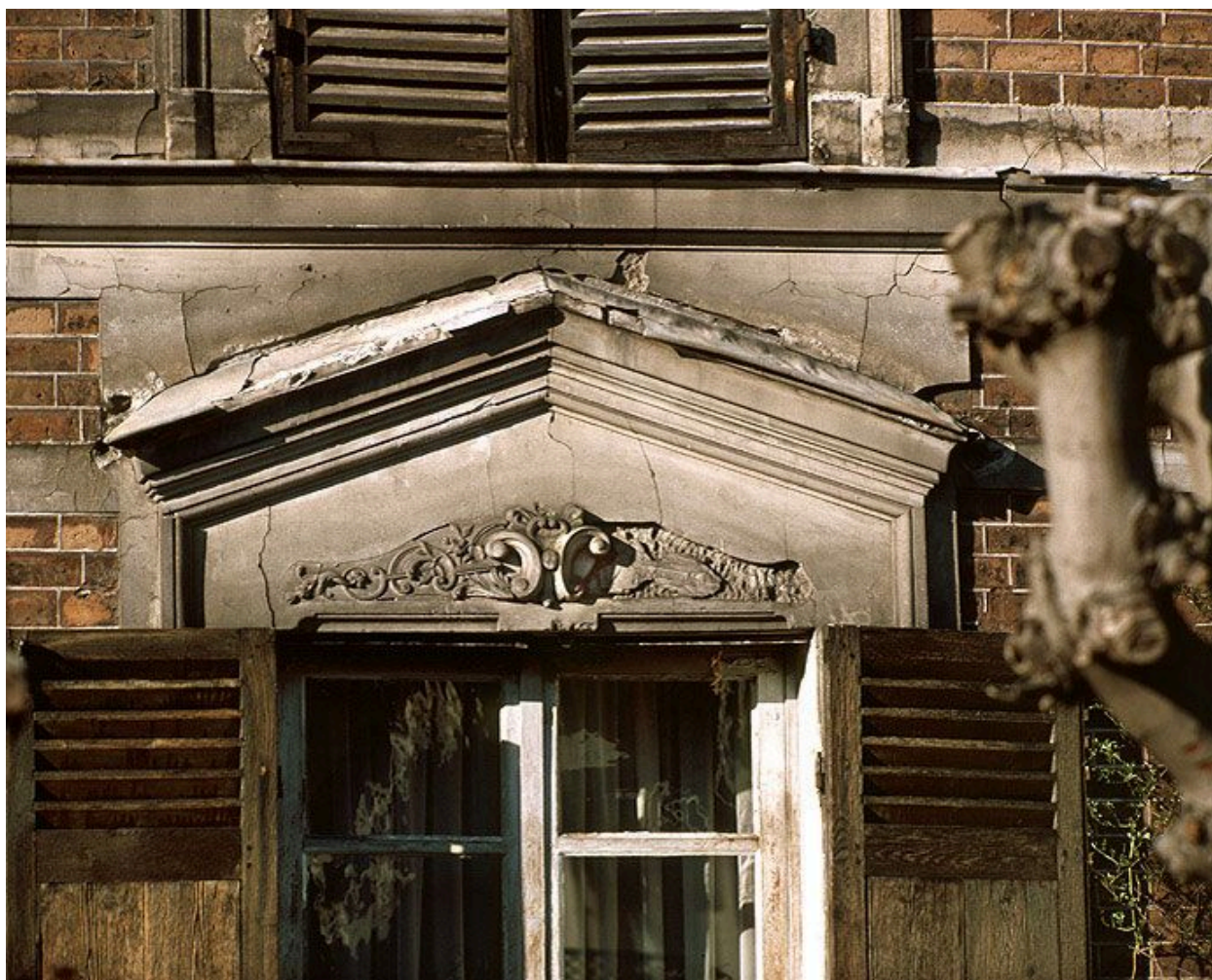
Détail de la mise en oeuvre des décors d'enduit d'une maison, 33 rue du Val de Beauté.
