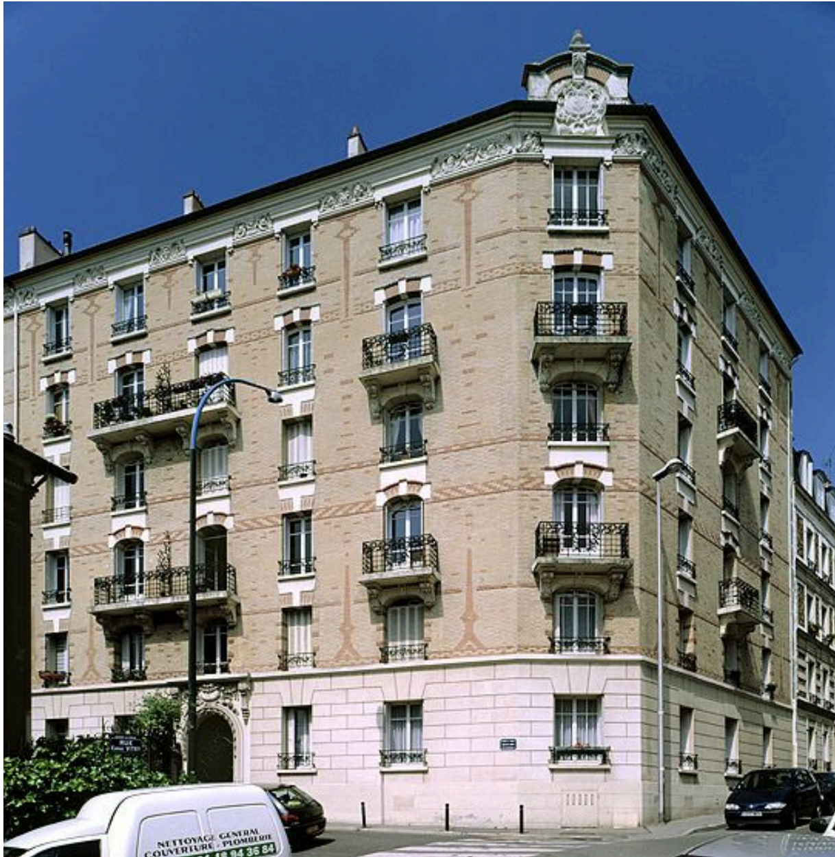
Immeuble, 11 rue de l'Abbé Guillaume. Vue d'ensemble.
