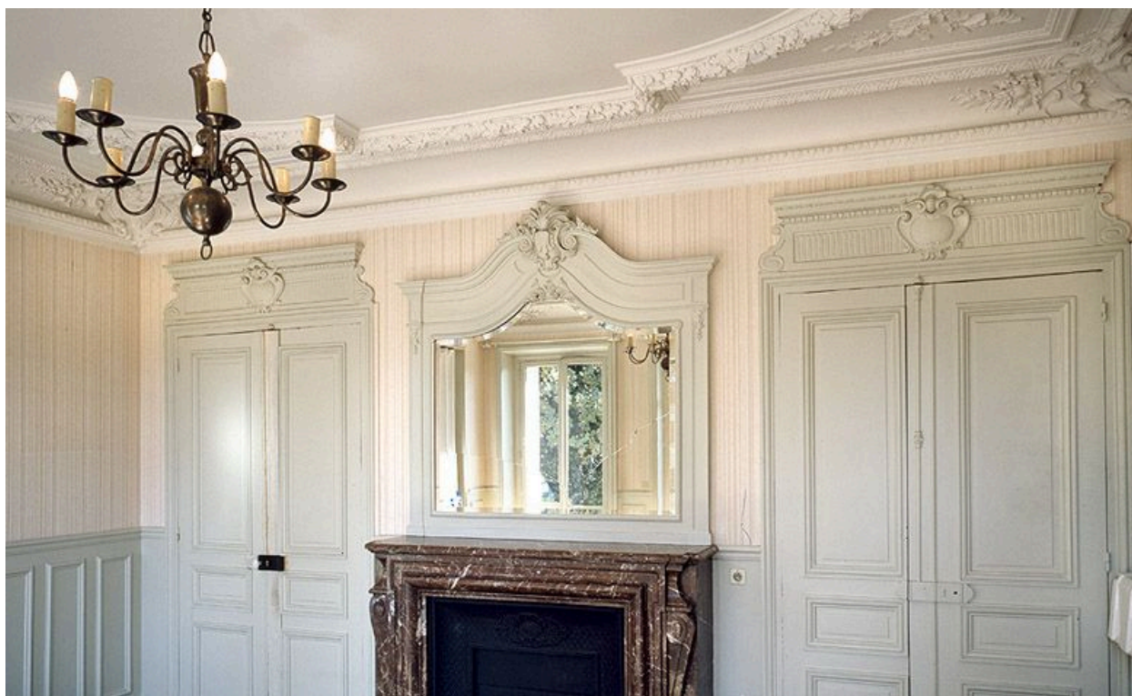
Vue intérieure d'un salon au rez-de-chaussée sur le jardin, 8 rue des Défenseurs de Verdun.
