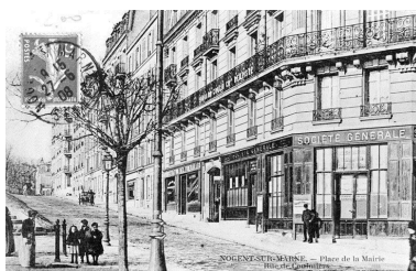
Vue de la rue de Coulmiers (anciennement place de la Mairie). Carte postale. (AD Val-de-Marne) IVR11_19859400228XB
