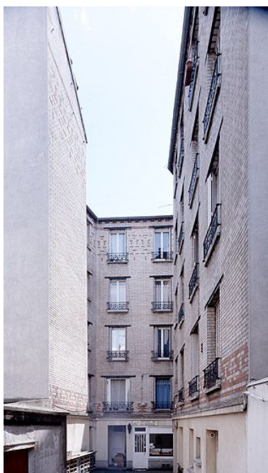
Vue d'ensemble depuis la cour d'un immeuble, 124 Grande rue Charles de Gaulle. La cour est si étroite qu'elle forme comme un boyau. Phot. Stéphane Asseline IVR11_20049400786VA
