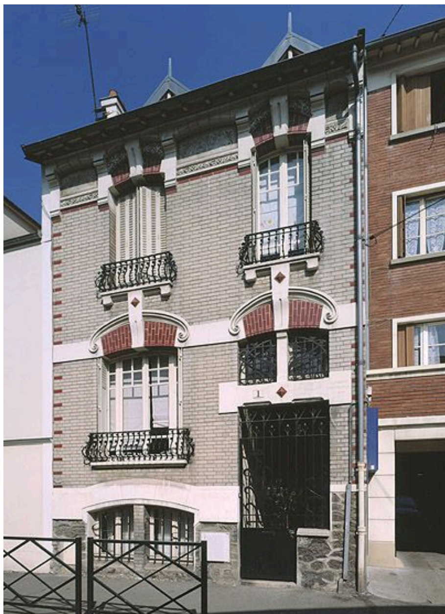
Maison, 1 rue Thiers. Vue d'ensemble.
