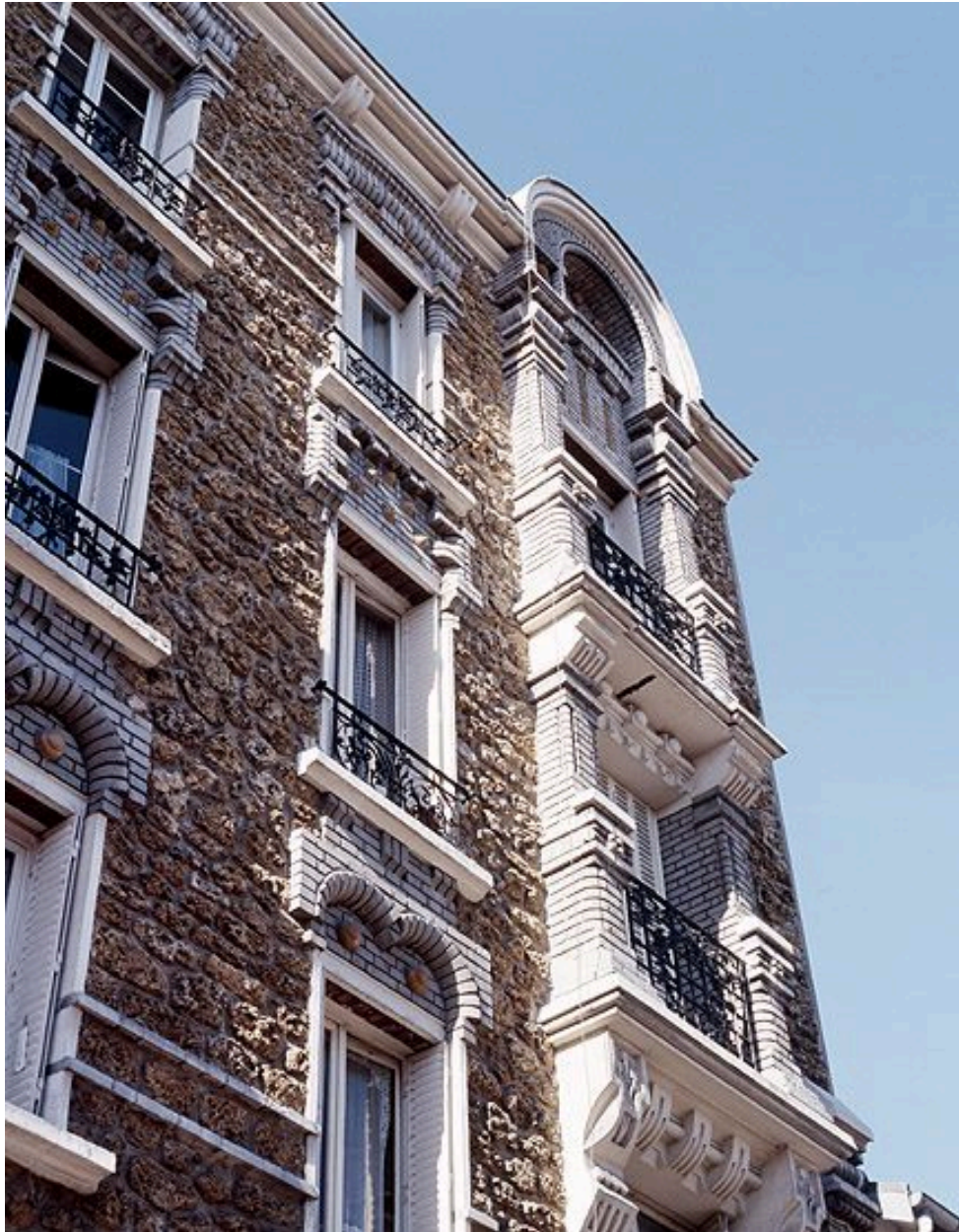
Immeuble, 15 rue Guy Moquet. Vue de la partie haute de la façade.
