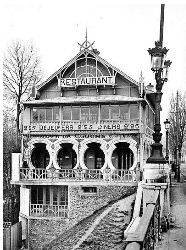
Détail de la photographie du restaurant (guinguette) à Nogent-sur-Marne, Nachbaur, architecte. Tiré de : Répertoire de l'habitation / Th. Lambert, Paris : Ch. Massin, [191?]. (BHVP) IVR11_20059400317XA
