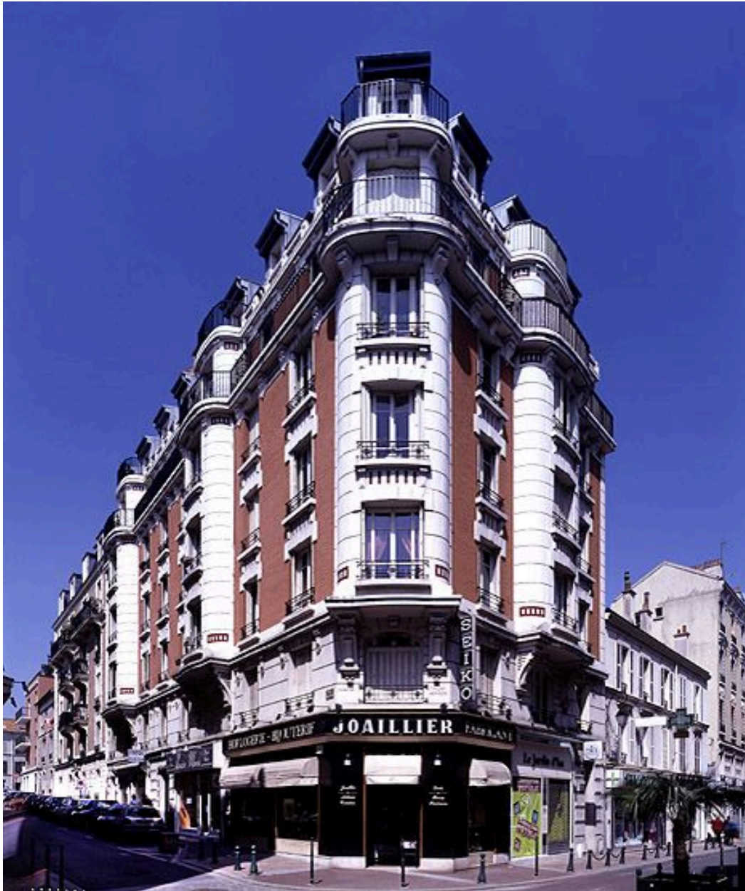
Immeuble à l'angle de la Grande rue Charles de Gaulle et de la rue Jules Ferry. Vue d'ensemble.
