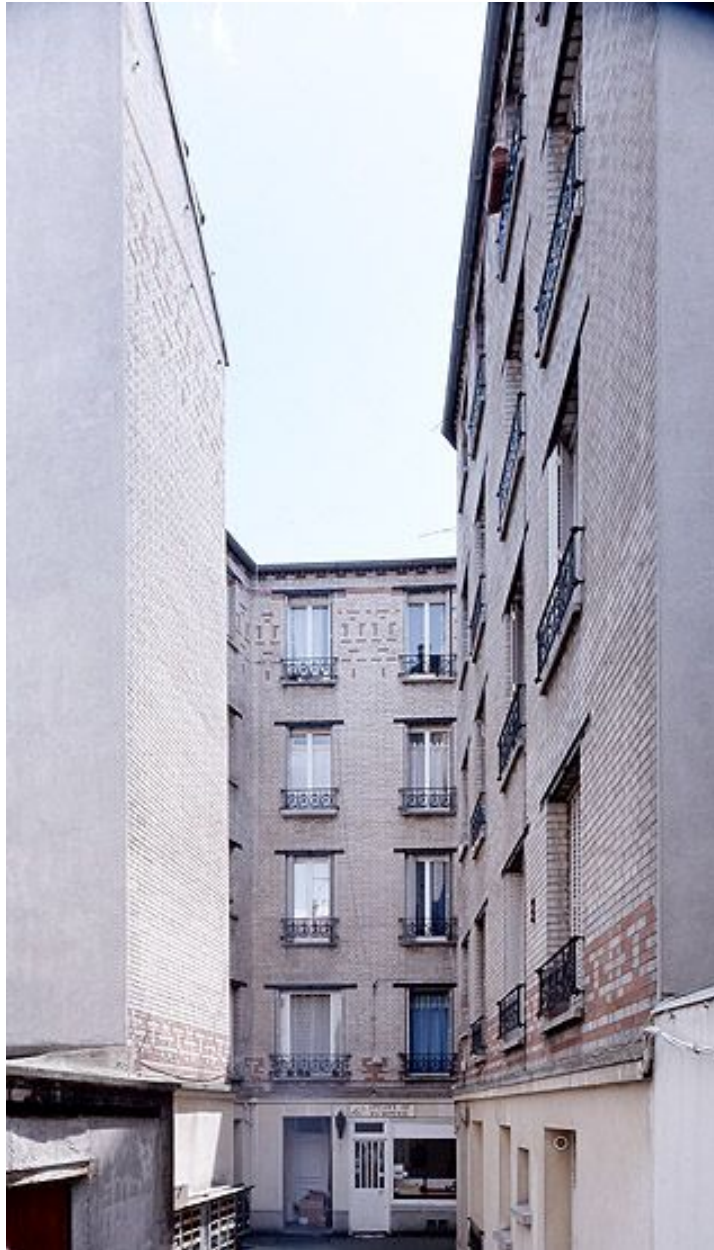
Vue d'ensemble depuis la cour d'un immeuble, 124 Grande rue Charles de Gaulle. La cour est si étroite qu'elle forme comme un boyau.
