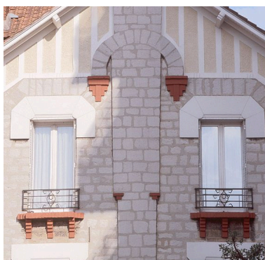
Détail d'un mur pignon et du conduit de cheminée d'une maison, 8 rue des Clamarts.
