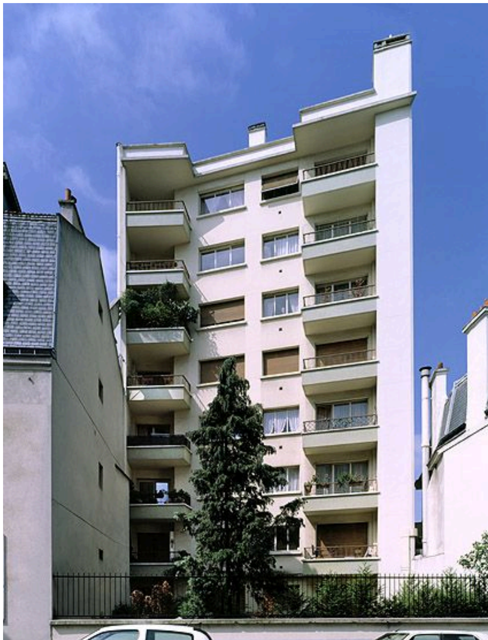
Immeuble dite résidence du bois, 4 place Pierre Sémard. Vue d'ensemble de la façade arrière sur le boulevard Gambetta.
