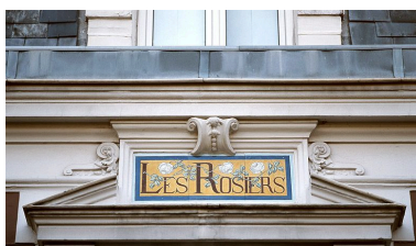
Détail des carreaux de céramique vernissée indiquant le nom de la maison "Les Rosiers", 53 avenue de Joinville. IVR11_20059400072XA
