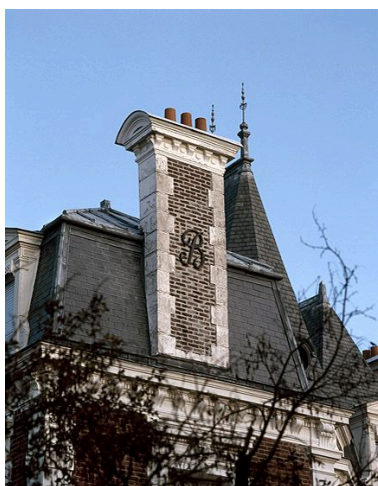
Détail d'une souche de cheminée, 6 avenue Odette. IVR11_20059400060XA
