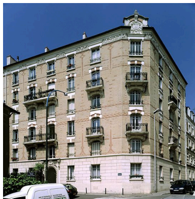
Immeuble, 11 rue de l'Abbé Guillaume. Vue d'ensemble. Phot. Stéphane Asseline IVR11_20049400114VA
