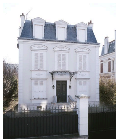
Vue d'ensemble d'une des maisons du lotissement de la rue Plisson. Phot. Stéphane Asseline IVR11_20059400114XA
