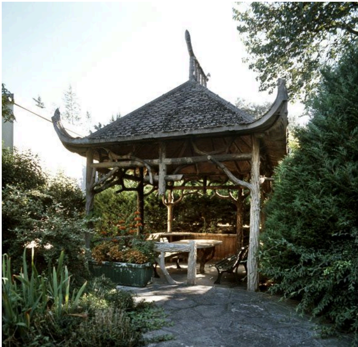
Fabrique de jardin en forme de pagode chinoise construite en béton imitant le bois, 95 rue des Héros Nogentais.
