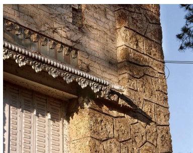
Maison de Georges Nachbaur, détail de gouttière ouvragée, 15 rue Lucien Bellivier. IVR11_20059400157XA
