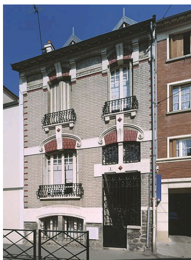
Maison, 1 rue Thiers. Vue d'ensemble.
