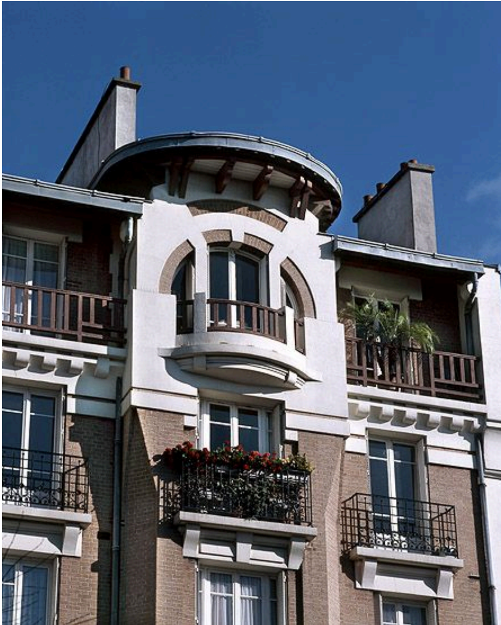
Immeuble, 3 rue Victor Hugo. Détail des loggias en partie haute.
