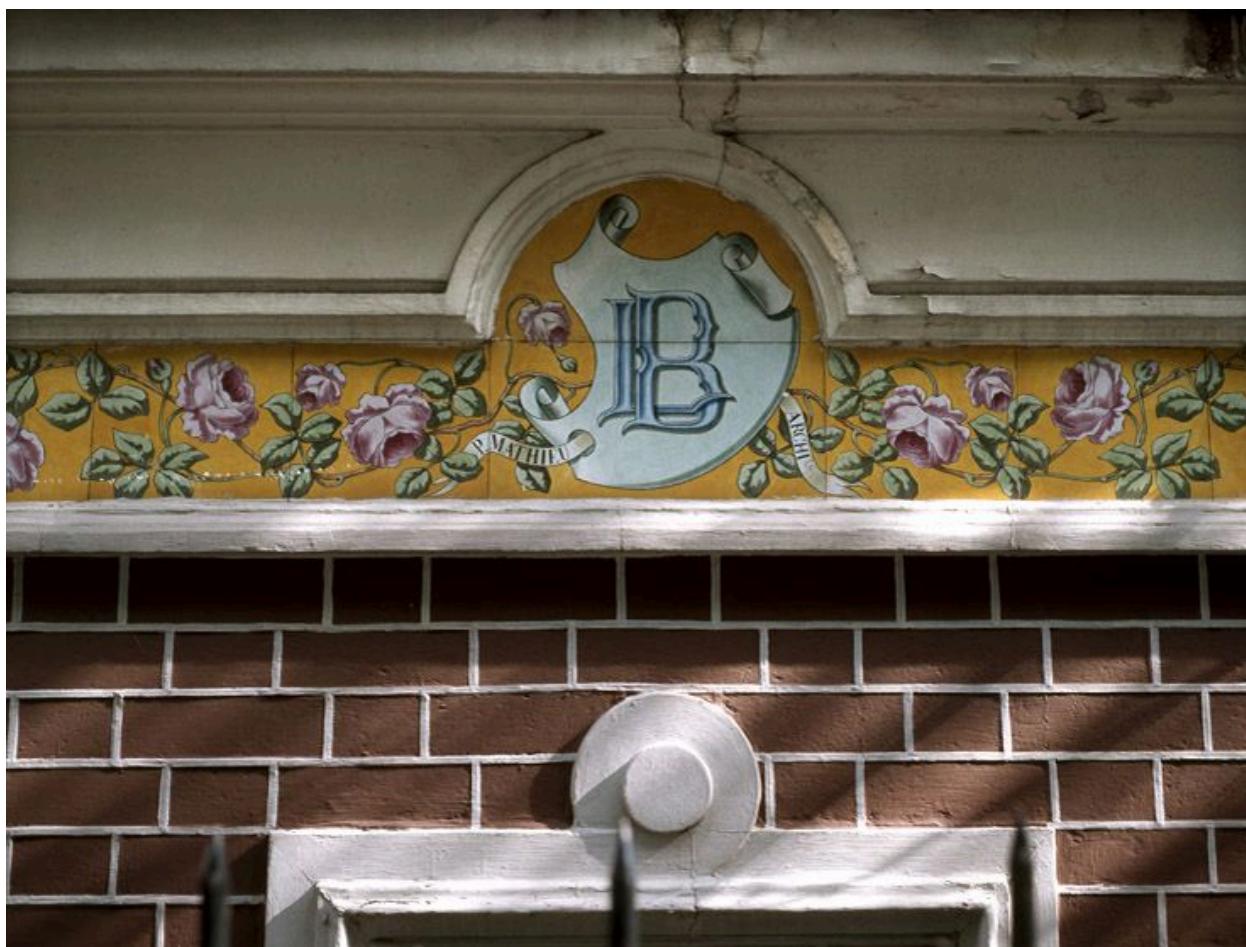
Détail des carreaux de céramique vernissée d'une maison, 53 avenue de Joinville.
