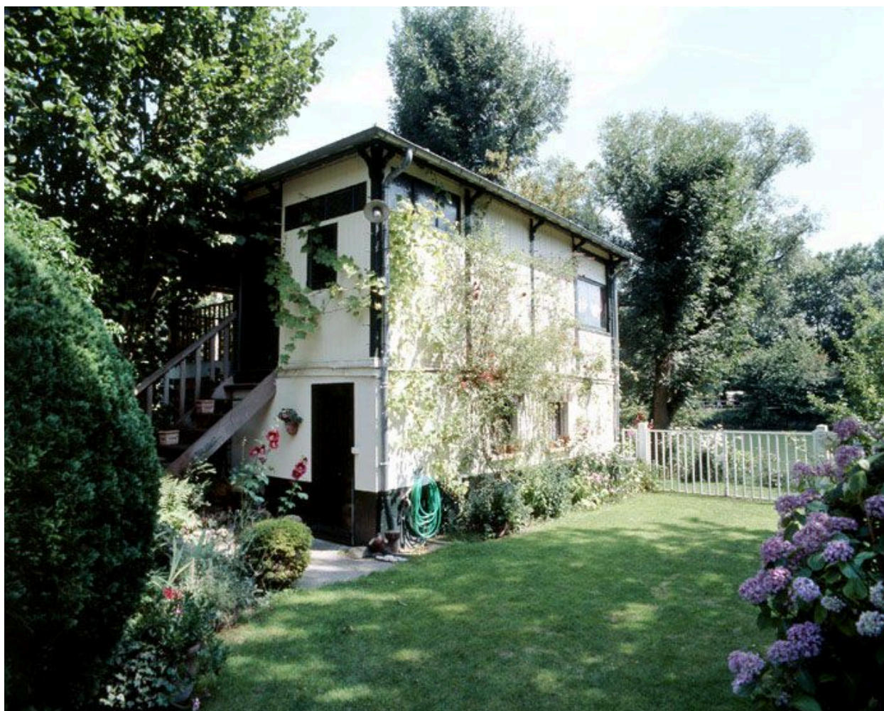
Maison, 46 île de Beauté. Vue du pavillon dans le jardin surplombant la Marne.
