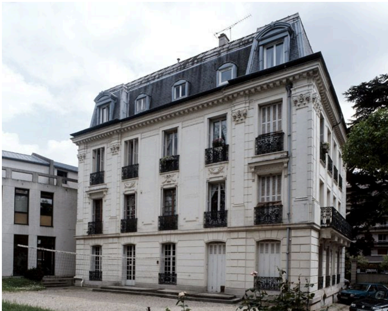
Demeure accueillant aujourd'hui un institut biblique, 39 Grande rue Charles de Gaulle. Vue d'ensemble de la façade sur le jardin.
