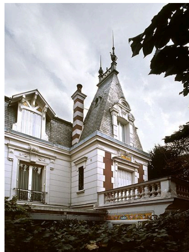
Maison, 53 avenue de Joinville. Vue depuis la rue. Phot. Laurent Kruszyk IVR11_20049400603XA
