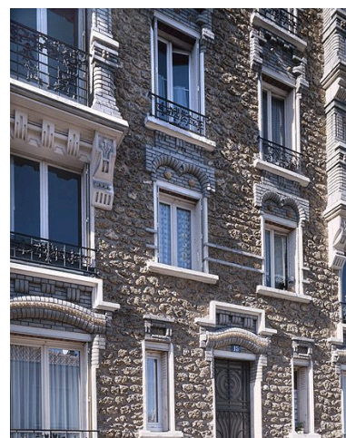
Immeuble, 15 rue Guy Moquet. Vue de la partie basse de la façade. Phot. Stéphane Asseline IVR11_20049400788VA
