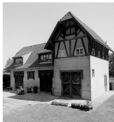
Vue d'ensemble de la maison du gardien construite dans le style norvégien. Phot. Décamps Christian IVR11_20007800429X
