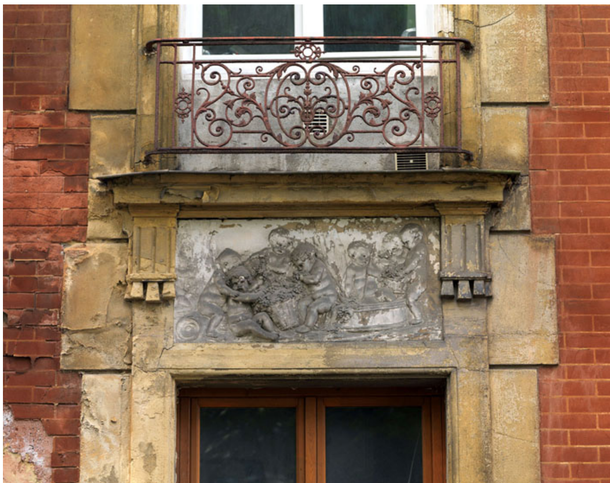
Détail d'un des bas-reliefs en stuc de la façade : putti faisant du vin, sur la travée de gauche.
