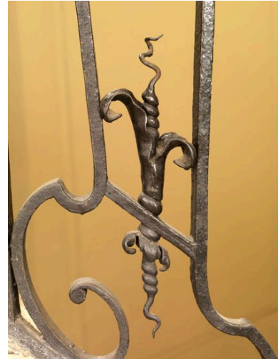
Détail d'un pilastre : une queue de cochon émergeant d'un fleuron. Phot. Philippe Ayrault IVR11_20107500293NUC4A
