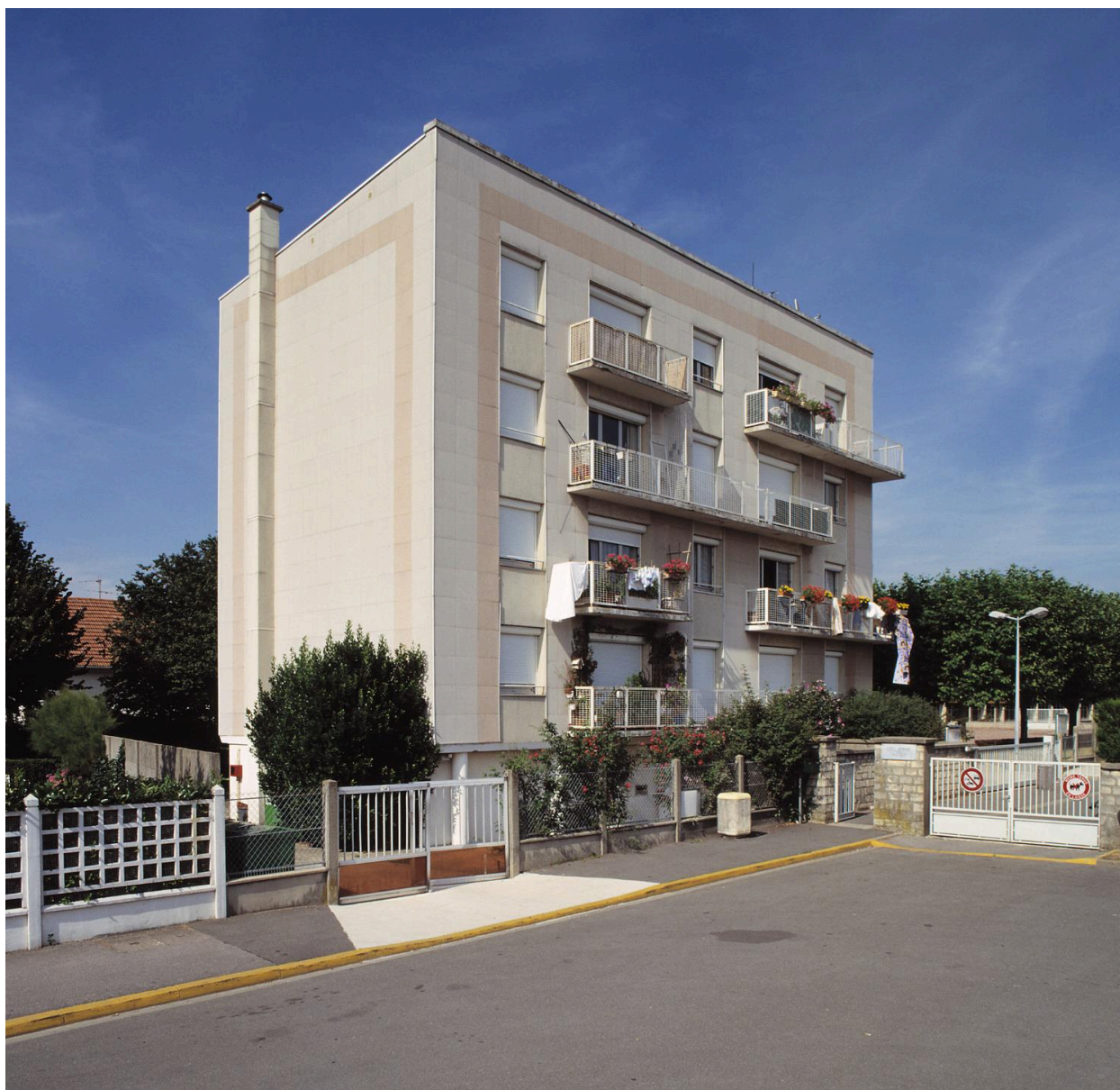
Vue du bâtiment abritant les logements des instituteurs situé à l'entrée du périmètre de l'école.
