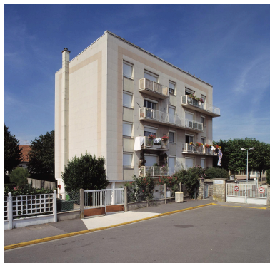
Vue du bâtiment abritant les logements des instituteurs situé à l'entrée du périmètre de l'école.
