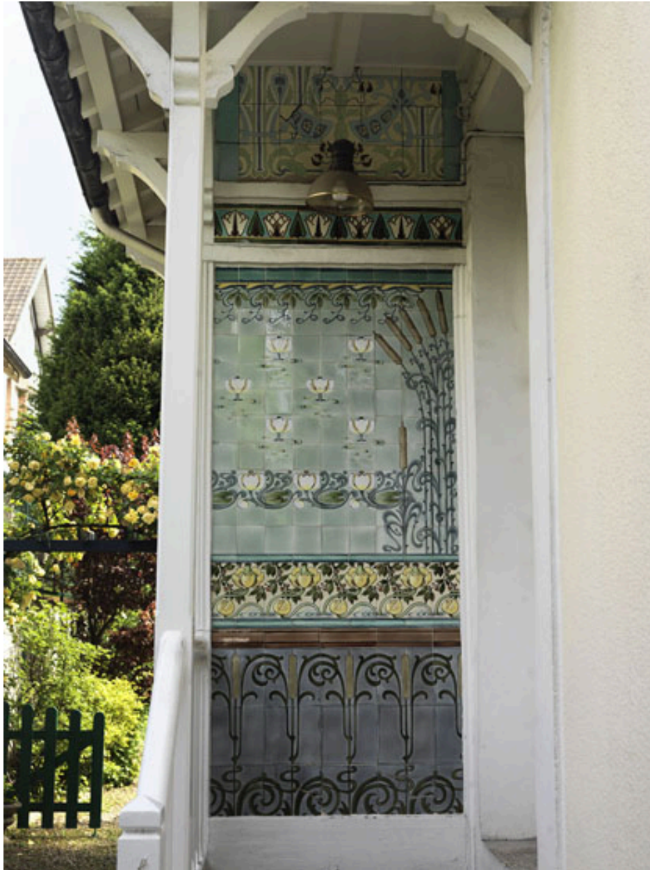
Détail du panneau de faïence ornant le perron d'entrée, vraisemblablement produit par la manufacture de Choisy-le-Roi.
