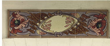
Détail du panneau de faïence ornant le dessous de la corniche, au niveau du premier étage, au-dessus du perron d'entrée. Phot. Jean-Bernard Vialles IVR11_20089500162NUC4A
