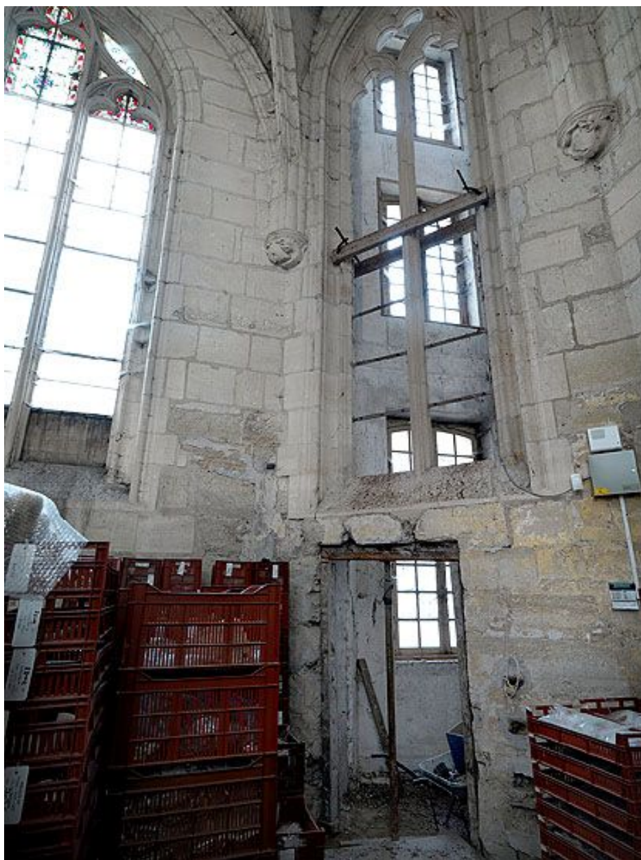
Détail du pan coupé nord de l'abside.
