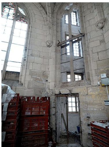
Détail du pan coupé nord de l'abside. Phot. Jean-Bernard Vialles IVR11_20127700976NUC4A
