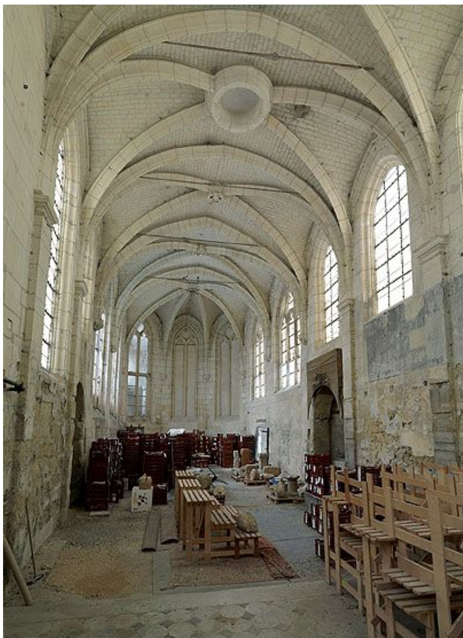
Vue intérieure générale, depuis l'ouest.
