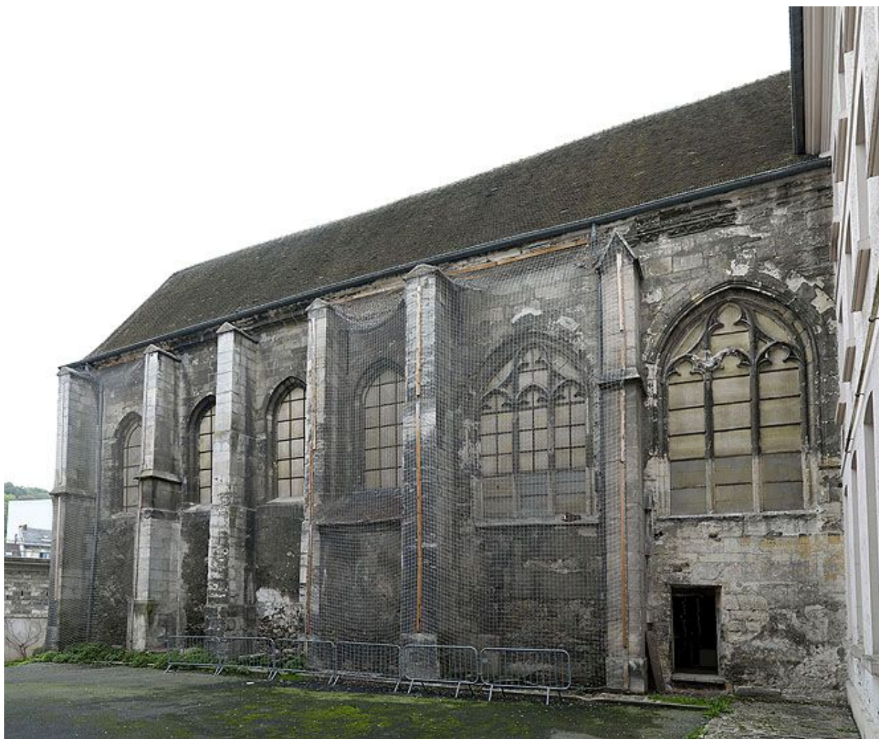
Vue extérieure : élévation sud, vue du sud-est.
