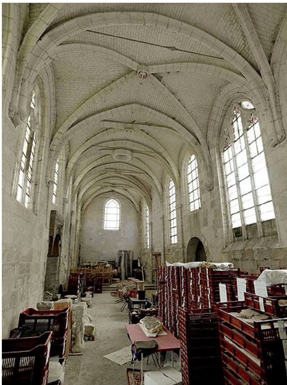
Vue intérieure générale, depuis l'est.
