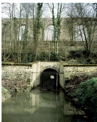
Vue de la Bièvre à la sortie du tunnel qui passe sous l'aqueduc. Phot. Christian Décamps IVR11_20007800164XA
