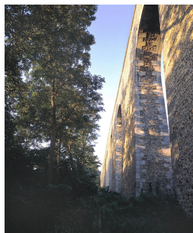
Vue des arcades en contre-plongée. Phot. Stéphane Asseline IVR11_20017800057XA
