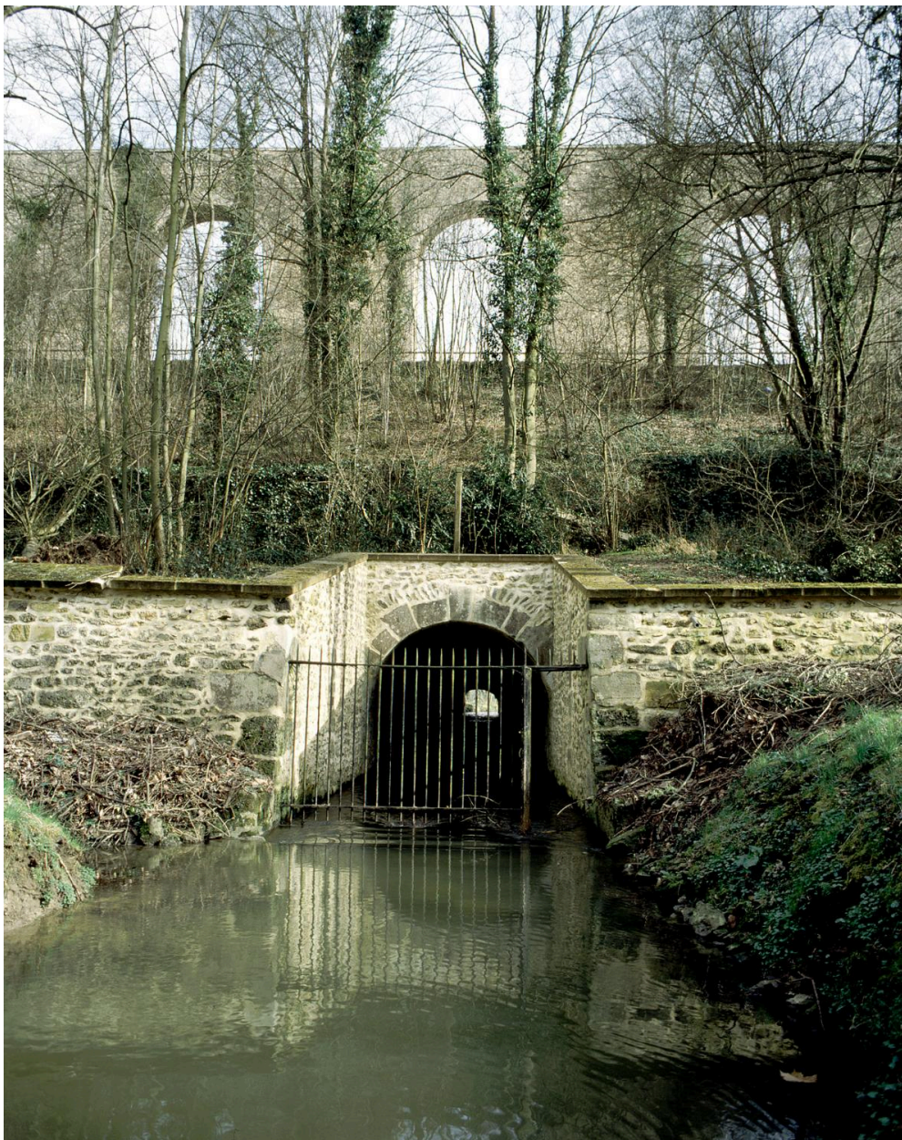
Vue de la Bièvre à la sortie du tunnel qui passe sous l'aqueduc.
