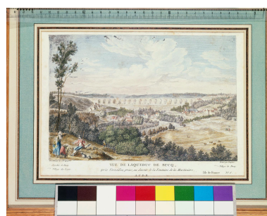
Vue de l'aqueduc de Buc. Phot. Jean-Bernard Vialles IVR11_19817800122VA
