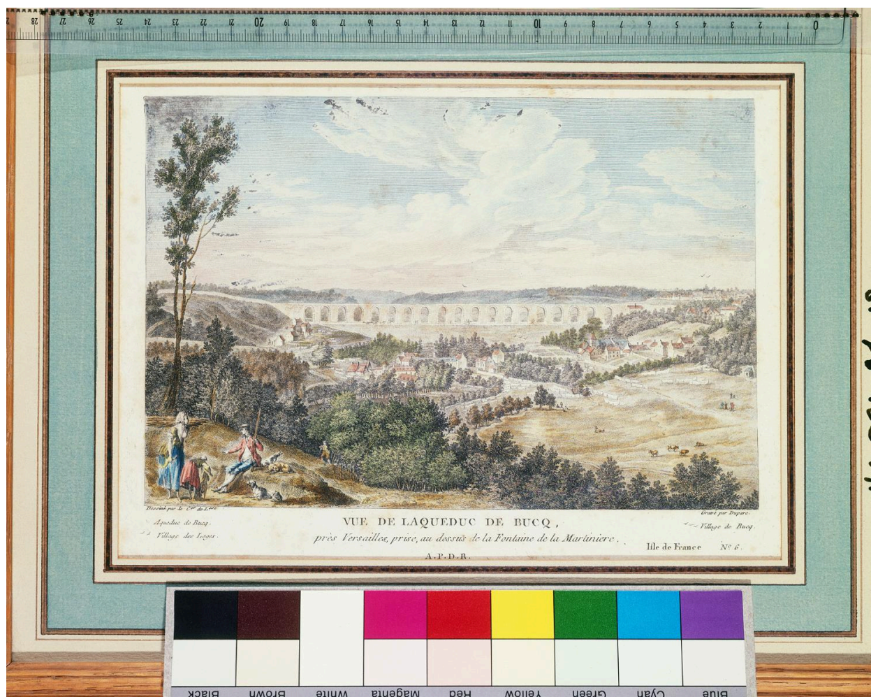
Vue de l'aqueduc de Buc.
