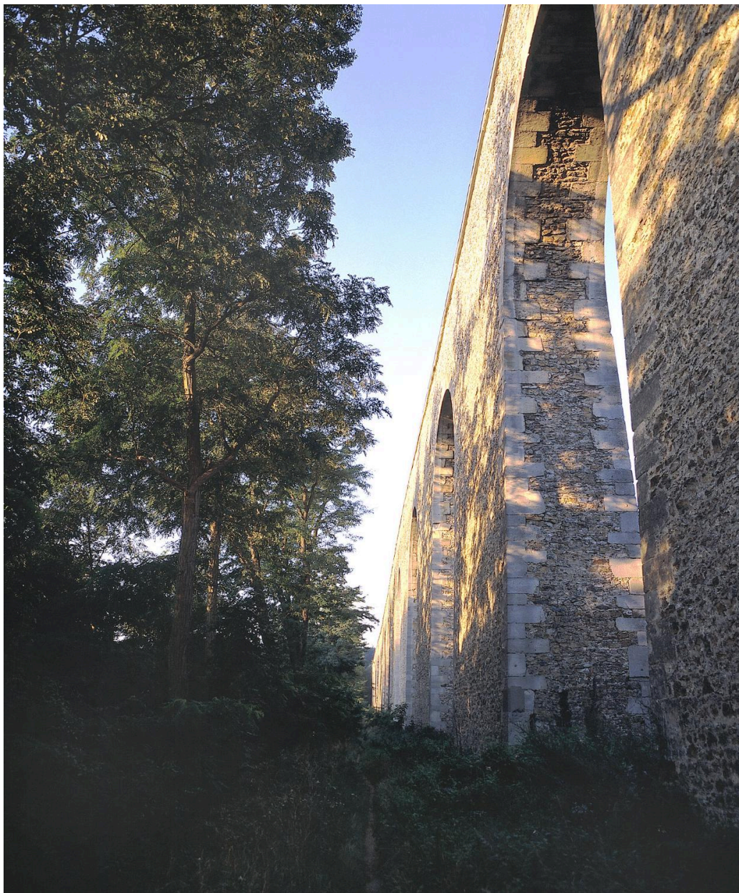
Vue des arcades en contre-plongée.
