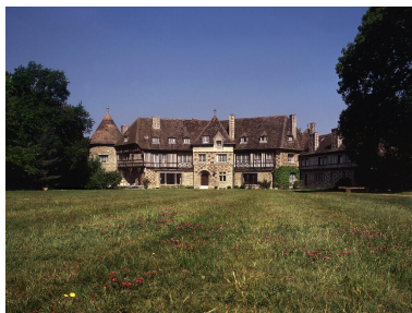
Vue d'ensemble, façade sur jardin. Phot. Vialles Jean-Bernard IVR11_20027800188XA
