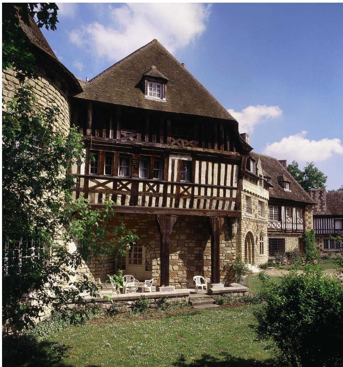
Détail de l'un des pignons.
