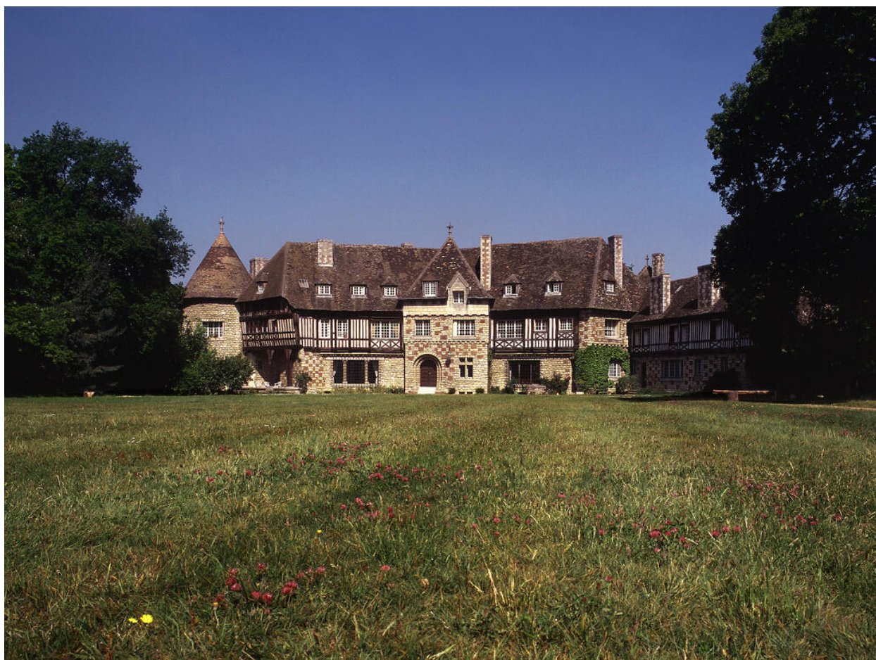
Vue d'ensemble, façade sur jardin.
