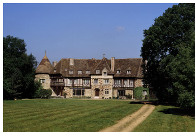
Vue d'ensemble, façade sur jardin. Phot. Vialles Jean-Bernard IVR11_20027800186XA
