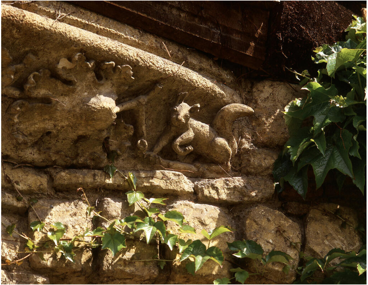
Détail de la frise sculptée aux motifs animaliers située sur la corniche en dessous de l'étage en léger surplomb.
