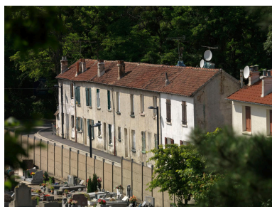
Alignement d'anciennes maisons de carriers en contrebas du cimetière.
