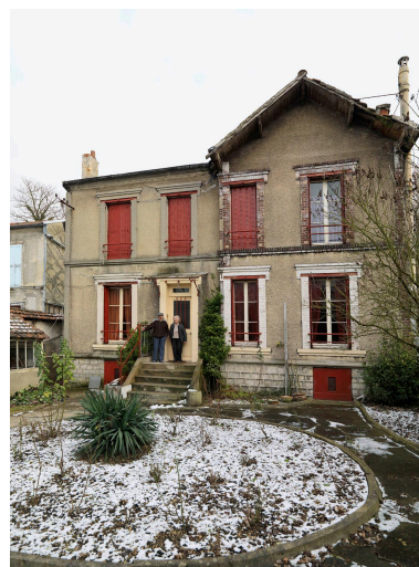
Maison des contremaîtres des carrières du parc.
