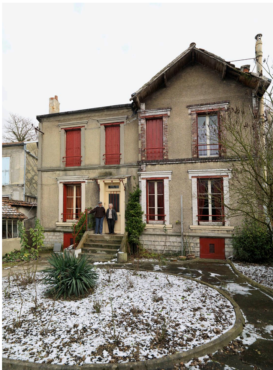
Maison des contremaîtres des carrières du parc.
