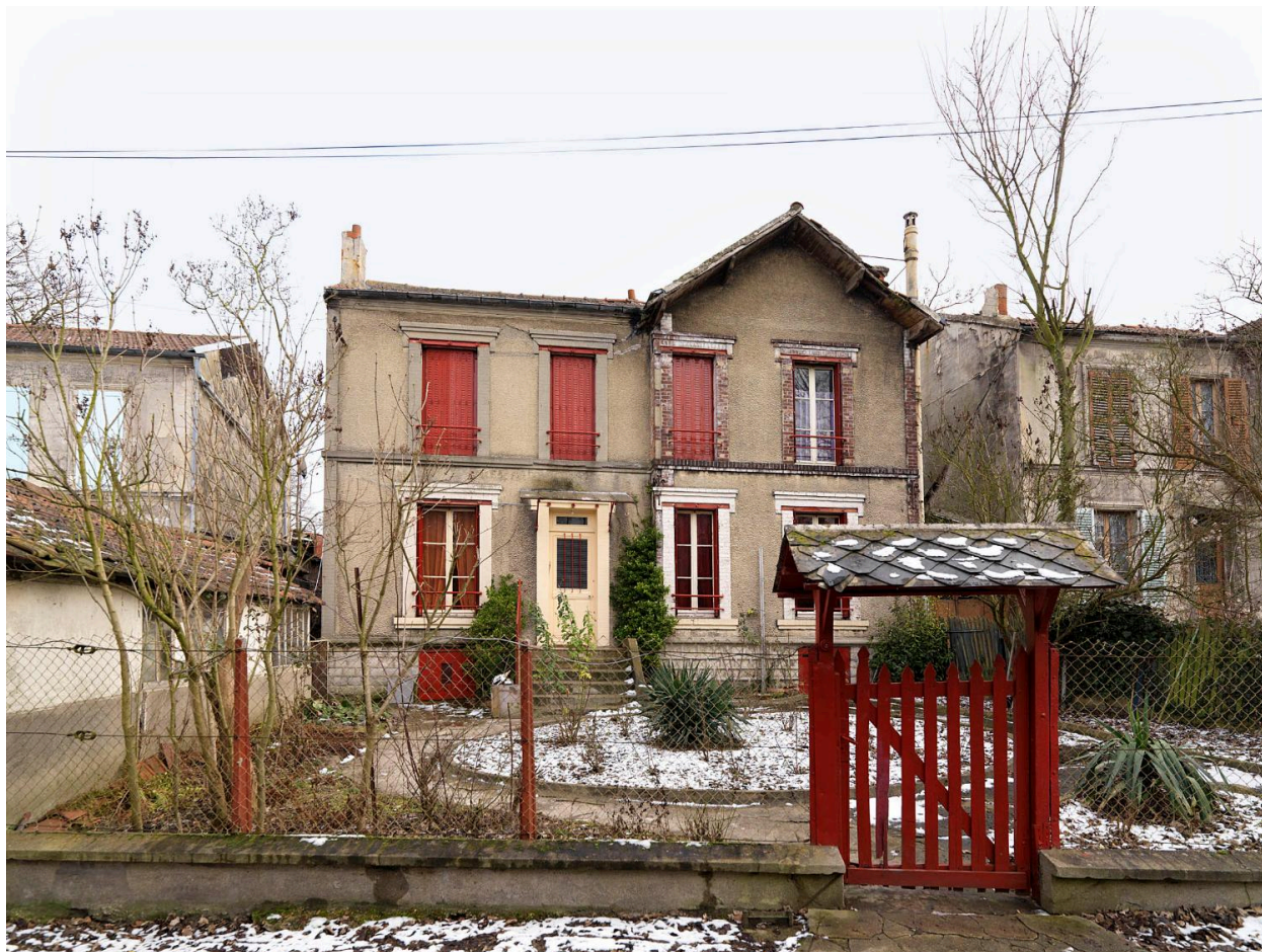
Maison des contremaîtres des carrières du parc.
