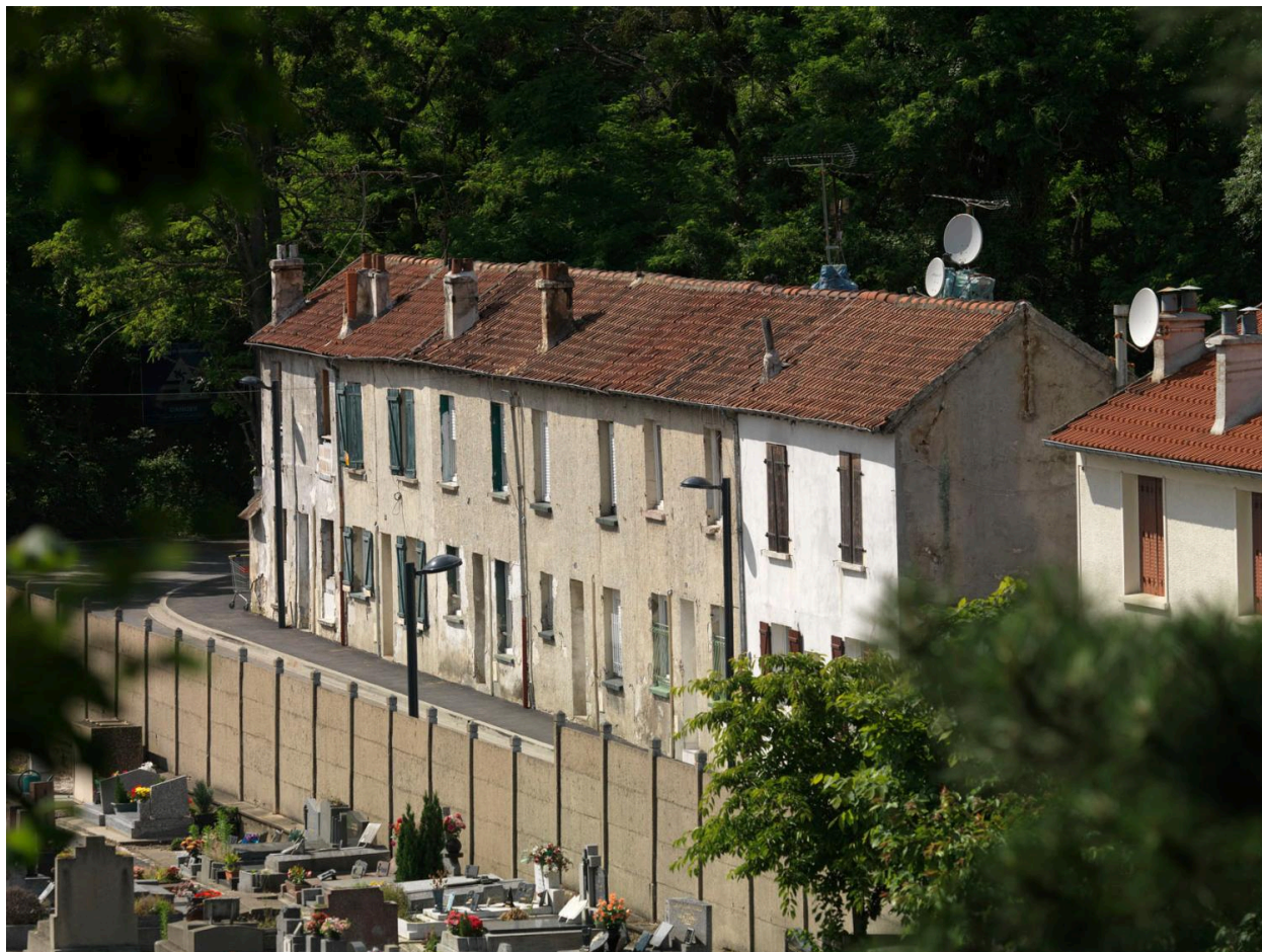
Alignement d'anciennes maisons de carriers en contrebas du cimetière.
