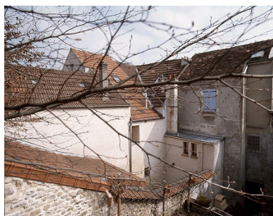
Vue d'ensemble du mur ouest de l'aile en retour. Phot. Philippe Ayrault IVR11_20067800305XA
