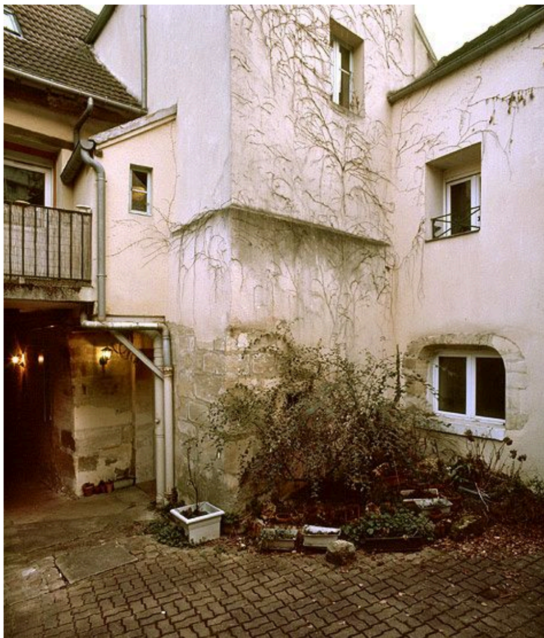
Vue d'ensemble de la cour arrière.
