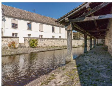
Le lavoir de la Bonde, vue depuis le sud-ouest. Phot. Asseline Stéphane IVR11_20259100136NUC4A
