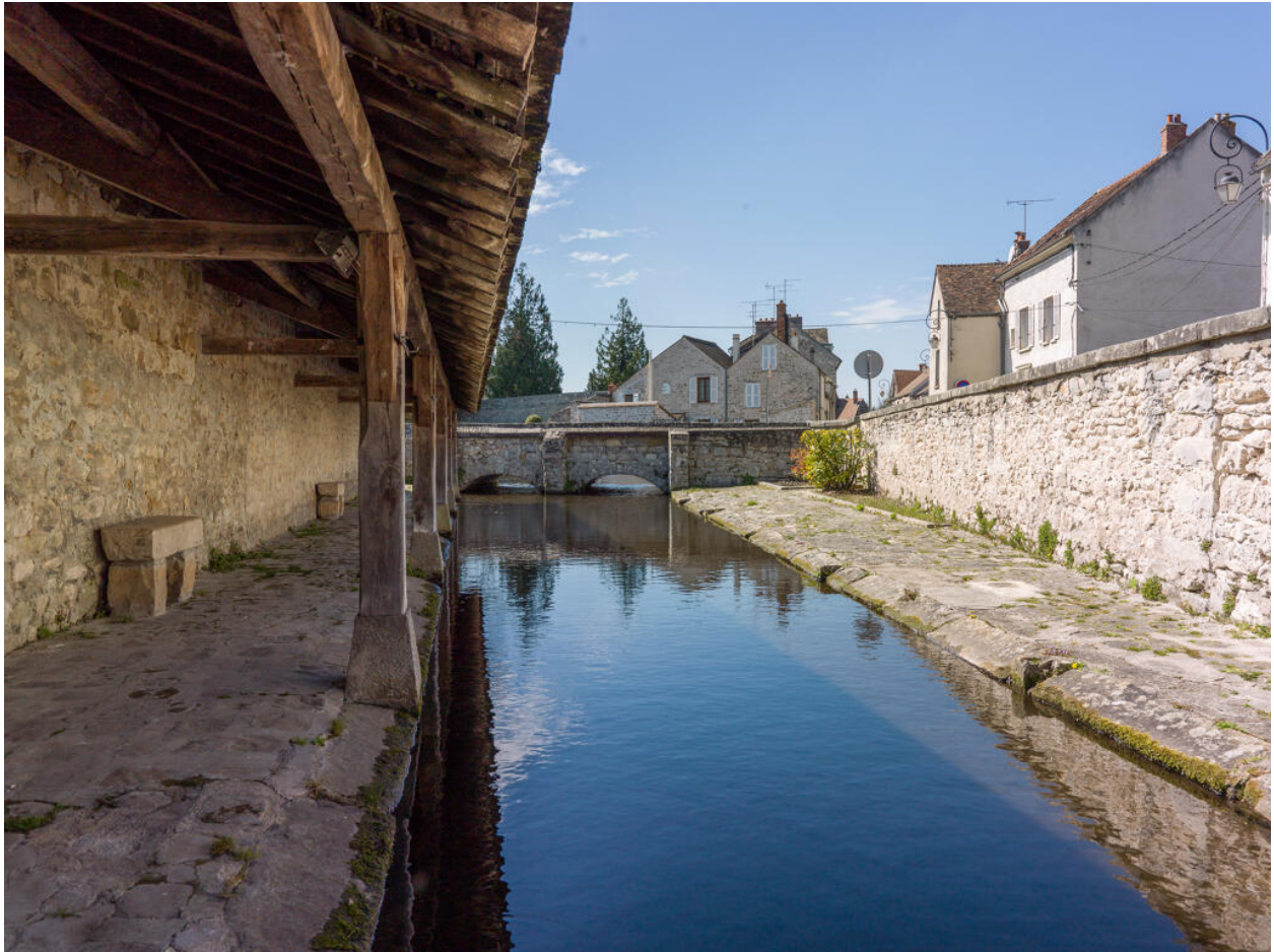
Le lavoir de la Bonde, vue depuis le sud-est.
