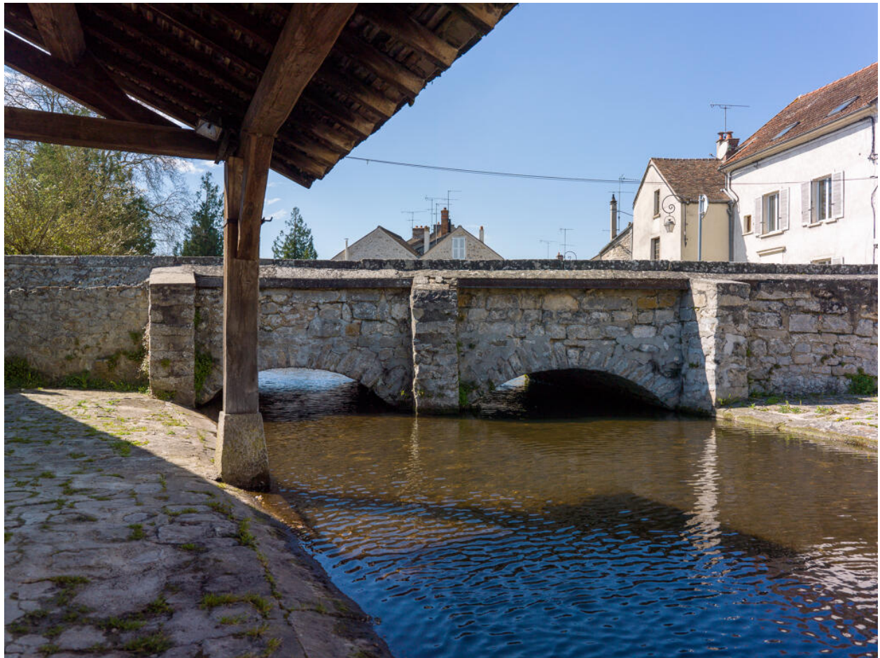
Le "pont de la Bonde", vue depuis le lavoir (depuis le sud-est).
