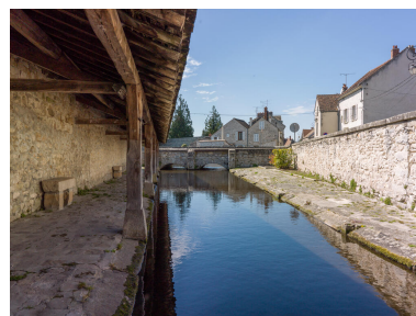
Le lavoir de la Bonde, vue depuis le sud-est. Phot. Asseline Stéphane IVR11_20259100135NUC4A
