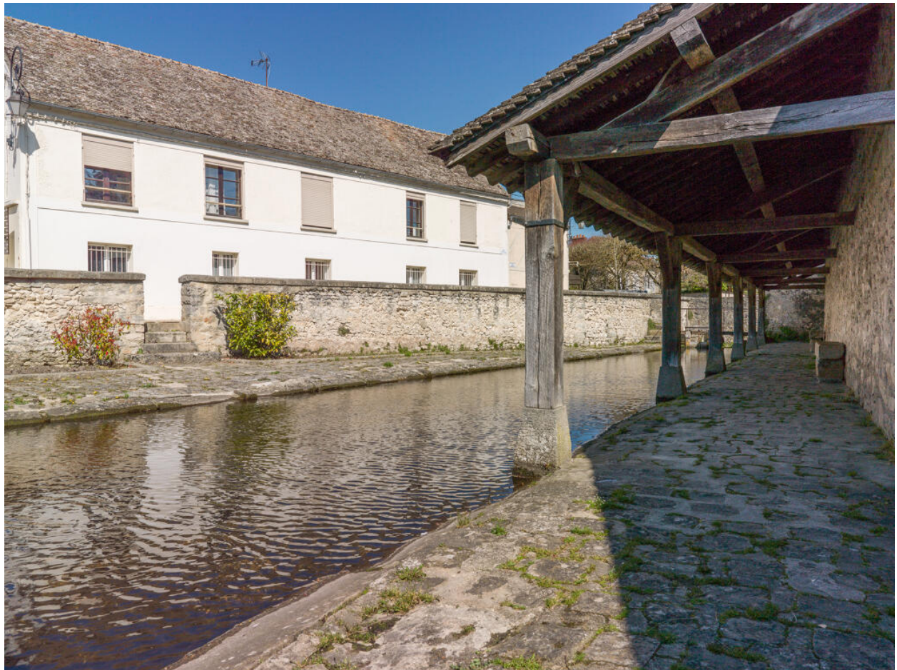
Le lavoir de la Bonde, vue depuis le sud-ouest.
