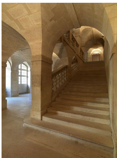
Le premier escalier d'honneur, vue d'ensemble. Phot. Laurent Kruszyk IVR11_20097500838NUC4A
