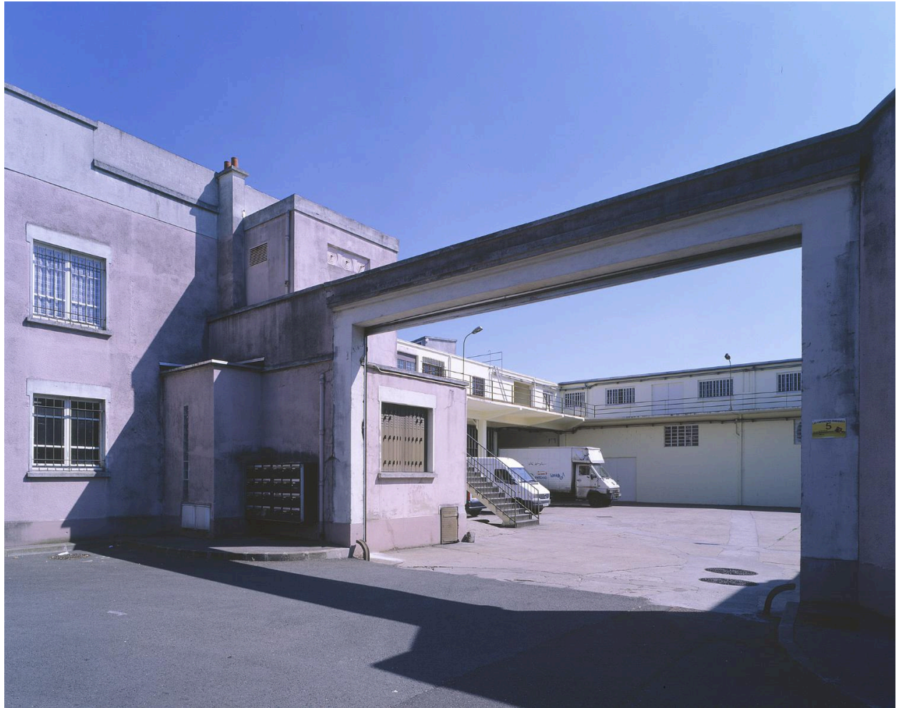
Vue du portail d'entrée et de la cour centrale.
