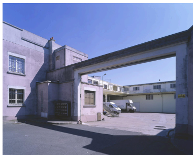
Vue du portail d'entrée et de la cour centrale. Phot. Philippe Ayrault IVR11_20039100944VA
