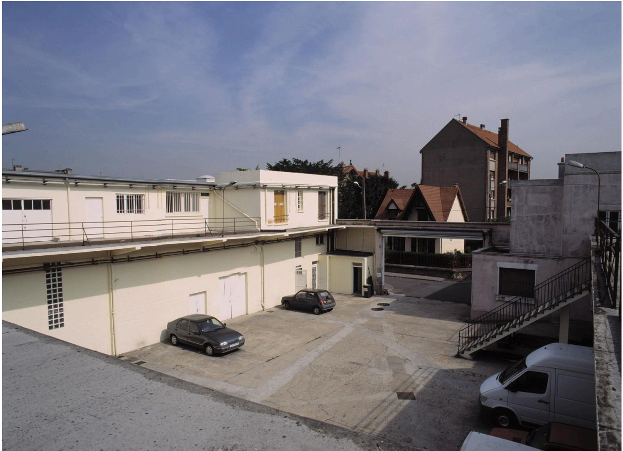
La cour intérieure, en direction du portail d'entrée.
