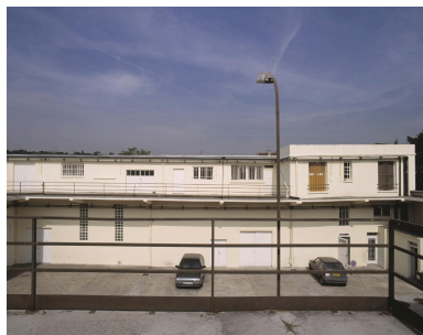
Vue de la façade ouest sur la cour intérieure. Phot. Philippe Ayrault IVR11_20039101007XA
