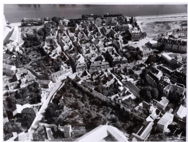
Les îlots des Bas Quartiers détruits pour laisser place aux résidences de la Tour et Saint-Maclou. (Fonds CREDOP. Cliché Bertin)
