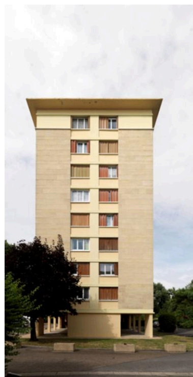
La tour de la Résidence de la Tour. Façade latérale. Phot. Laurent Kruszyk IVR11_20167800384NUC4A
