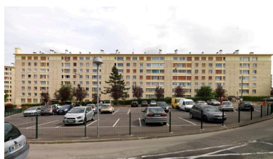
La barre de la résidence de la Tour : façade arrière. Phot. Laurent Kruszyk IVR11_20167800375NUC4A
