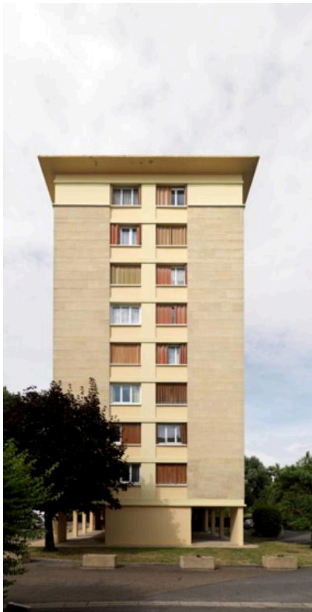
La tour de la Résidence de la Tour. Façade latérale.
