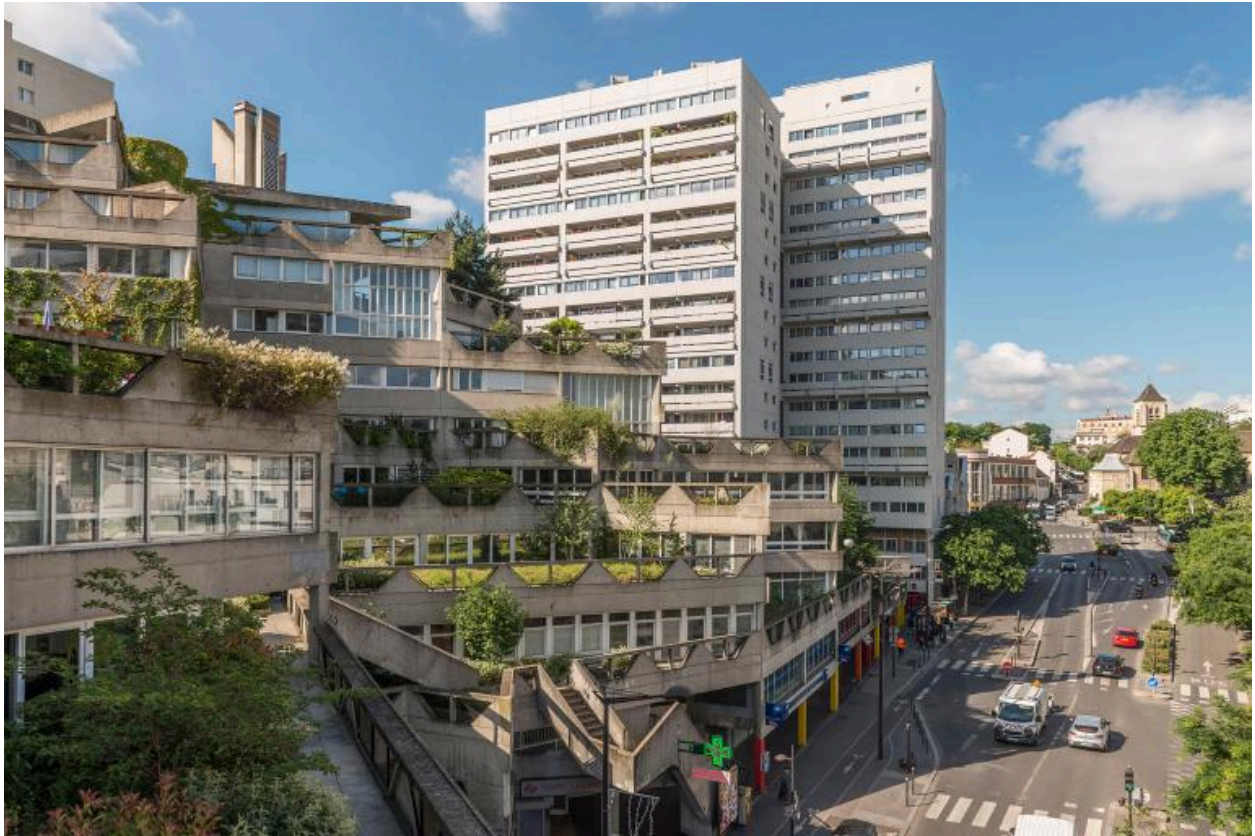
Vue générale de l'ensemble de logements "Jeanne Hachette"
