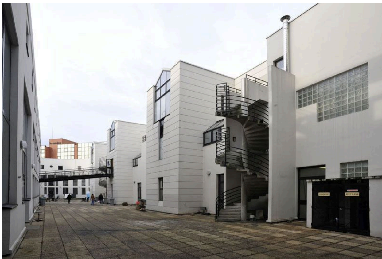
Vue d'ensemble de l'une des façades sur voie piétonne.
