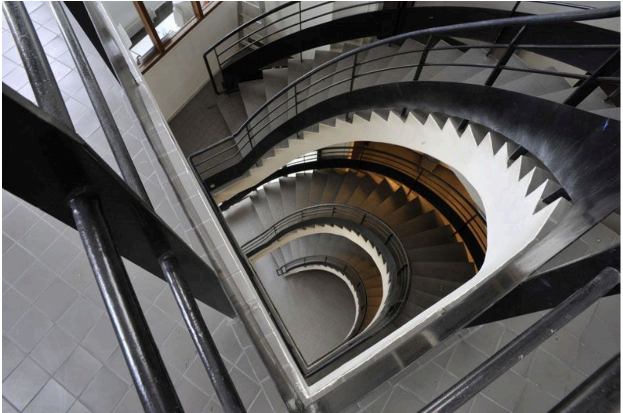
Vue d'ensemble de l'escalier.
