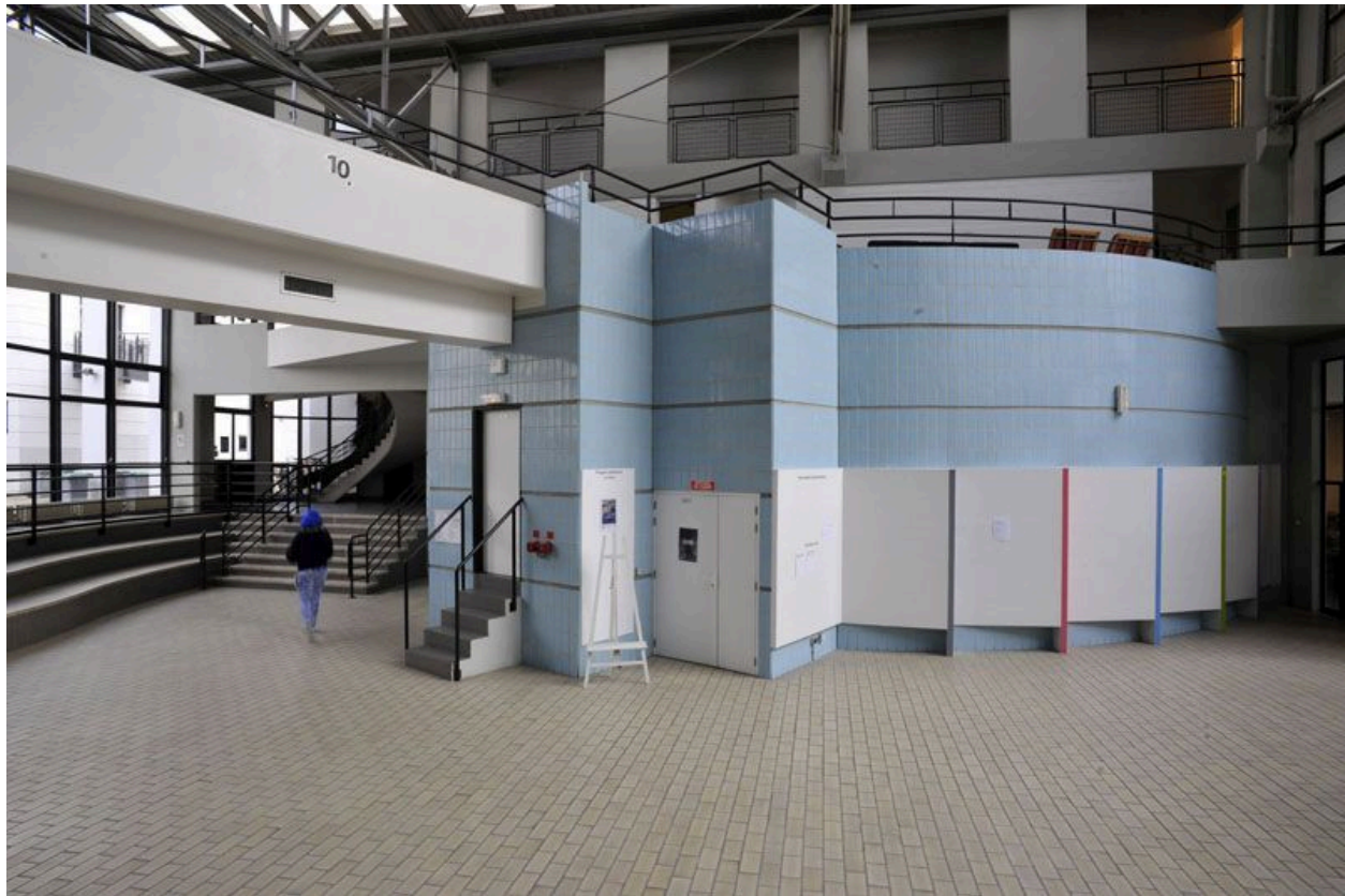
Vue d'ensemble du hall d'entrée de l'édifice.
