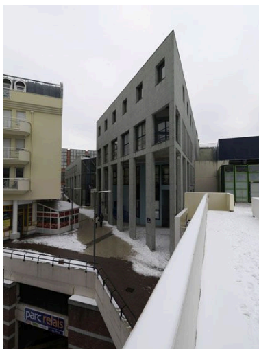
Vue d'ensemble de la partie angulaire de l'édifice. Phot. Philippe Ayrault IVR11_20129500036NUC4A
