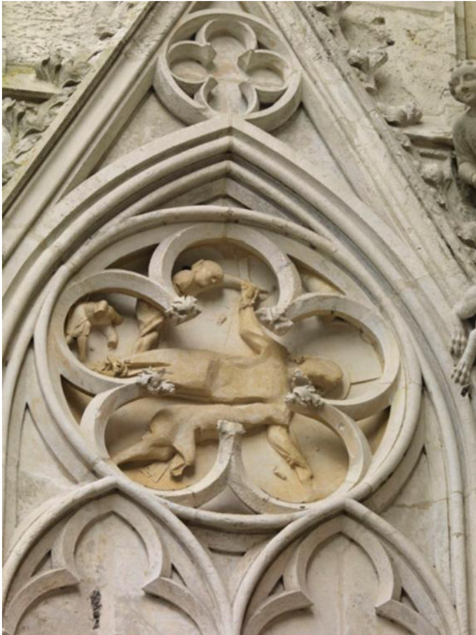
Décor des contreforts : le martyre d'un saint écartelé.
