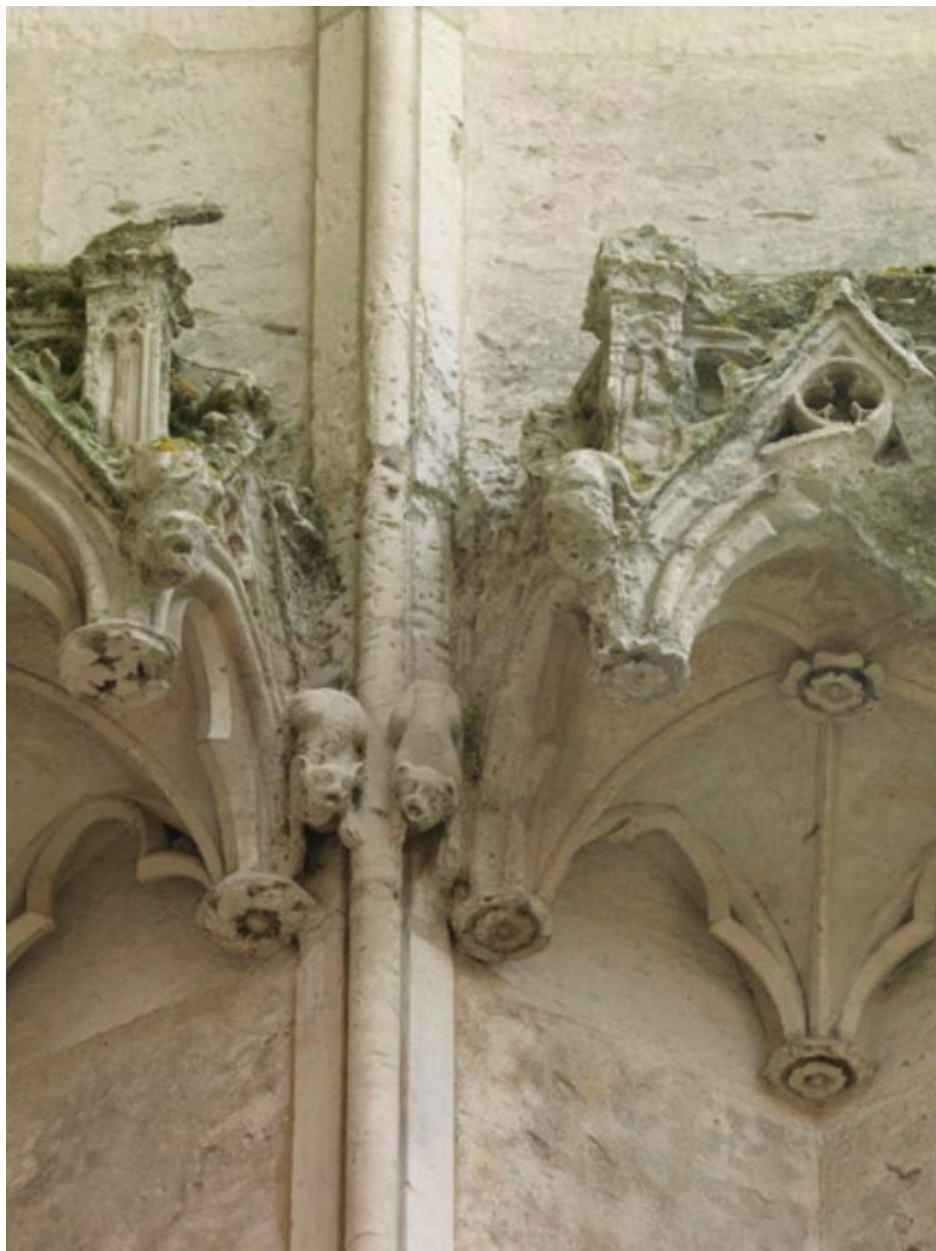
Détail du décor des dais qui surmontaient les statues.
