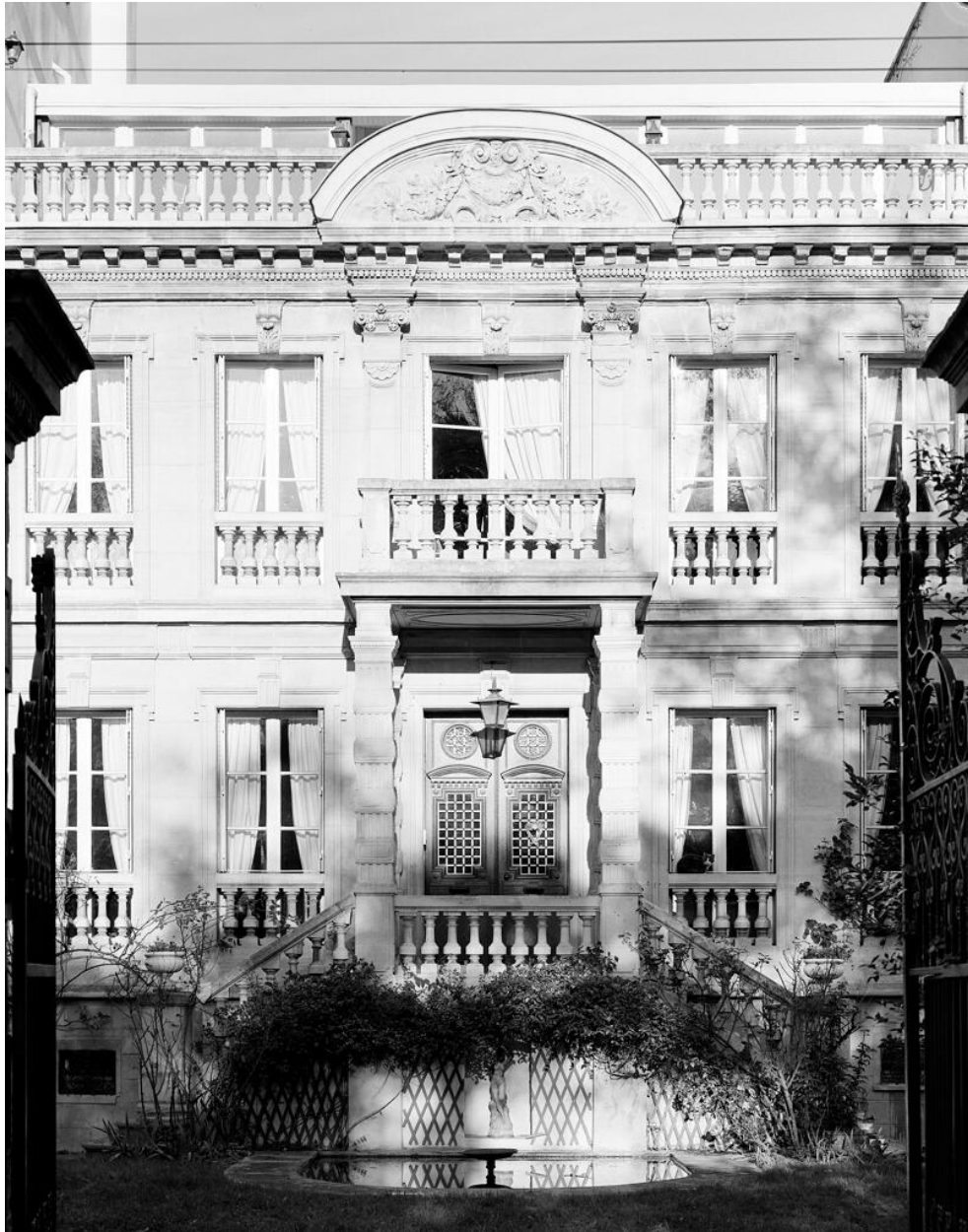
Détail de la travée centrale.
