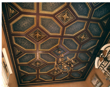
Plafond de la salle à manger. Phot. Vialles Jean-Bernard IVR11_19997800601XA
