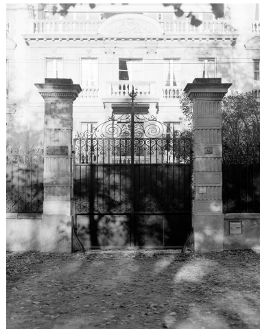
Vue du portail. Phot. Vialles Jean-Bernard IVR11_19897800752X
