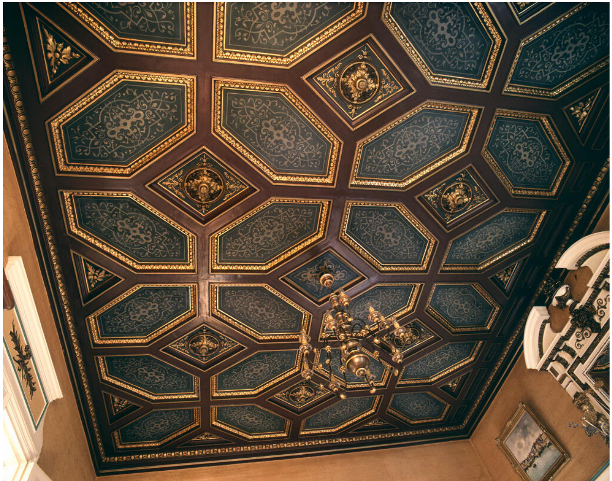
Plafond de la salle à manger.
