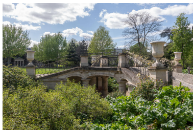
Le pont de pierre, vue d'ensemble. Phot. Kruszyk Laurent IVR11_20249200017NUC4A
