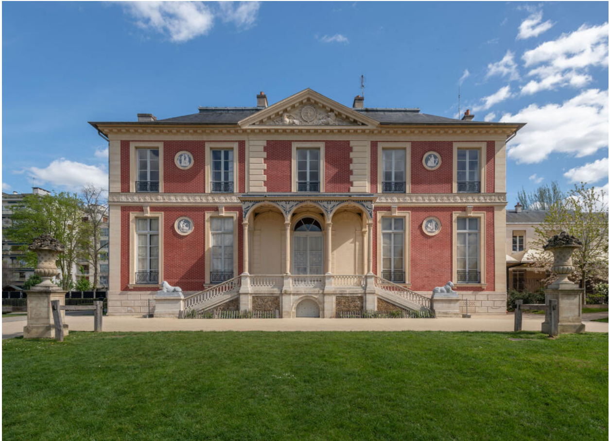
Vue d'ensemble de la façade sur jardin, orientée ouest.
