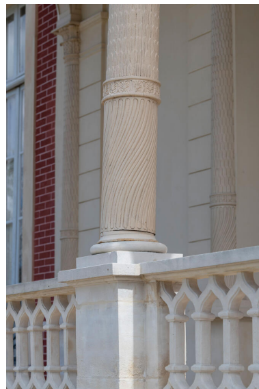
Façade ouest, détail d'une colonne en bois sculpté du portique. Une bague composée de palmettes sépare la partie supérieure du fût, orné d'écailles, de la partie inférieure à stryges. Phot. Kruszyk Laurent IVR11_20249200033NUC4A
