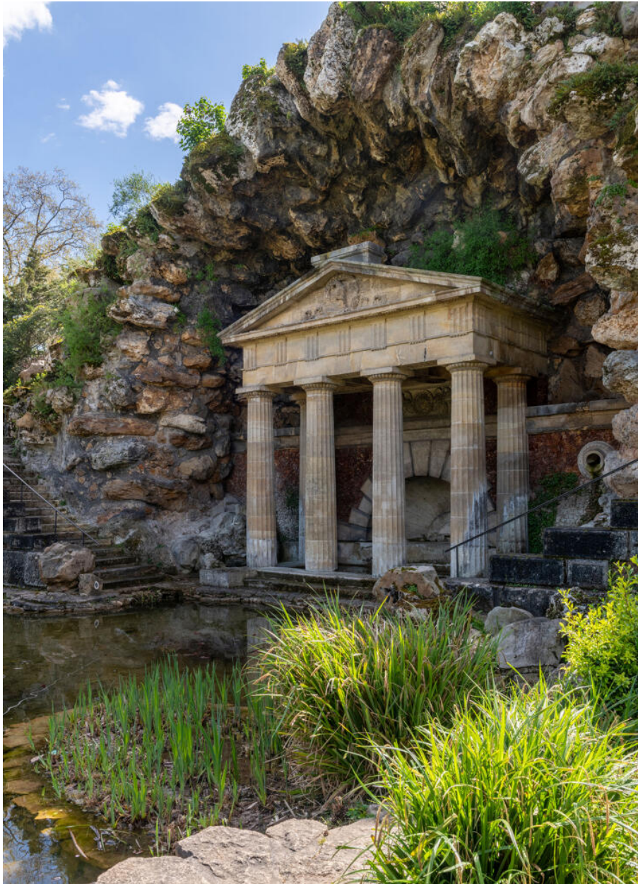
Le Grand rocher : derrière la colonne se trouve le réservoir et la "salle de bain".
