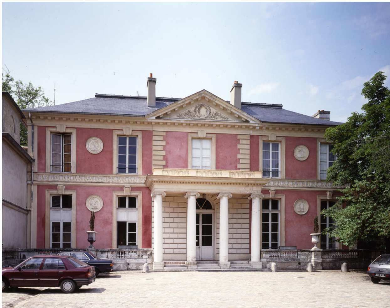
La façade sur cour
