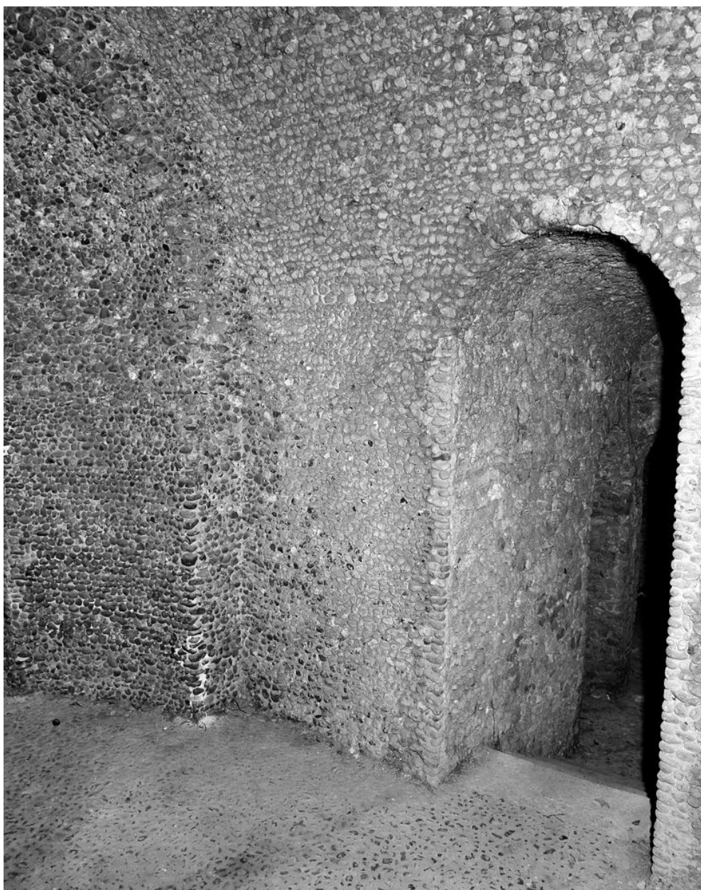
Grand rocher. Galerie de droite à revêtement de galets.
