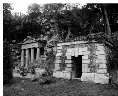
Le Grand rocher. Détail de l'accès à la galerie ouest. Phot. Vialles Jean-Bernard IVR11_19929201440X
