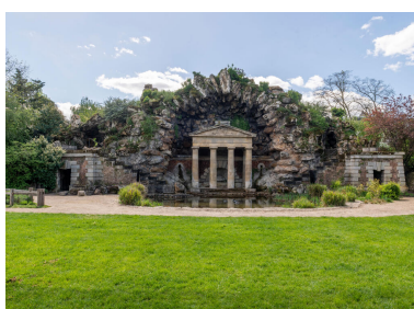
Le Grand rocher, vue d'ensemble. Les pavillons latéraux constituent l'accès à deux galeries. Au centre se trouve une salle de bains, sommée d'un réservoir. Phot. Kruszyk Laurent IVR11_20249200021NUC4A
