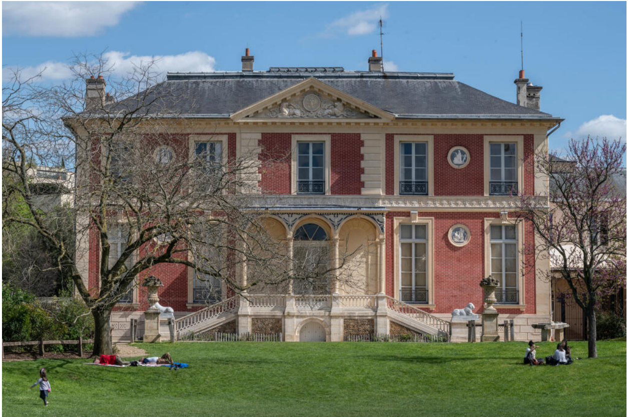
Vue d'ensemble de la façade sur jardin, orientée ouest.
