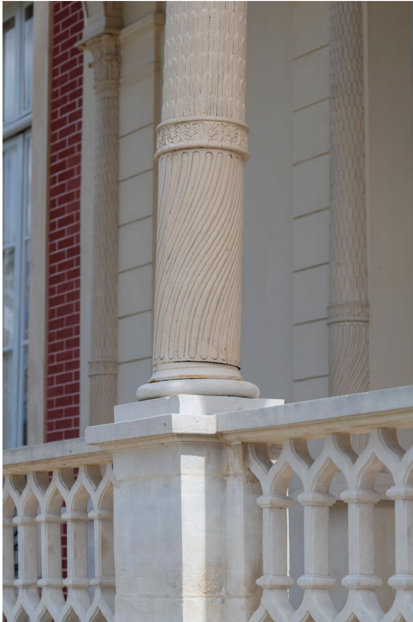
Façade ouest, détail d'une colonne en bois sculpté du portique. Une bague composée de palmettes sépare la partie supérieure du fût, orné d'écailles, de la partie inférieure à stryges.
