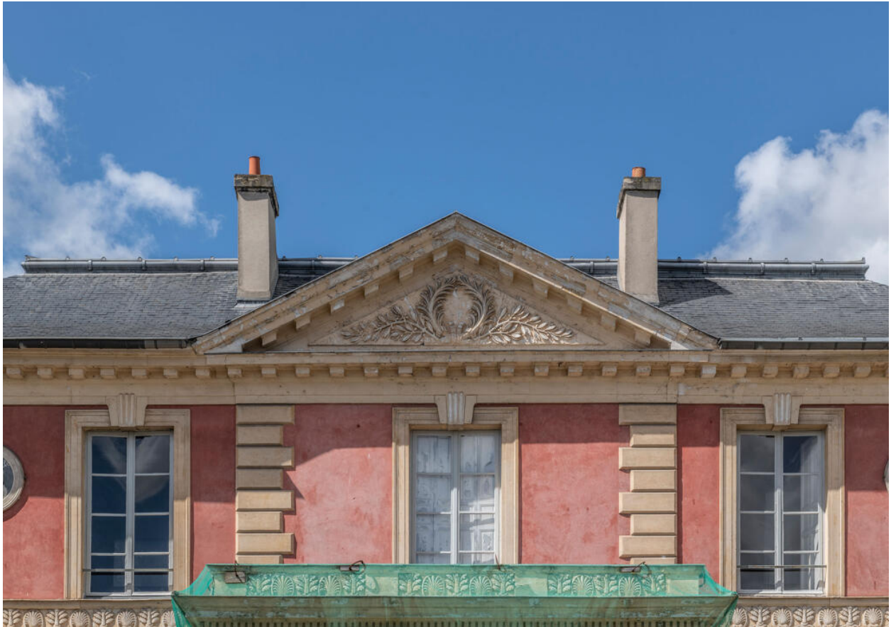
La façade sur cour, côté est. Détail du fronton à décor de lauriers.
