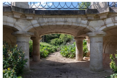
Fabriques. Le pont de pierre. Phot. Kruszyk Laurent IVR11_20249200018NUC4A
