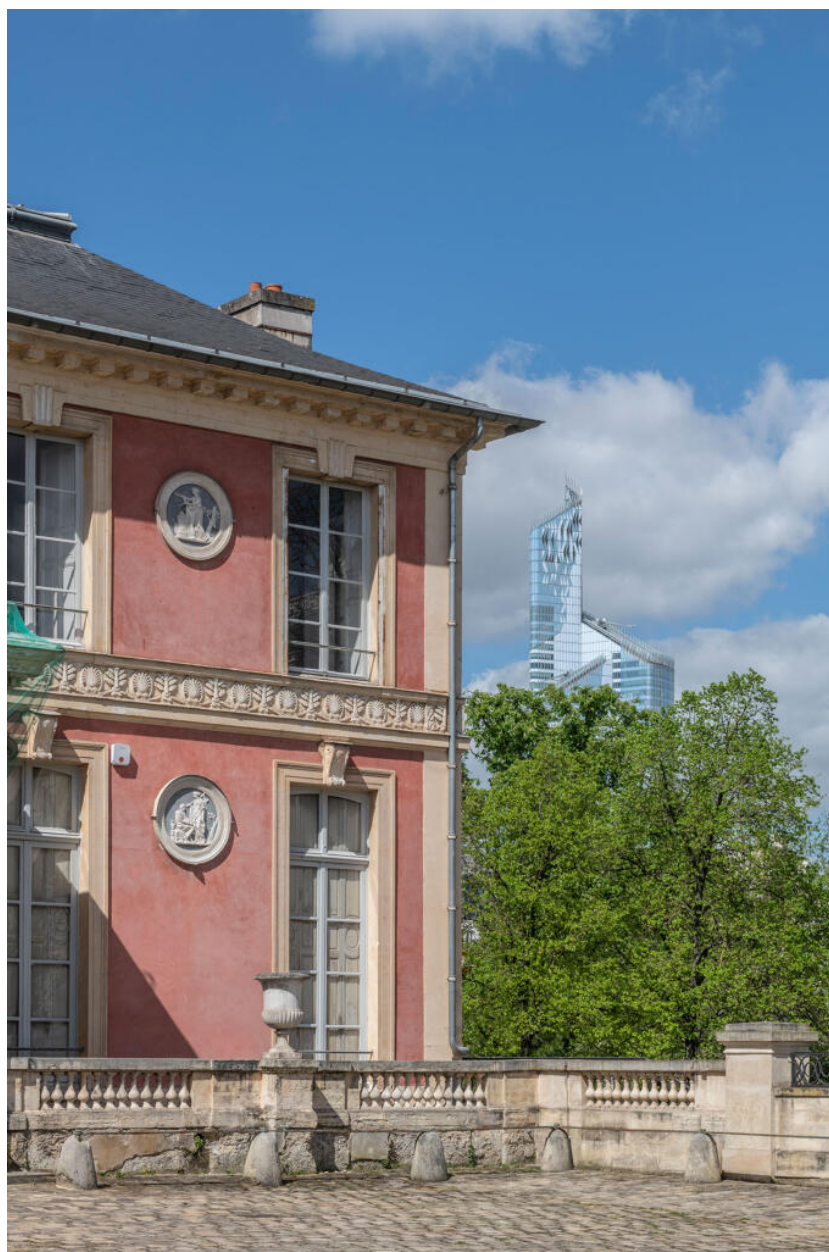
Façade sur rue, angle nord-est.
