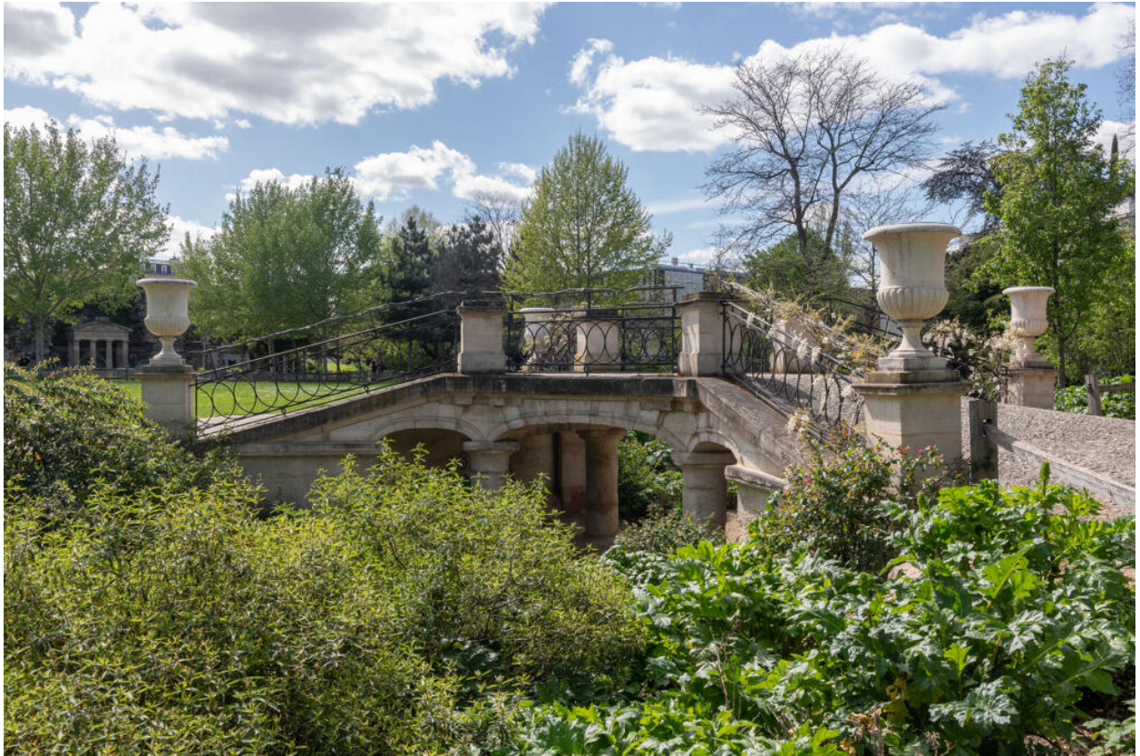
Le pont de pierre, vue d'ensemble.
