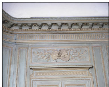
Ancienne chambre transformée, détail des lambris et du dessus de porte à décor musical. Phot. Vialles Jean-Bernard IVR11_19929201469XA
