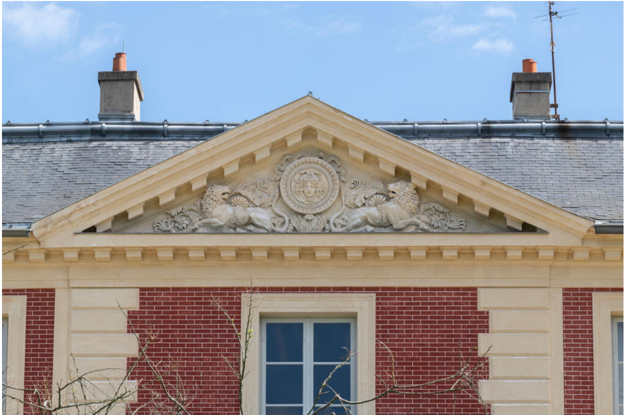
Façade ouest, sur jardin, détail du fronton : une tête de Méduse dans un médaillon est encadrée de deux lions dos à dos.
