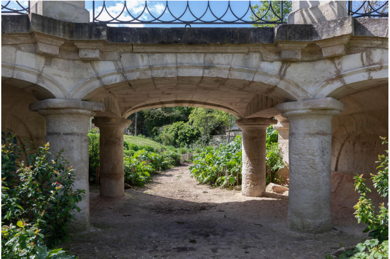
Fabriques. Le pont de pierre.
