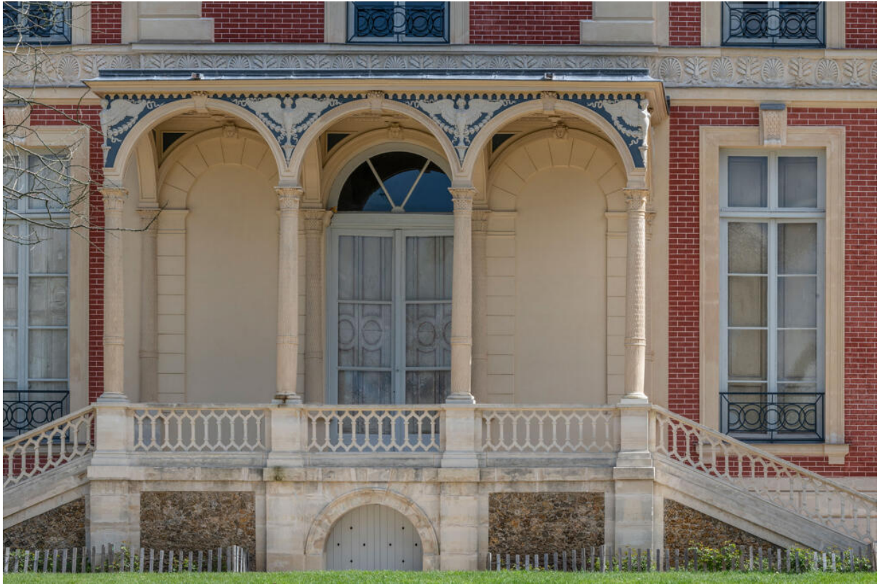
Façade ouest, détail du portique donnant accès au jardin.
