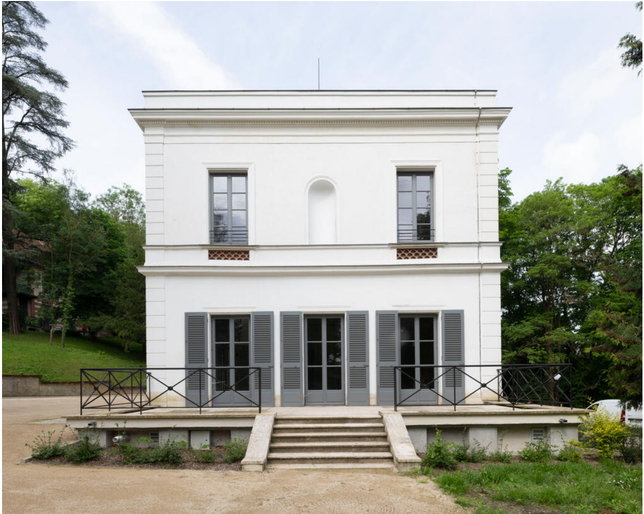
Vue de la façade latérale est. La terrasse a été ajoutée postérieurement et les fenêtres transformées en portes-fenêtres.
