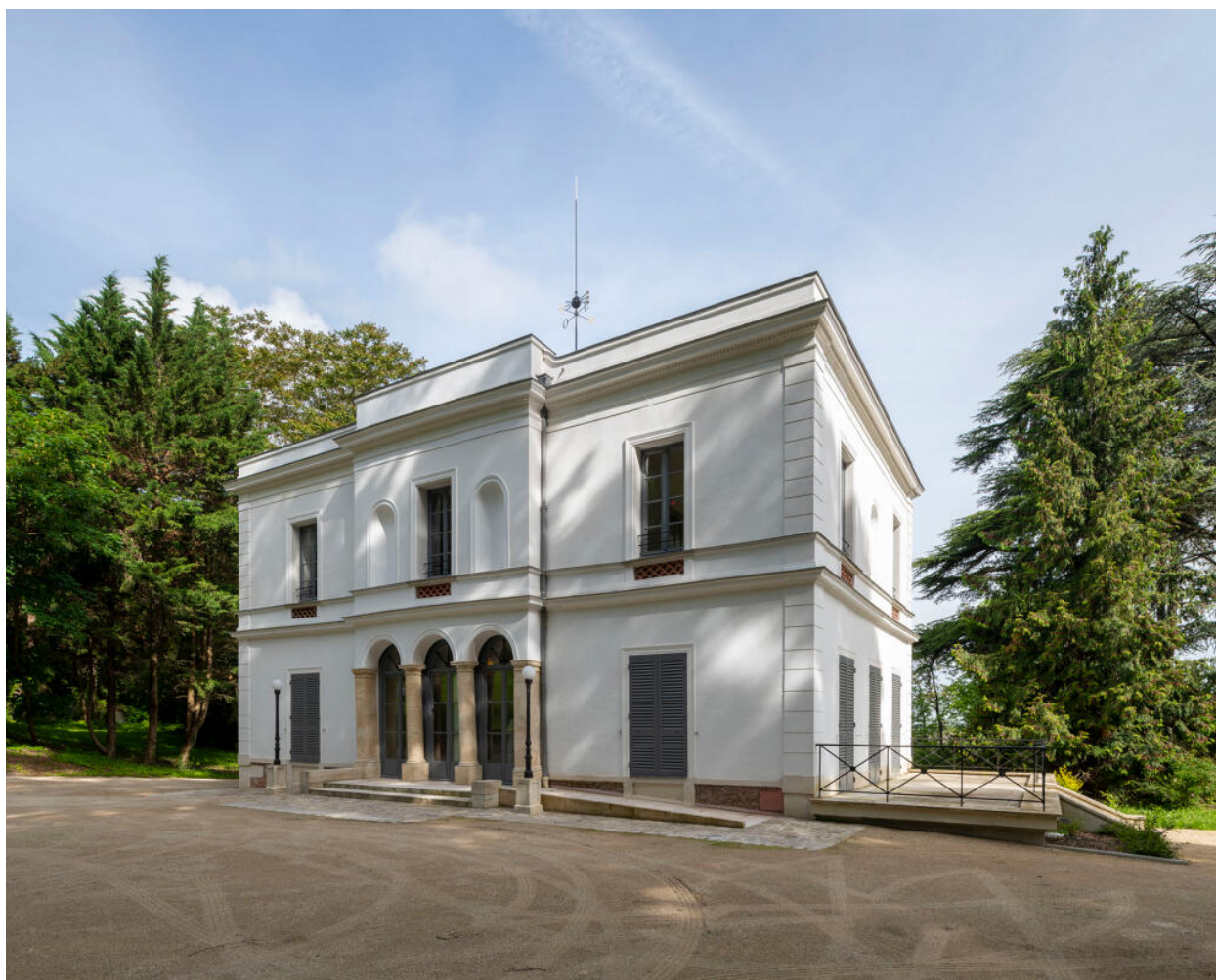
Vue de la façade sud.
