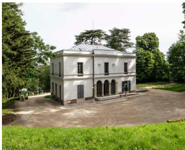
Vue de la façade sud. L'entrée se fait par la triple arcature. Phot. Ayrault Philippe IVR11_20247800300NUC4A
