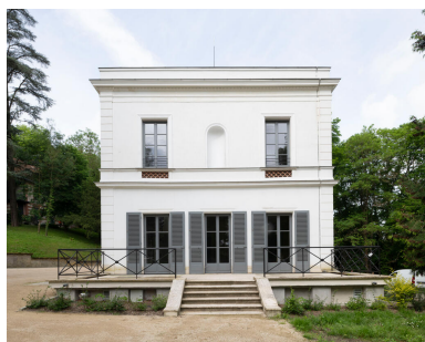
Vue de la façade latérale est. La terrasse a été ajoutée
