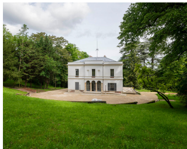
Vue de la façade antérieure sud. La villa est entourée d'un grand parc. Phot. Ayrault Philippe IVR11_20247800301NUC4A
