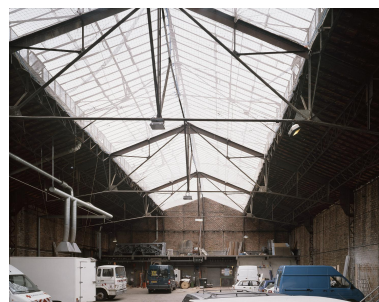
Vue intérieure de l'entrepôt. Phot. Laurent Kruszyk IVR11_20049300465VA
