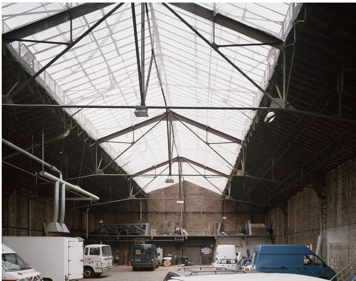
Vue intérieure de l'entrepôt.
