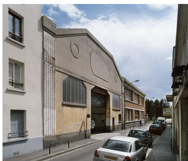
Vue de la façade monumentale, rue Raymonde-Salez. Phot. Laurent Kruszyk IVR11_20049300463VA
