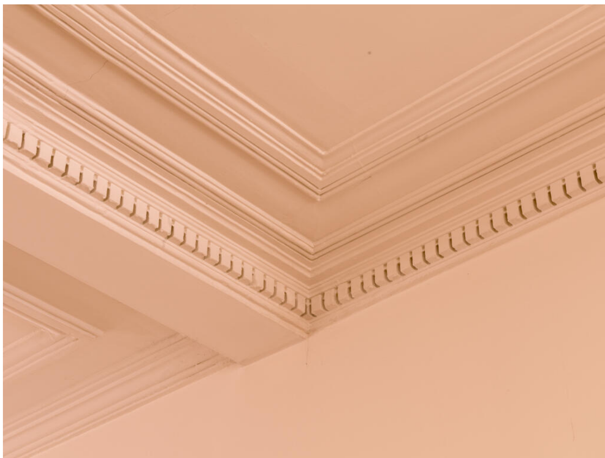
Détail des moulures du plafond de la pièce est du rez-de-chaussée.
