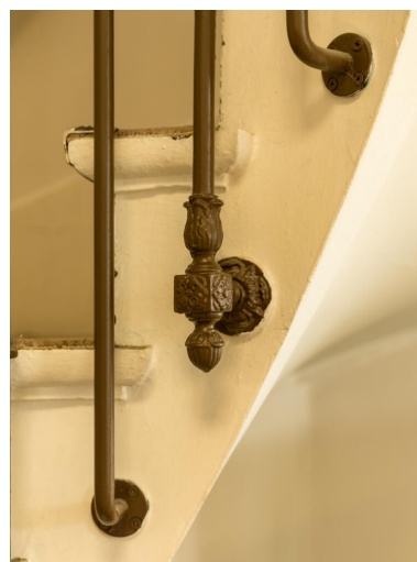
Détail de la rampe. Phot. Asseline Stéphane IVR11_20259100206NUC4A
