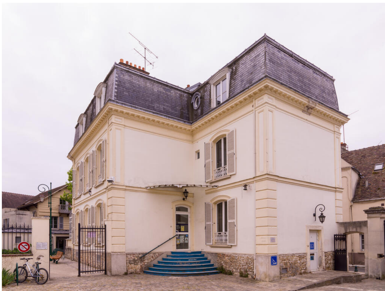
Vue générale depuis le nord-ouest.
