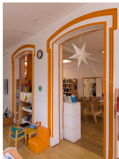
Encadrements de baies du rez- de-chaussée de la façade est. Phot. Asseline Stéphane IVR11_20259100200NUC4A
