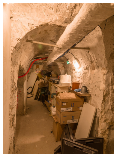
Vue de la cave. Phot. Asseline Stéphane IVR11_20259100214NUC4A
