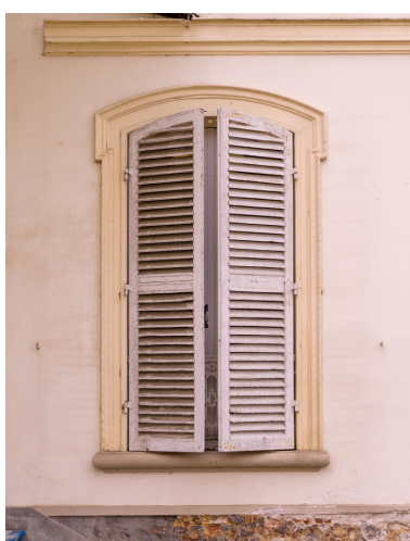
Encadrement de baie, façade côté Parc du Moustier. Phot. Asseline Stéphane
