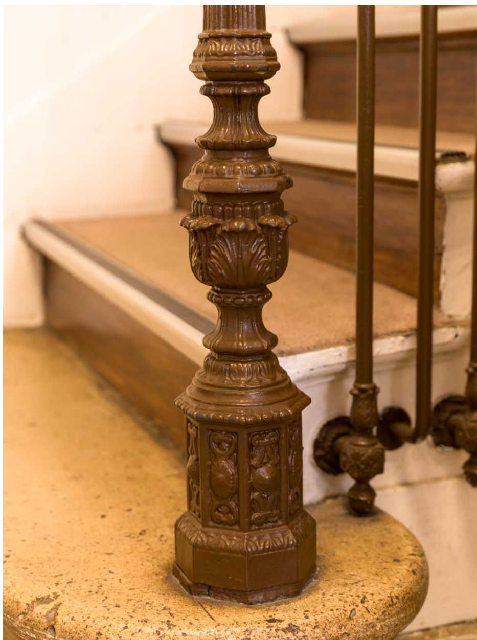
Détail du départ de rampe.
