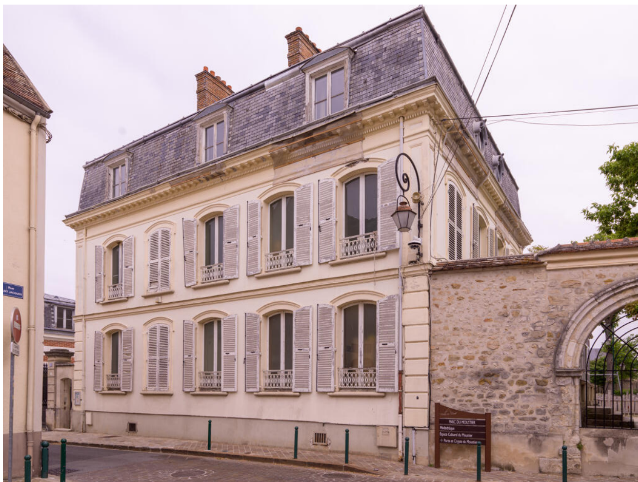
Vue générale depuis la rue Saint-Jacques (depuis le sud).
