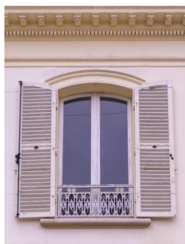
Détail de la façade sur le Parc du Moustier. Phot. Asseline Stéphane
