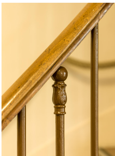
Détail de la rampe. Phot. Asseline Stéphane IVR11_20259100207NUC4A
