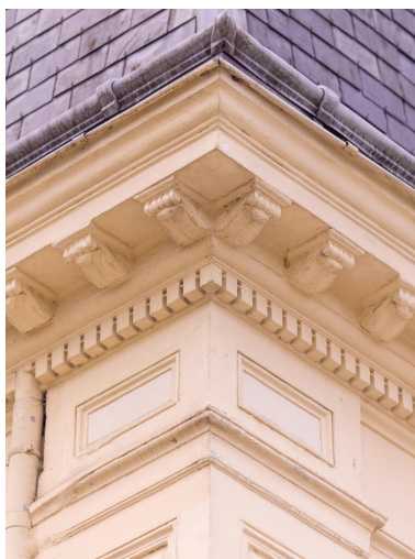
Vue du décor couronnant les façades. Phot. Asseline Stéphane IVR11_20259100193NUC4A
