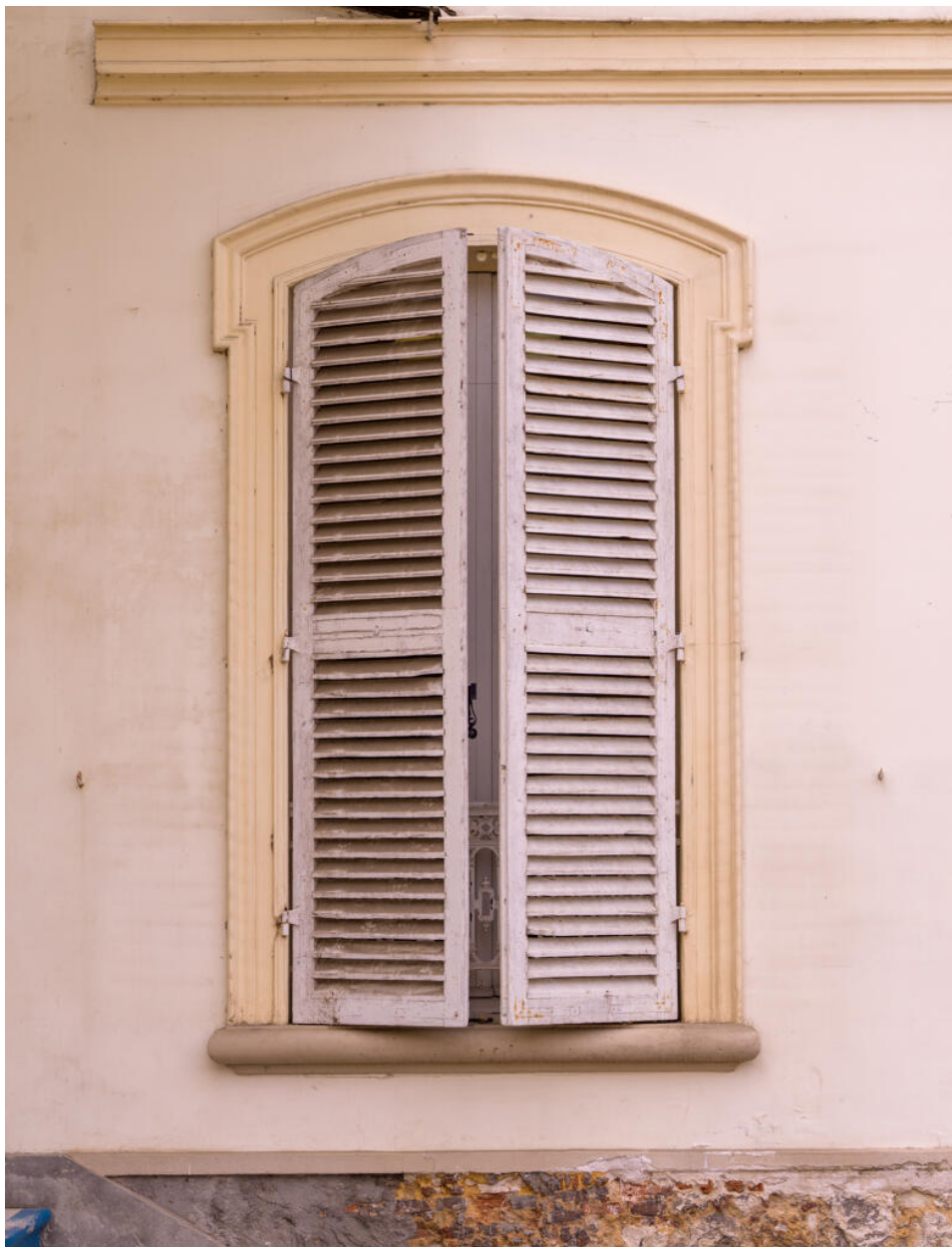
Encadrement de baie, façade côté Parc du Moustier.
