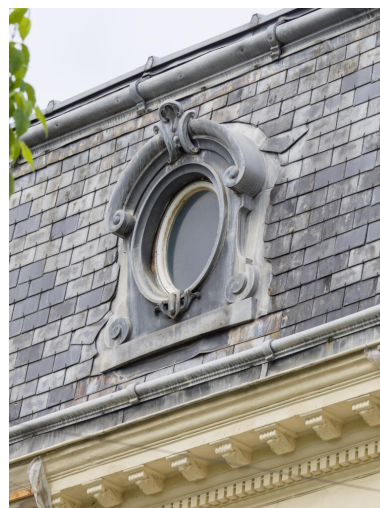
Détail du toit à la Mansart. Phot. Asseline Stéphane IVR11_20259100191NUC4A
