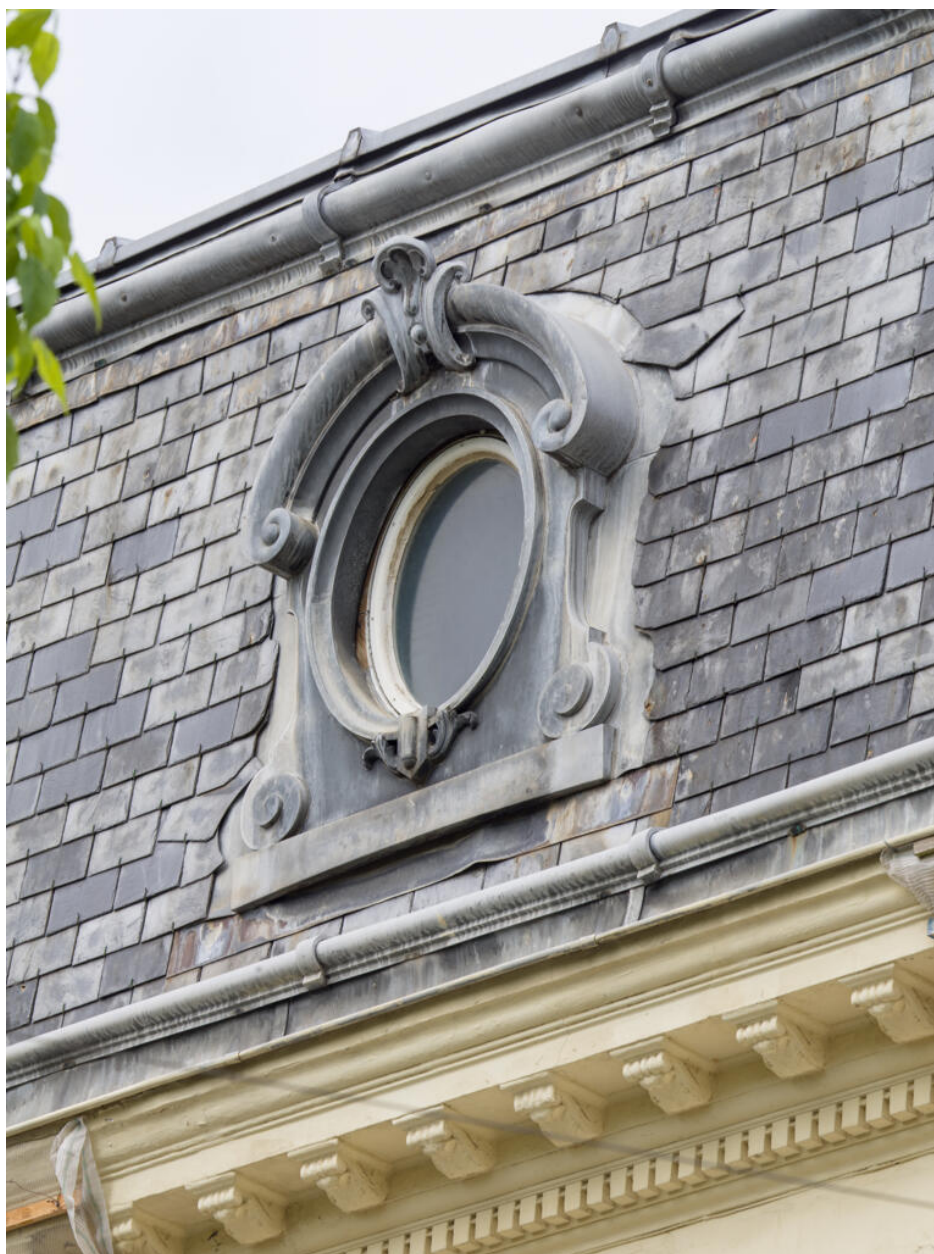
Détail du toit à la Mansart.
