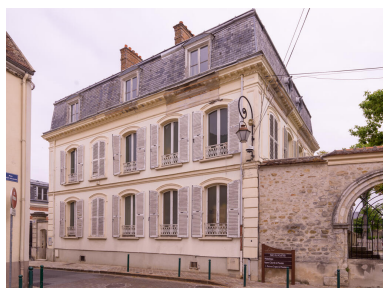
Vue générale depuis la rue Saint-Jacques (depuis le sud). Phot. Asseline Stéphane IVR11_20259100188NUC4A
