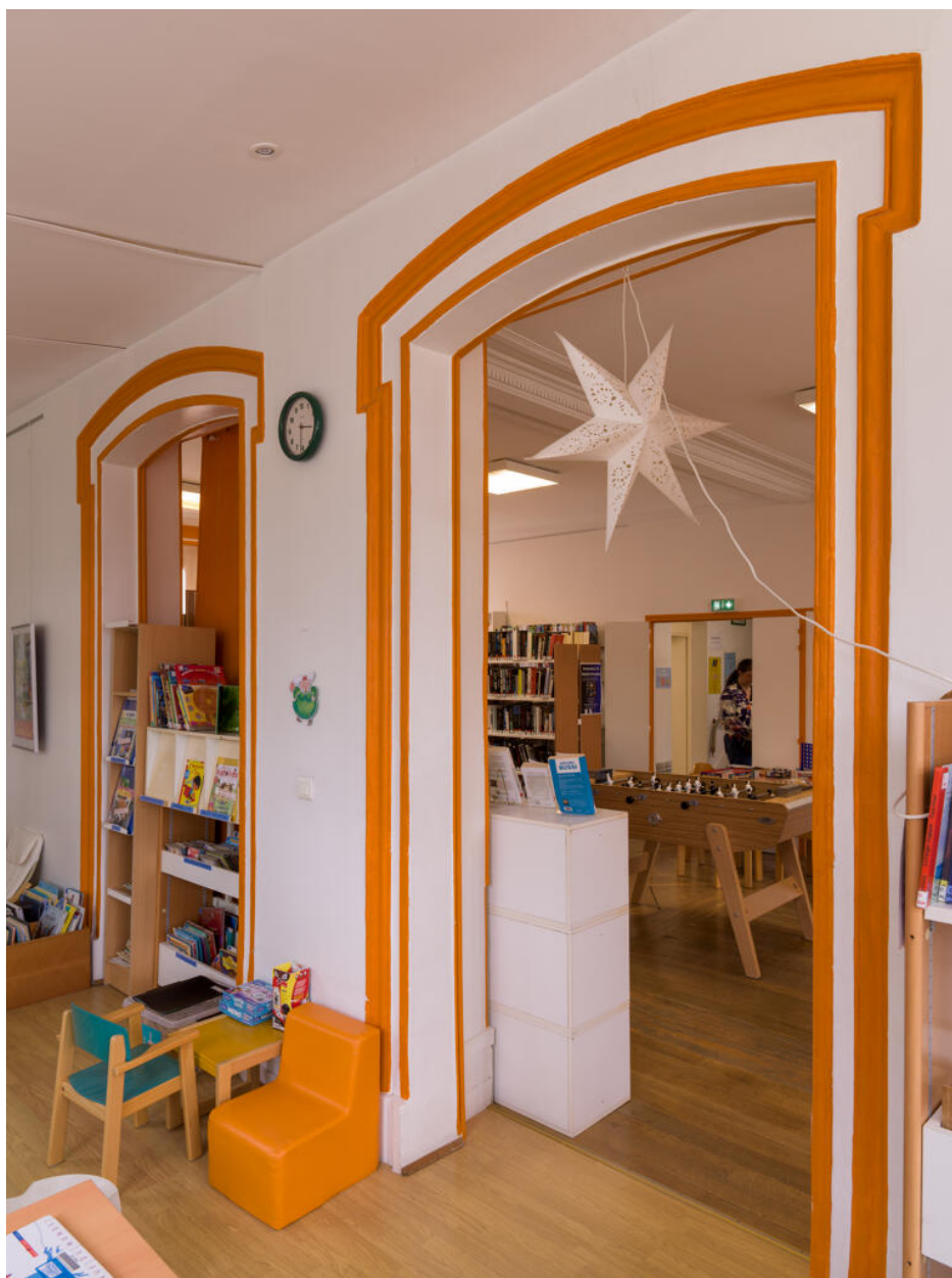
Encadrements de baies du rez-de-chaussée de la façade est.
