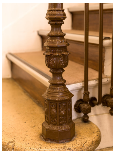
Détail du départ de rampe. Phot. Asseline Stéphane IVR11_20259100205NUC4A
