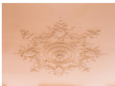
Détail d'une moulure du plafond de la pièce est du rez-de-chaussée. Phot. Asseline Stéphane IVR11_20259100212NUC4A
