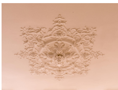
Détail d'une moulure du plafond de la pièce est du rez-de-chaussée. Phot. Asseline Stéphane IVR11_20259100211NUC4A
