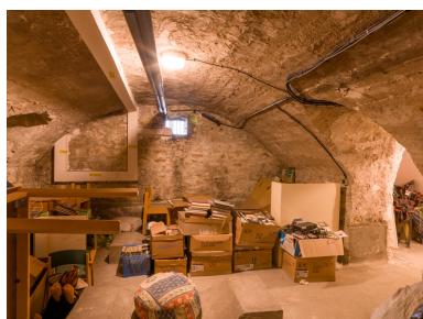
Vue de la cave. Phot. Asseline Stéphane IVR11_20259100213NUC4A
