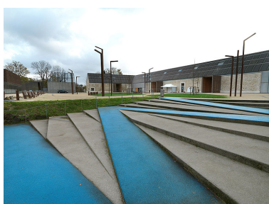
Vue de l'intérieur de l'ancienne cour de ferme, depuis le sud-est. Phot. Jean-Bernard Vialles IVR11_20157700296NUC4A
