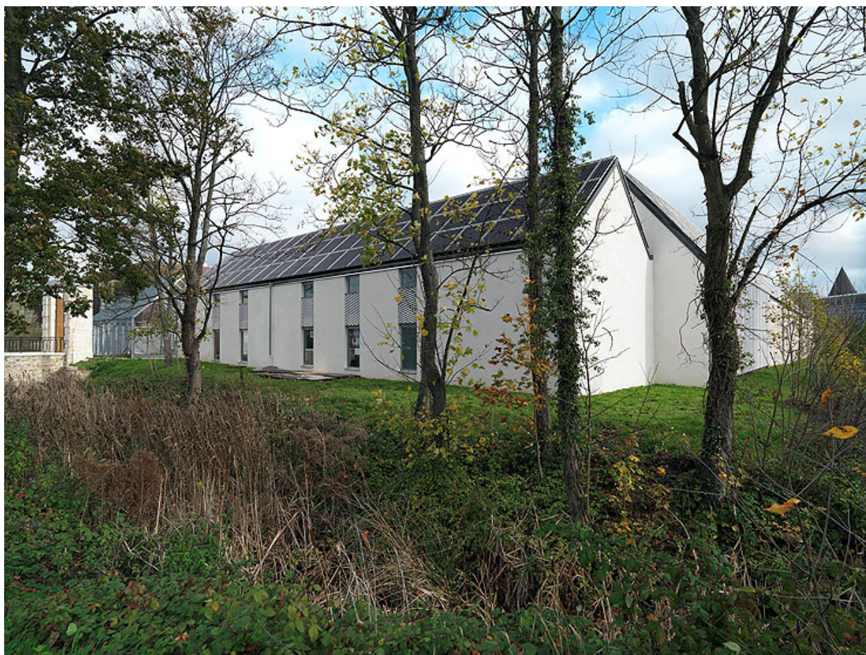
L'ancienne ferme de la Haute-Maison, vue du sud-ouest. Au premier plan, le fossé entourant la ferme.
