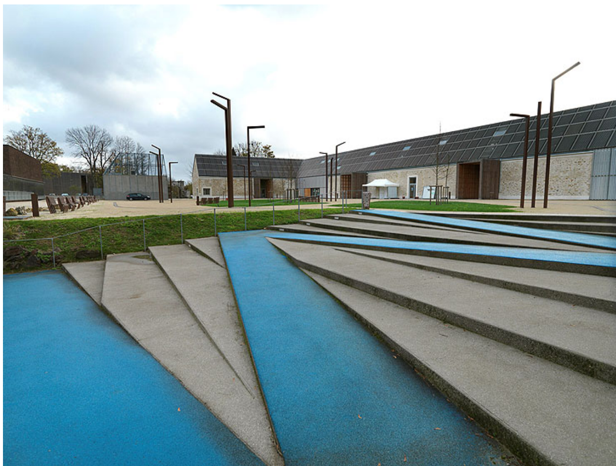
Vue de l'intérieur de l'ancienne cour de ferme, depuis le sud-est.
