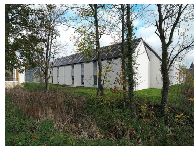
L'ancienne ferme de la Haute-Maison, vue du sud-ouest. Au premier plan, le fossé entourant la ferme. Phot. Jean-Bernard Vialles IVR11_20157700294NUC4A
