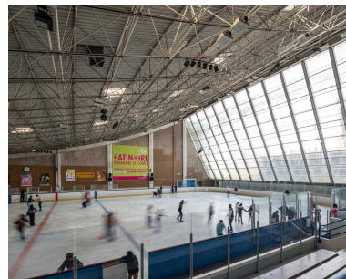
Vue générale de la structure métallique tridimensionnelle. Phot. Philippe Ayrault IVR11_20229100739NUC4A
