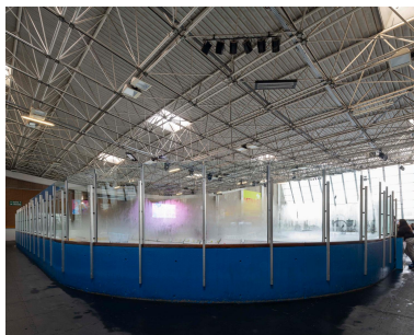
Le tour de la piste de la patinoire. Phot. Philippe Ayrault IVR11_20229100737NUC4A
