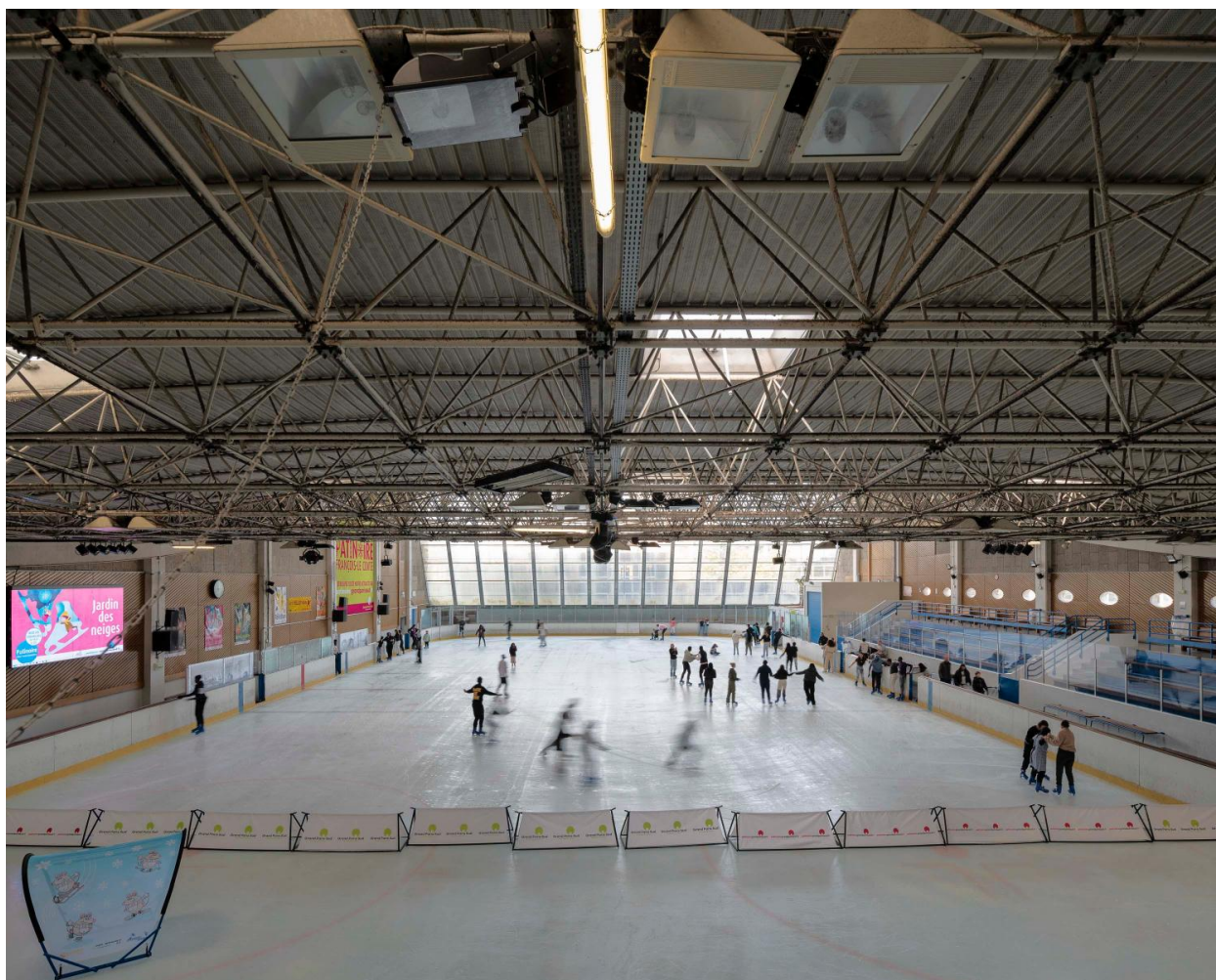
Vue générale de l'intérieur de la patinoire.
