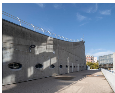
Vue latérale de la patinoire avec les ouvertures donnant sur la piste. Phot. Philippe Ayrault IVR11_20229100753NUC4A
