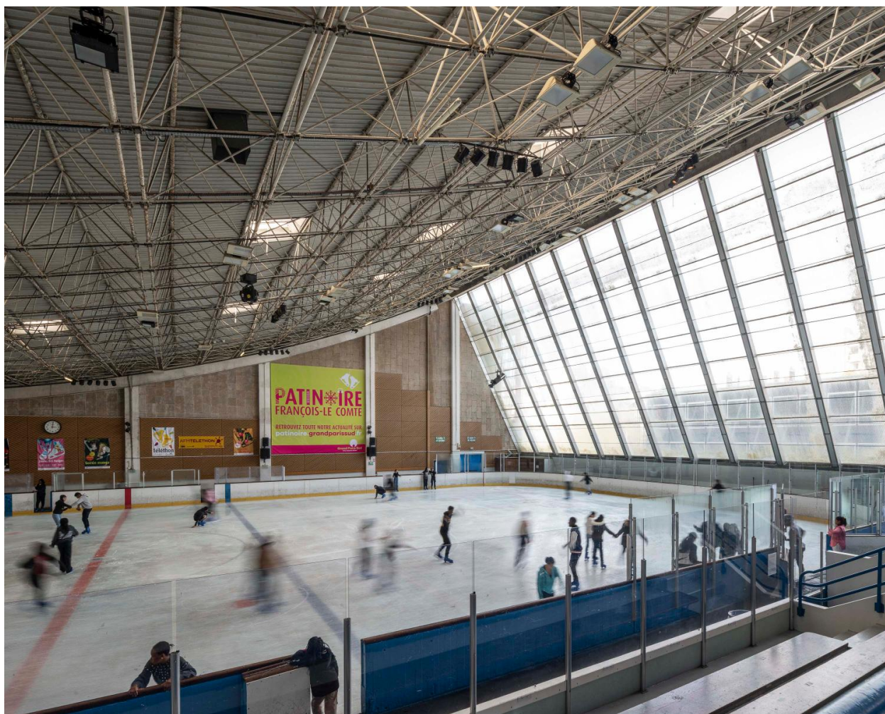
Vue générale de la structure métallique tridimensionnelle.
