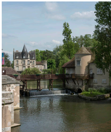
vue extérieure de la villa depuis le pont sur le Loing. Au premier plan, le moulin Provencher. Phot. Philippe Ayrault IVR11_20150770325NUC4A
