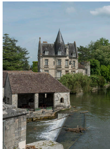
Vue extérieure de la villa depuis le Loing. Phot. Philippe Ayrault IVR11_20150770321NUC4A
