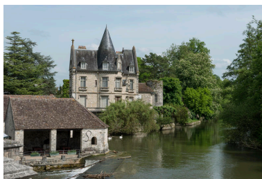
Vue extérieure de la villa depuis le Loing. Phot. Philippe Ayrault IVR11_20150770322NUC4A
