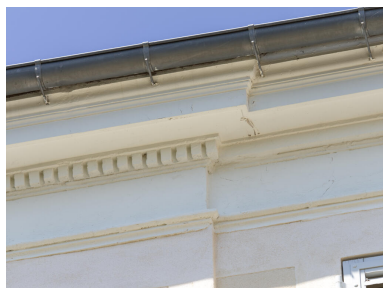
Vue de détail de l'entablement couronnant la façade donnant sur cour depuis l'angle sud-est. Phot. Asseline Stéphane IVR11_20259100512NUC4A
