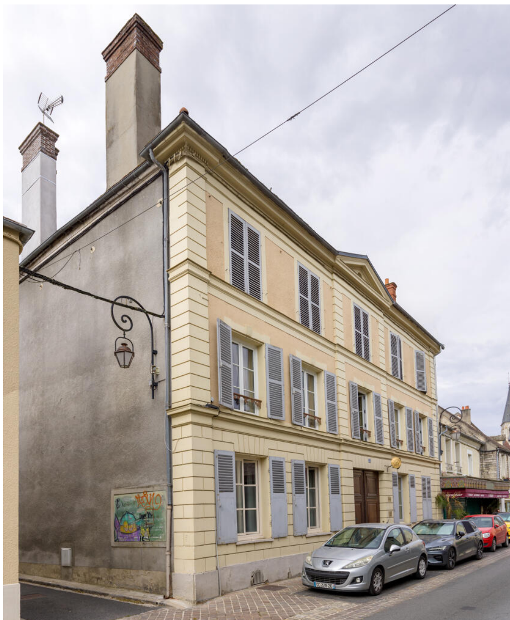
Vue générale depuis l'angle nord-est.
