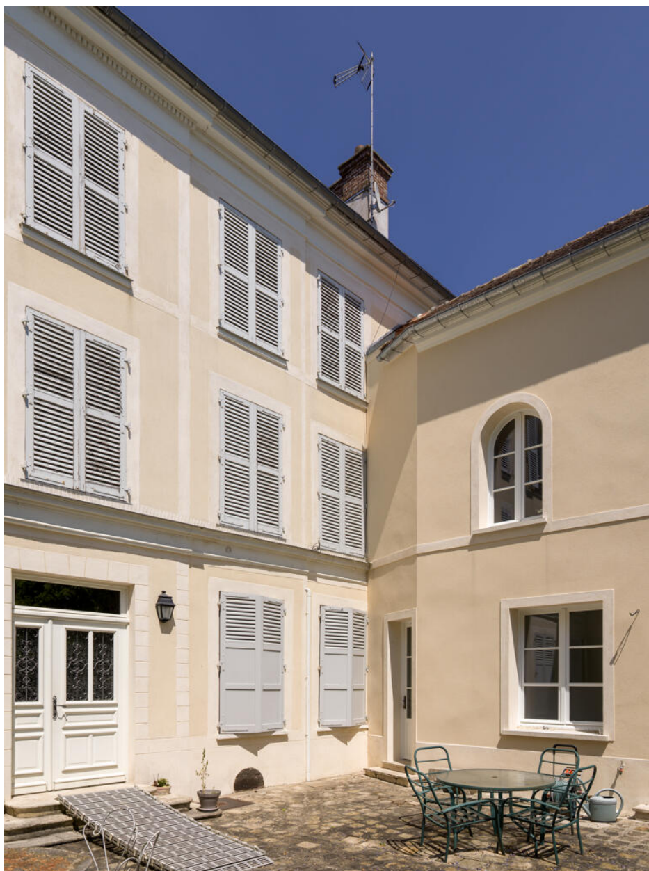
Vue de détail de la façade sur cour et l'aile est depuis l'angle sud-ouest.
