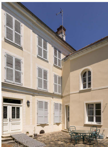
Vue de détail de la façade sur cour et l'aile est depuis l'angle sud-ouest. Phot. Asseline Stéphane IVR11_20259100510NUC4A
