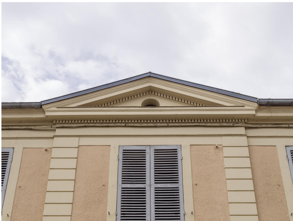
Vue de détail du couronnement de l'avant-corps de la façade principale donnant sur rue.
