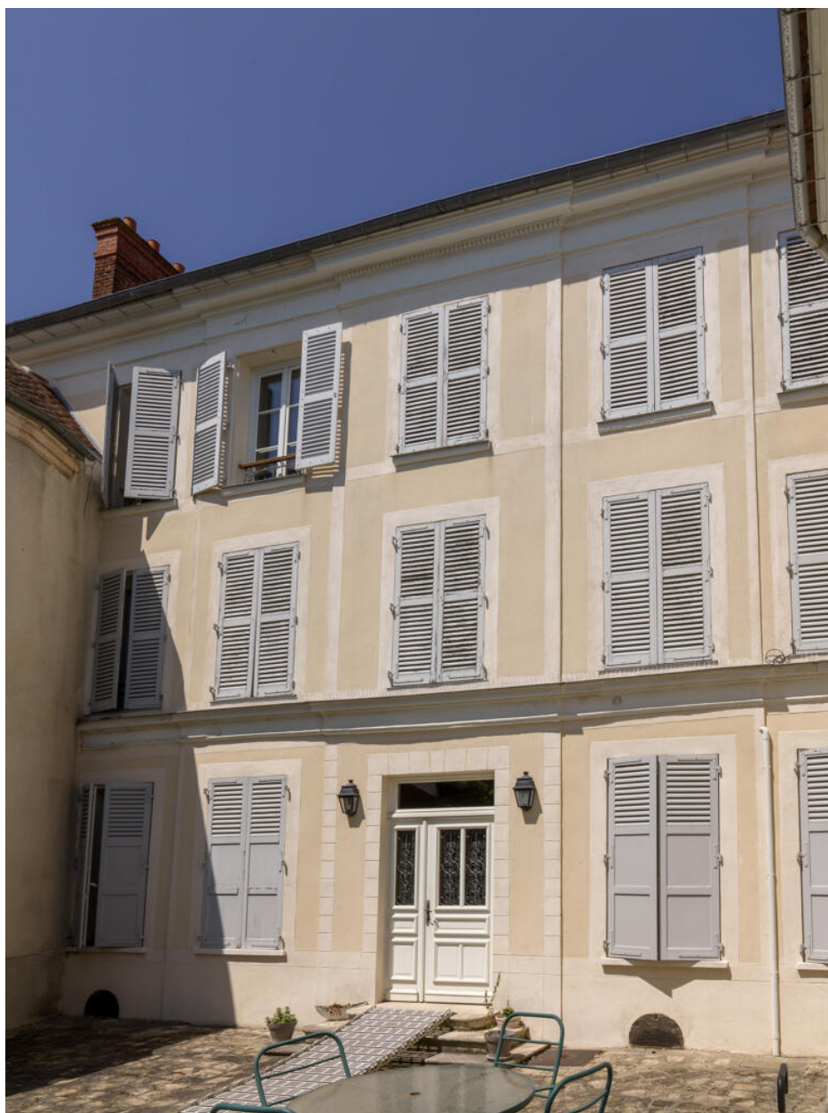
Vue de détail de la façade arrière donnant sur cour depuis l'angle sud-est.
