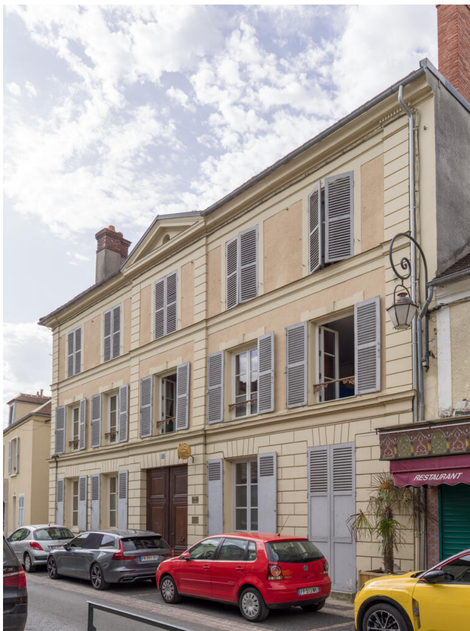
Vue générale depuis l'angle nord-ouest.
