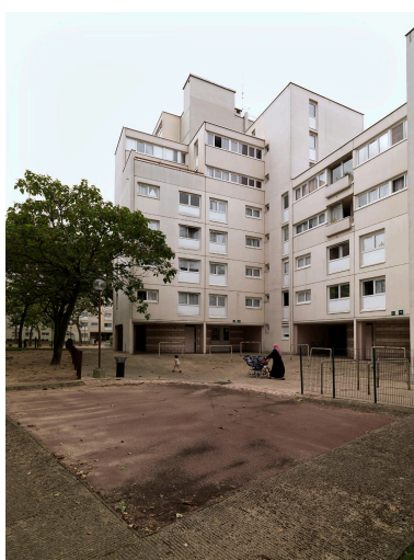
Cité dite Ilot 255. Vue depuis l'espace central. IVR11_20109300171NUC4A
