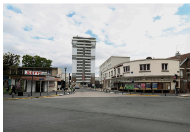
Cité Marcel Cachin. Vue de l'entrée de la cité, construite en 1956-1964 par André Bérard, 8 avenue de la Résistance.. IVR11_20109300199NUC4A
