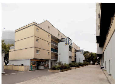
Cité Jacques Duclos. Vue de la rue du Chemin Vert. IVR11_20109300191NUC4A
