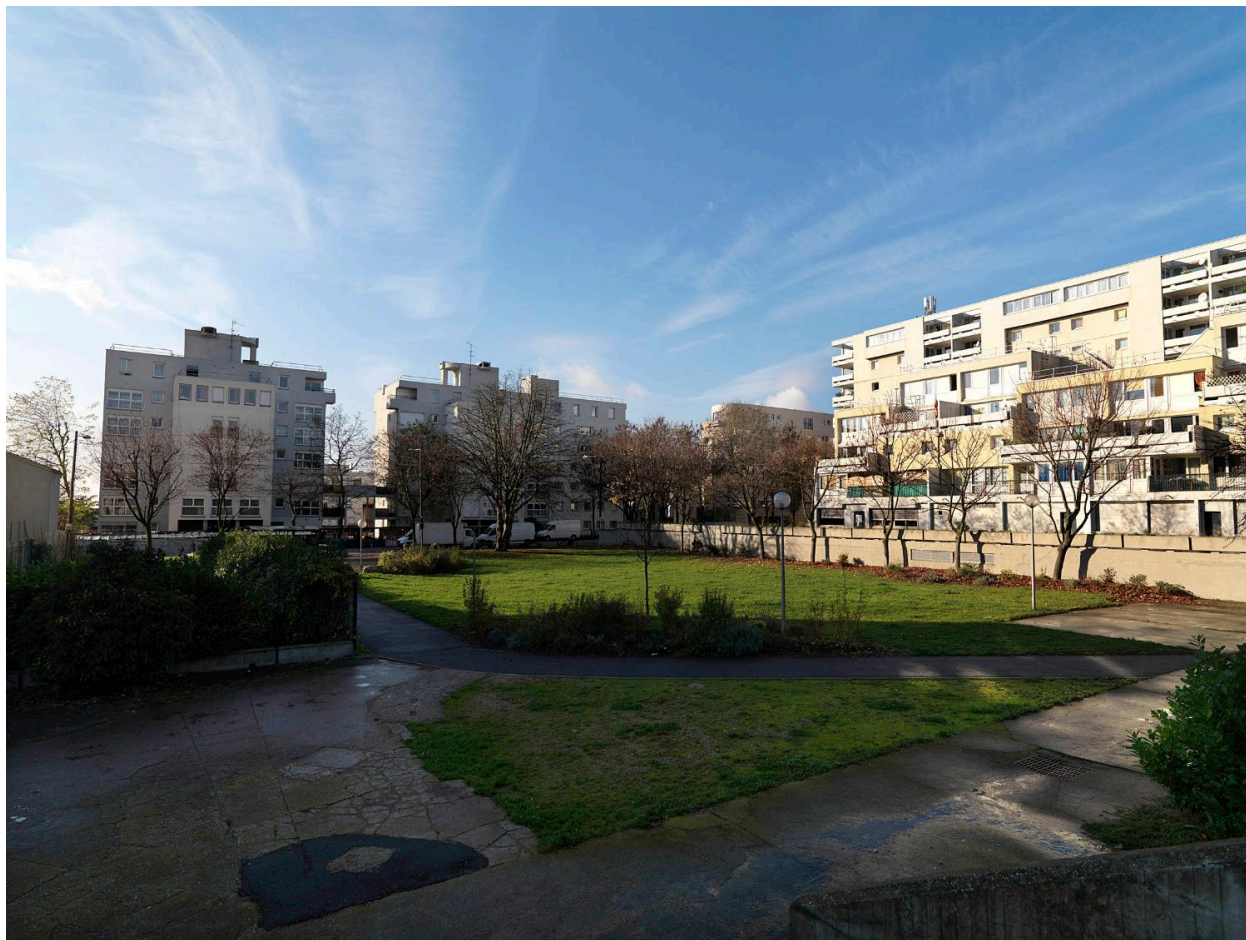
Z.A.C. du Chemin Vert. Vue d'ensemble.
