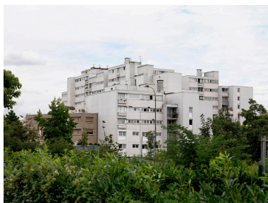
Cité dite Ilot 255. Vue générale de la cité, réalisée par Paul Chemetov (Atelier
