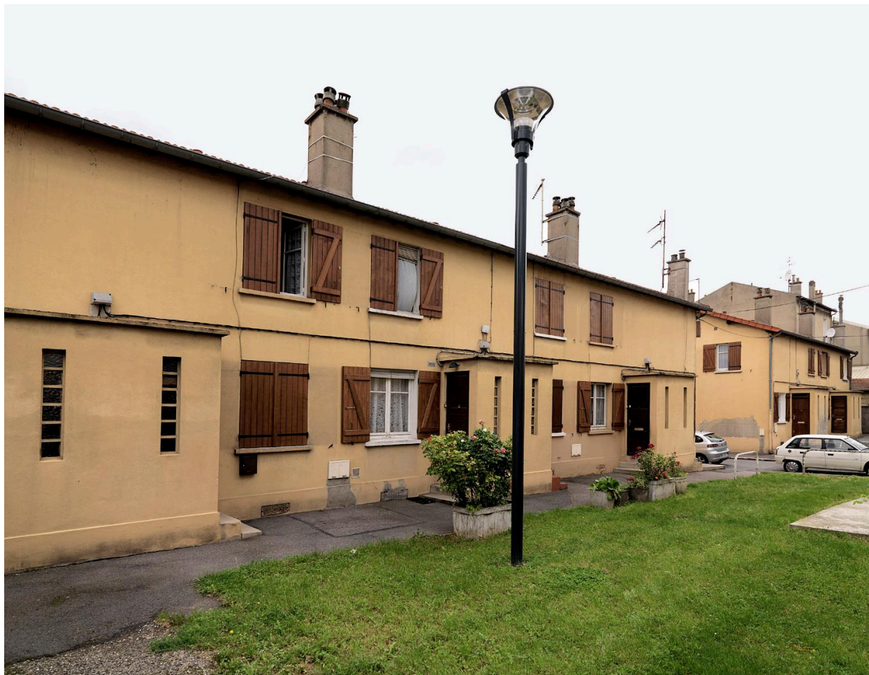
Cité des Mares. Vue d'un bâtiment.
