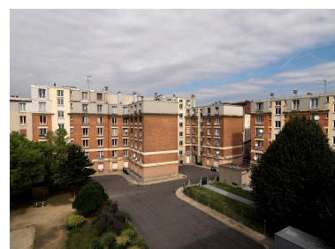
Cité de La Seimaroise. Vue générale des bâtiments des années 1930, côté cours. Georges Imbert (architecte). IVR11_20109300169NUC4A
