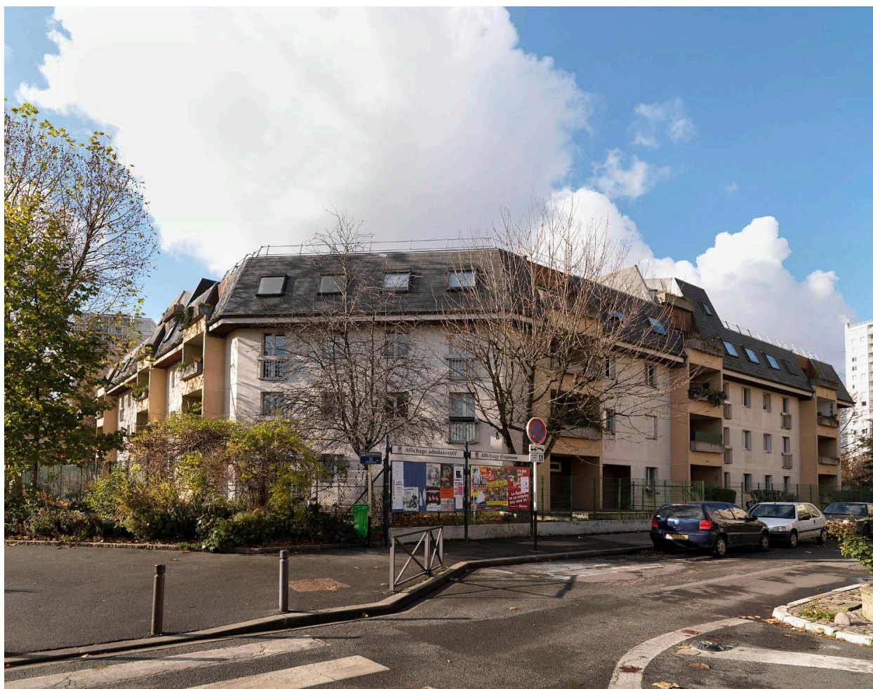
Cité Elsa Triolet. Vue des façades sur rue de la résidence, rue Vassou, avenue Lénin, réalisée par Emile Aillaud en 1980-1983.
