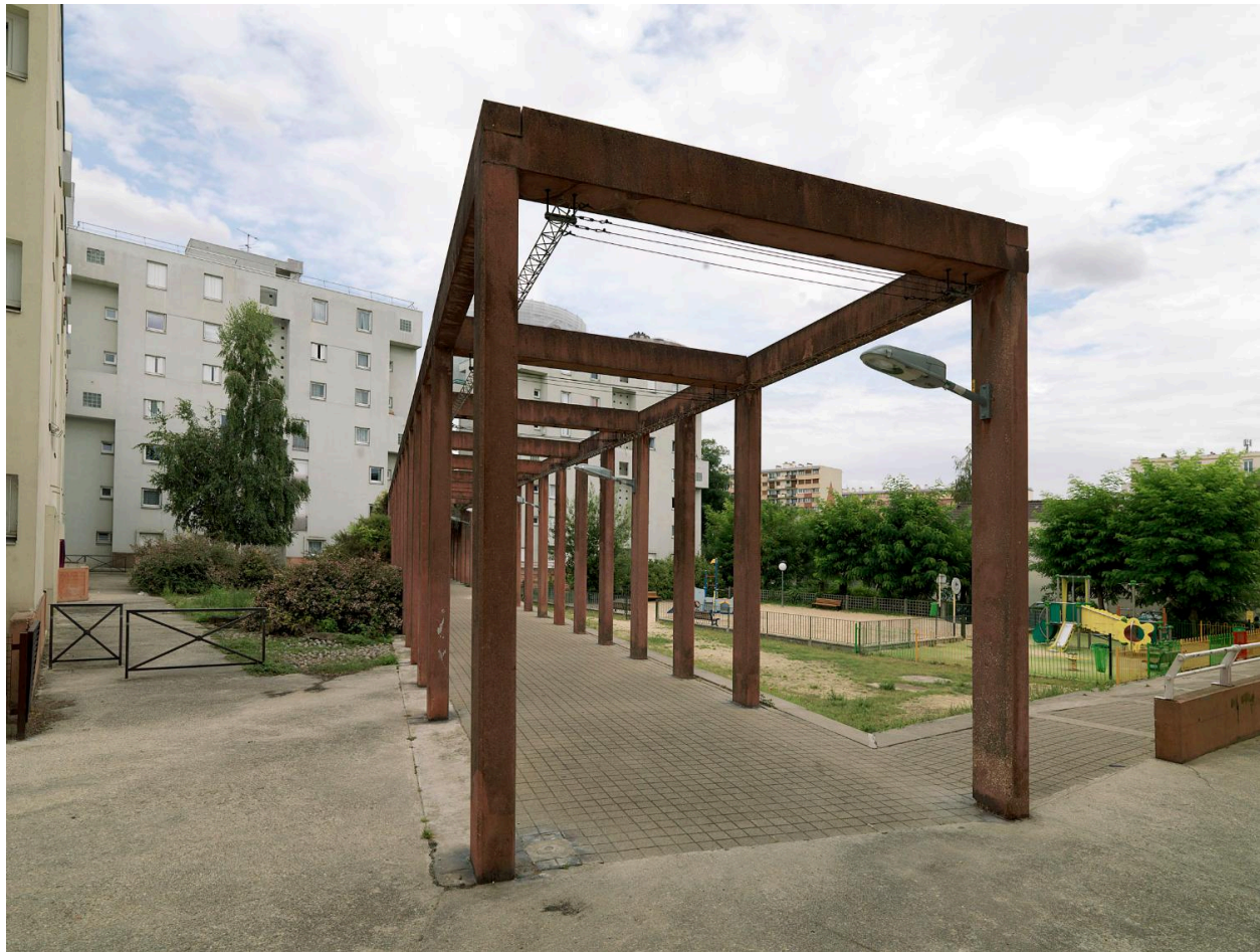
Cité Pablo Neruda. Vue rapprochée du portique extérieur.
