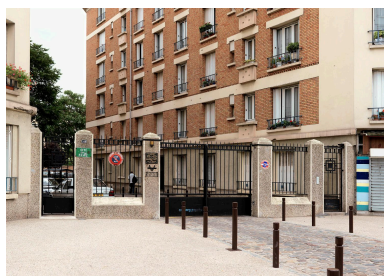
Cité du Foyer des Invalides et des Anciens Combattants. Vue de l'entrée principale, 149 rue de la République. IVR11_20109300152NUC4A
