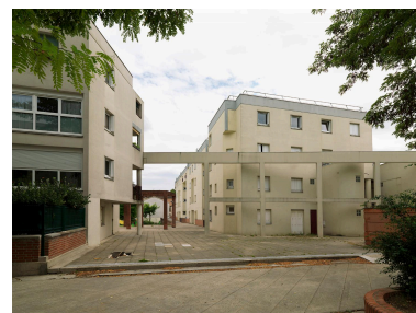
Cité Pablo Neruda. Vue depuis la rue Pierre Brossolette. IVR11_20109300186NUC4A
