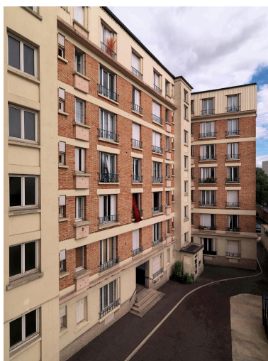
Cité du Foyer des Invalides et des Anciens Combattants. Vue de l'arrière d'un bâtiment, construit en 1931. E. Thomas et Pavot (architectes). IVR11_20109300154NUC4A
