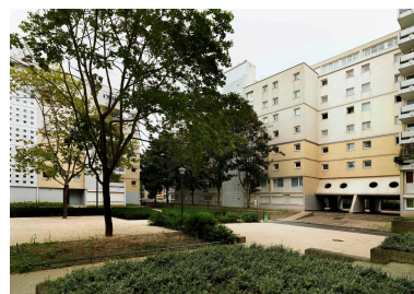
Cité Jacques Duclos. Vue d'ensemble sur le parc intérieur de la cité, construite en 1980-1983 par Paul Chemetov (Atelier d'urbanisme et d'architecture). IVR11_20109300192NUC4A
