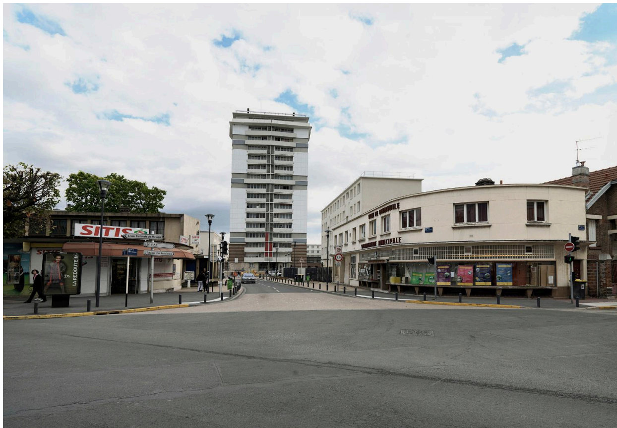
Cité Marcel Cachin. Vue de l'entrée de la cité, construite en 1956-1964 par André Bérard, 8 avenue de la Résistance..
