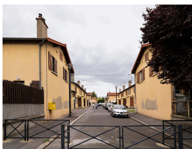
Cité des Mares. Vue actuelle de l'entrée de la cité, rue de Benfleet, construite par André Bérard en 1952-1958. IVR11_20109300145NUC4A
