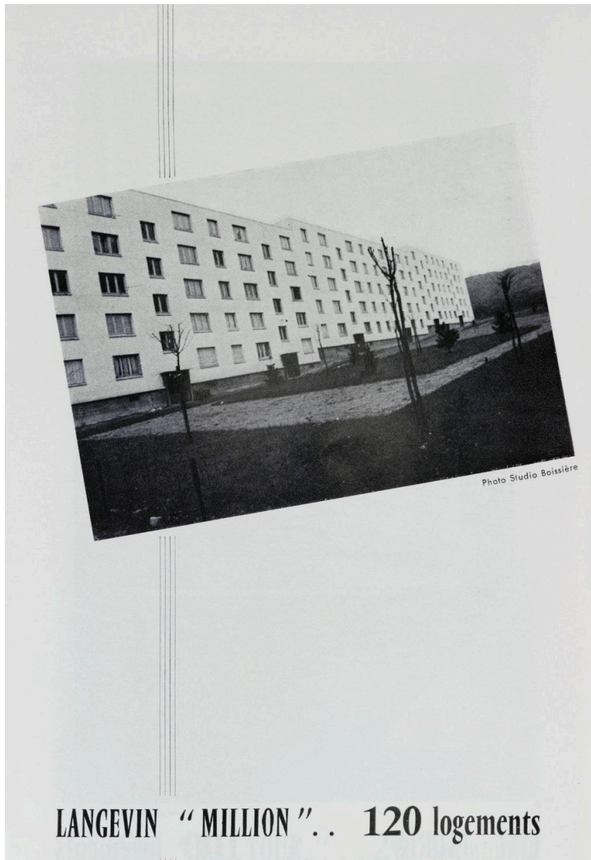
Cité Paul Langevin. Reproduction de photographie. Vue d'ensemble des barres. (AM Romainville)
