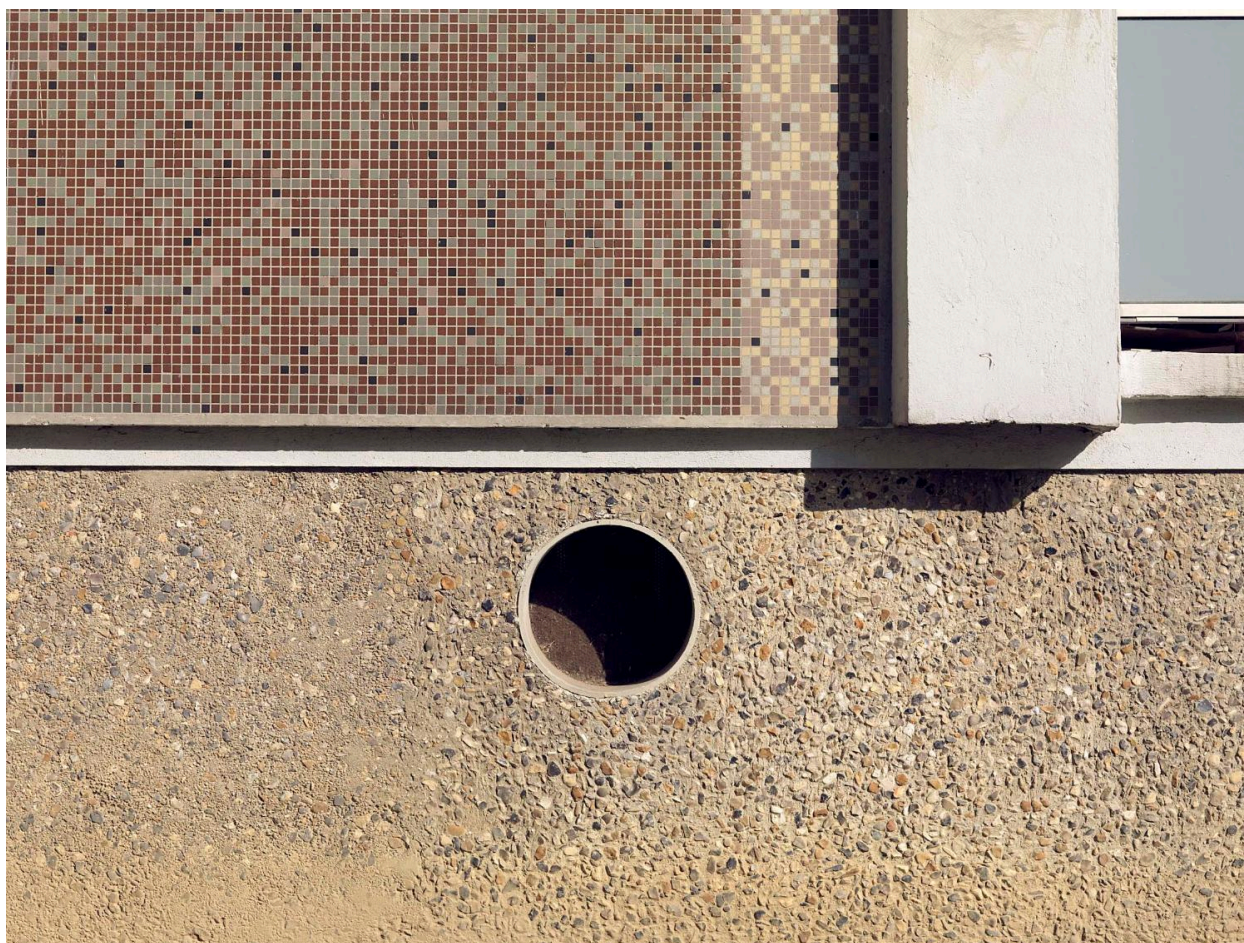
Cité Youri Gagarine. Vue de détail de la façade.
