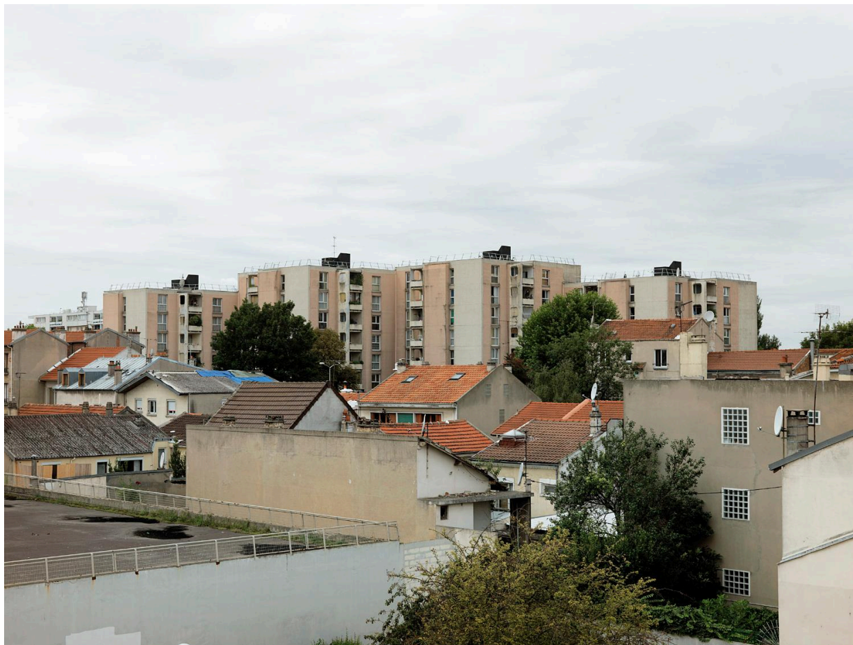
Cité Charles De Gaulle. Vue générale de la cité, route de Montreuil, rue Jean-Jaurès, construite dans les années 1960-1970 par l'Atelier d'urbanisme et d'architecture (Paul Chemetov et J. Deroche, architectes).
