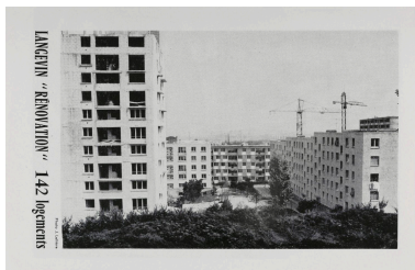
Cité Paul Langevin. Reproduction de photographie. Vue d'ensemble. (AM Romainville) IVR11_20109300255NUC4A
