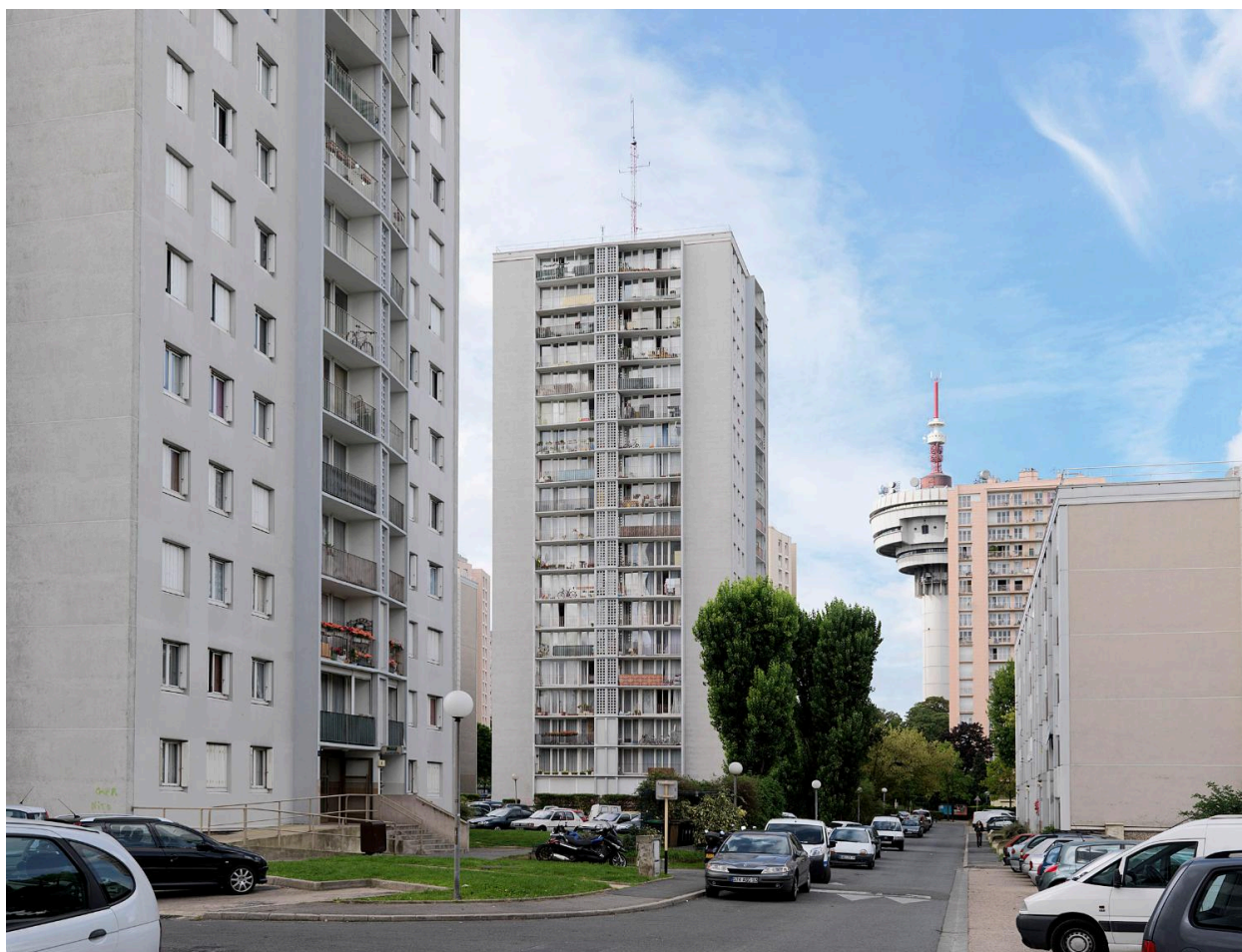
Cité Youri Gagarine. Vue d'ensemble de la cité, construite en 1960-1970, par Henry Marmorat (architecte).
