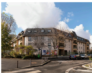
Cité Elsa Triolet. Vue des façades sur rue de la résidence, rue Vassou, avenue Lénin, réalisée par Emile Aillaud en 1980-1983. IVR11_20109300213NUC4A
