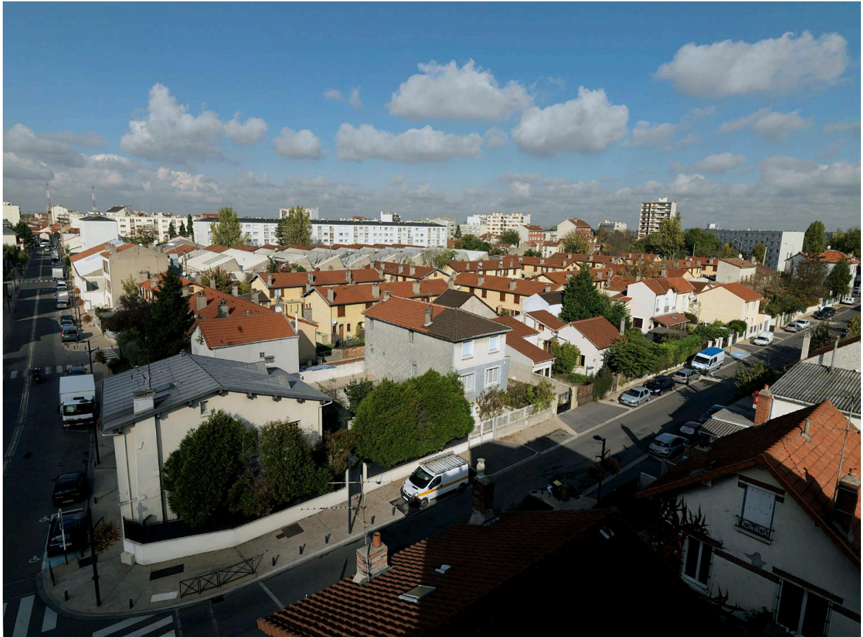
Cité des Mares. Vue aérienne de la cité-jardin et de la rue. Construite par André Bérard en 1952-1958.
