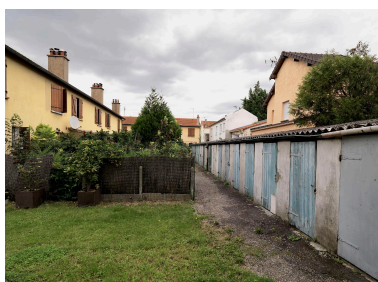
Cité des Mares. Vue sur les jardins et les remises. IVR11_20109300148NUC4A
