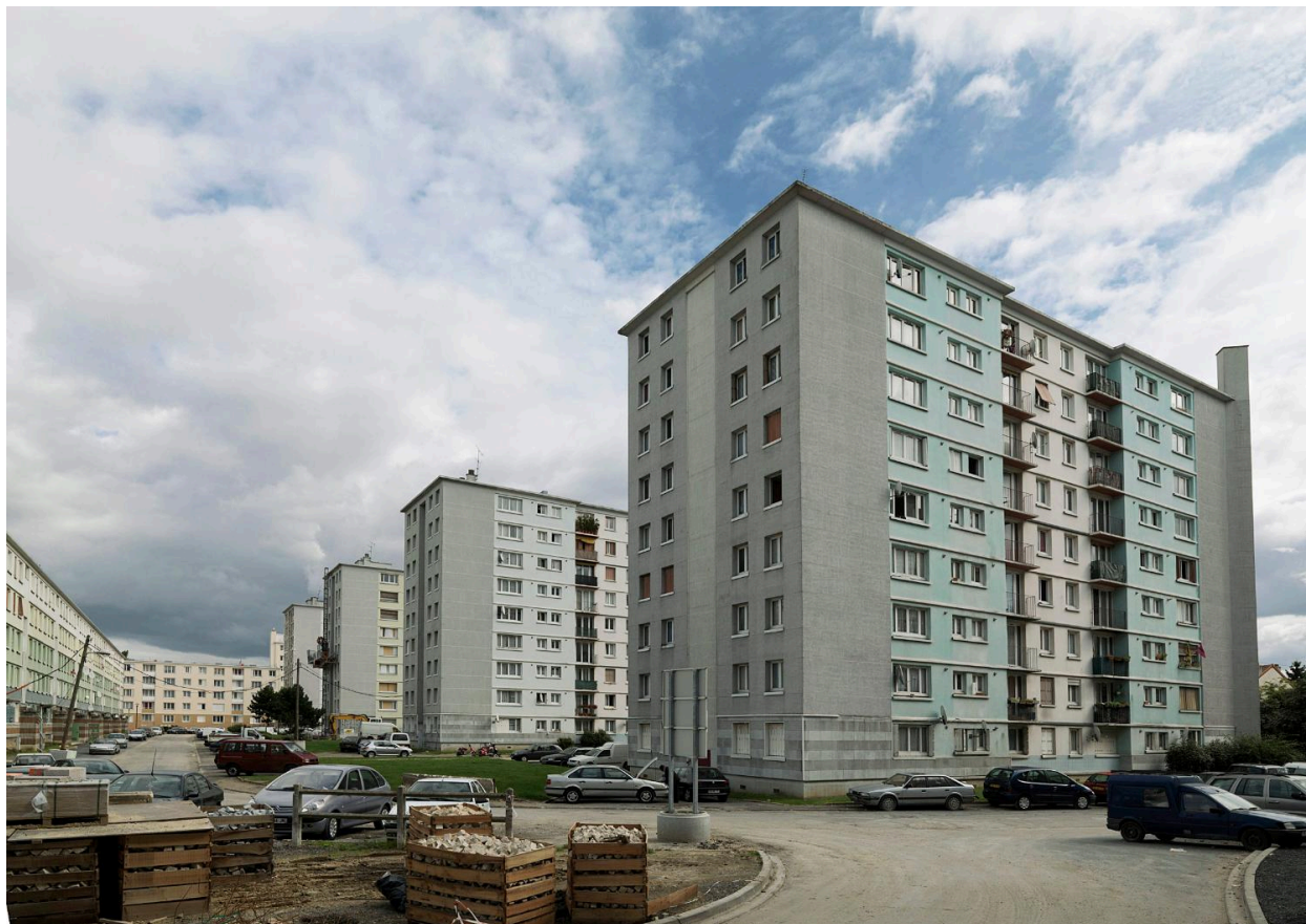
Cité Marcel Cachin. Vue de l'ensemble des bâtiments, rue de la Résistance, rue Saint-Germain, rue de la République. Construite en 1956-1964 par André Bérard (architecte).
