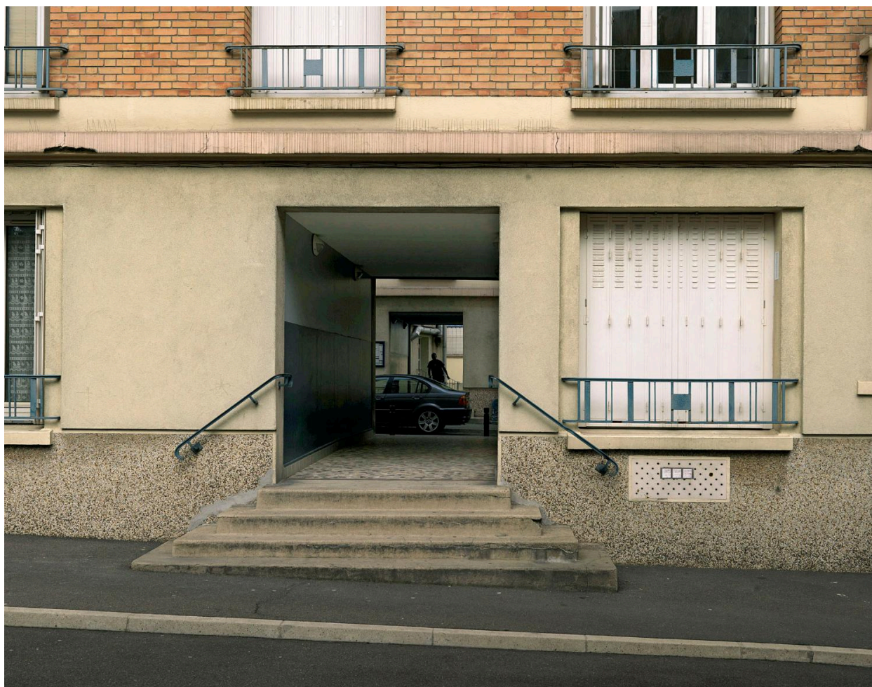
Cité du Foyer des Invalides et des Anciens Combattants. Vue d'un passage traversant dans un bâtiment.
