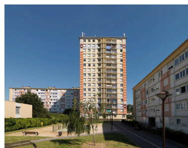
Cité Parat. Vue d'ensemble de la cité Parat, construite en 1962-1966, par P. Durand (architecte), rue du Docteur-Parat. IVR11_20109300142NUC4A
