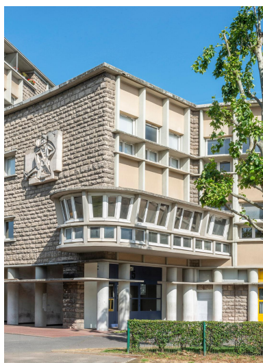
Détail du bureau du proviseur, situé à l'extrémité de l'aile du lycée réservée aux garçons.
