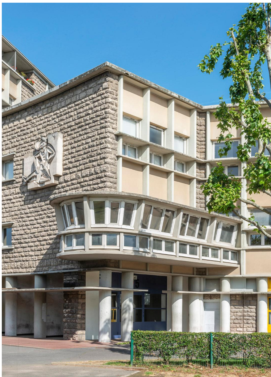
Détail du bureau du proviseur, situé à l'extrémité de l'aile du lycée réservée aux garçons.
