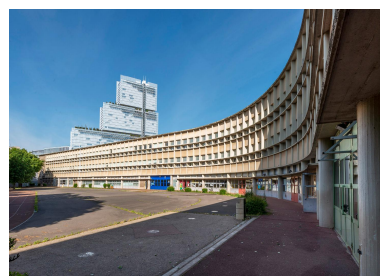
Vue générale de l'aile courbe réservée aux salles de classes des filles. Elle est aujourd'hui affectée au collège. Phot. Laurent Kruszyk IVR11_20207500531NUC4A
