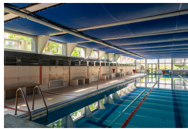
Vue intérieure de la piscine du lycée. Phot. Laurent Kruszyk IVR11_20207500568NUC4A
