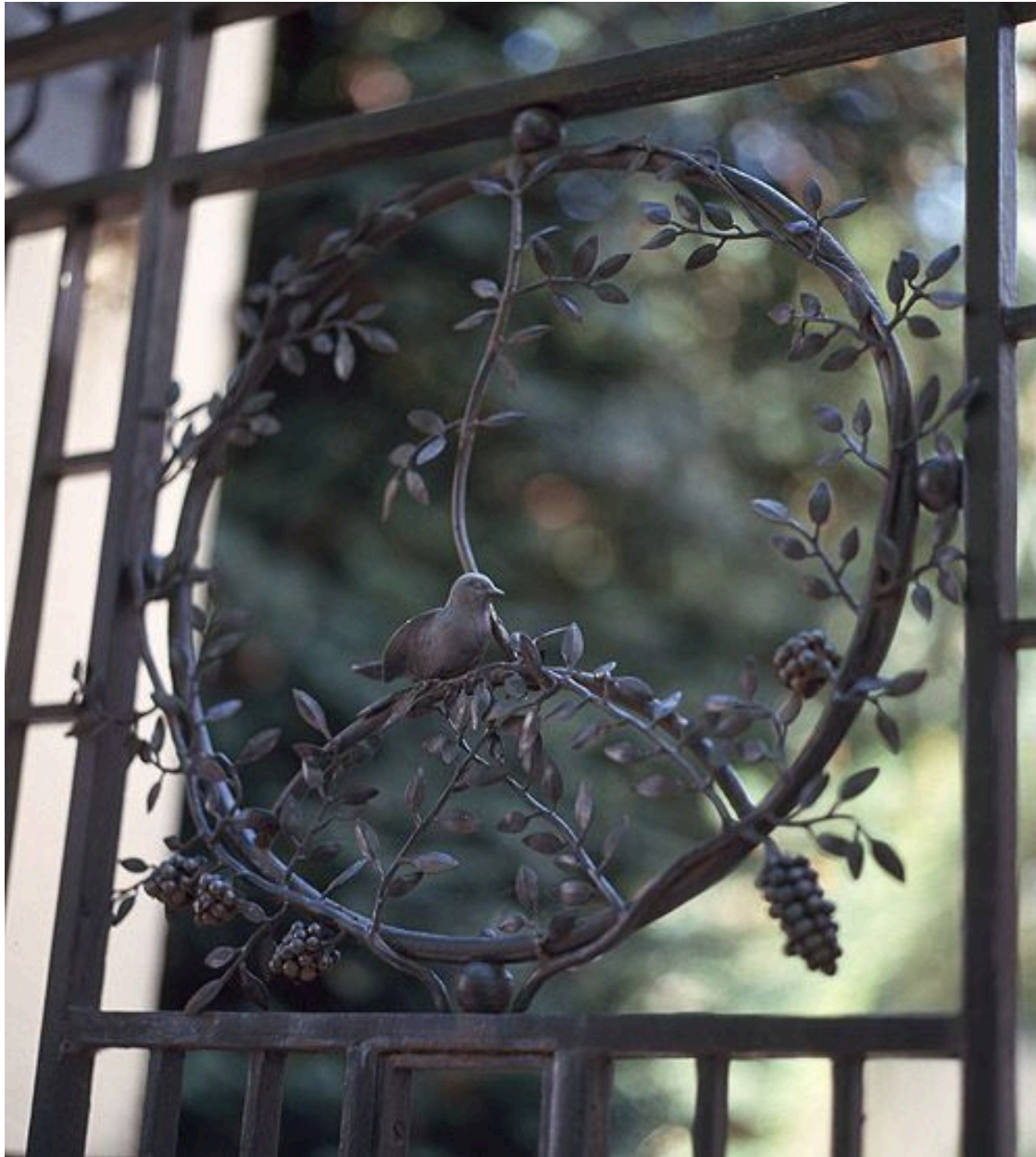
Détail de la porte d'entrée et de son motif ornemental en fer forgé, un oiseau posé sur des branchage.
