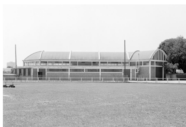
Vue du gymnase prise depuis la piste. Stade Jack-Baudequin Phot. Décamps Christian IVR11_19869400591X
