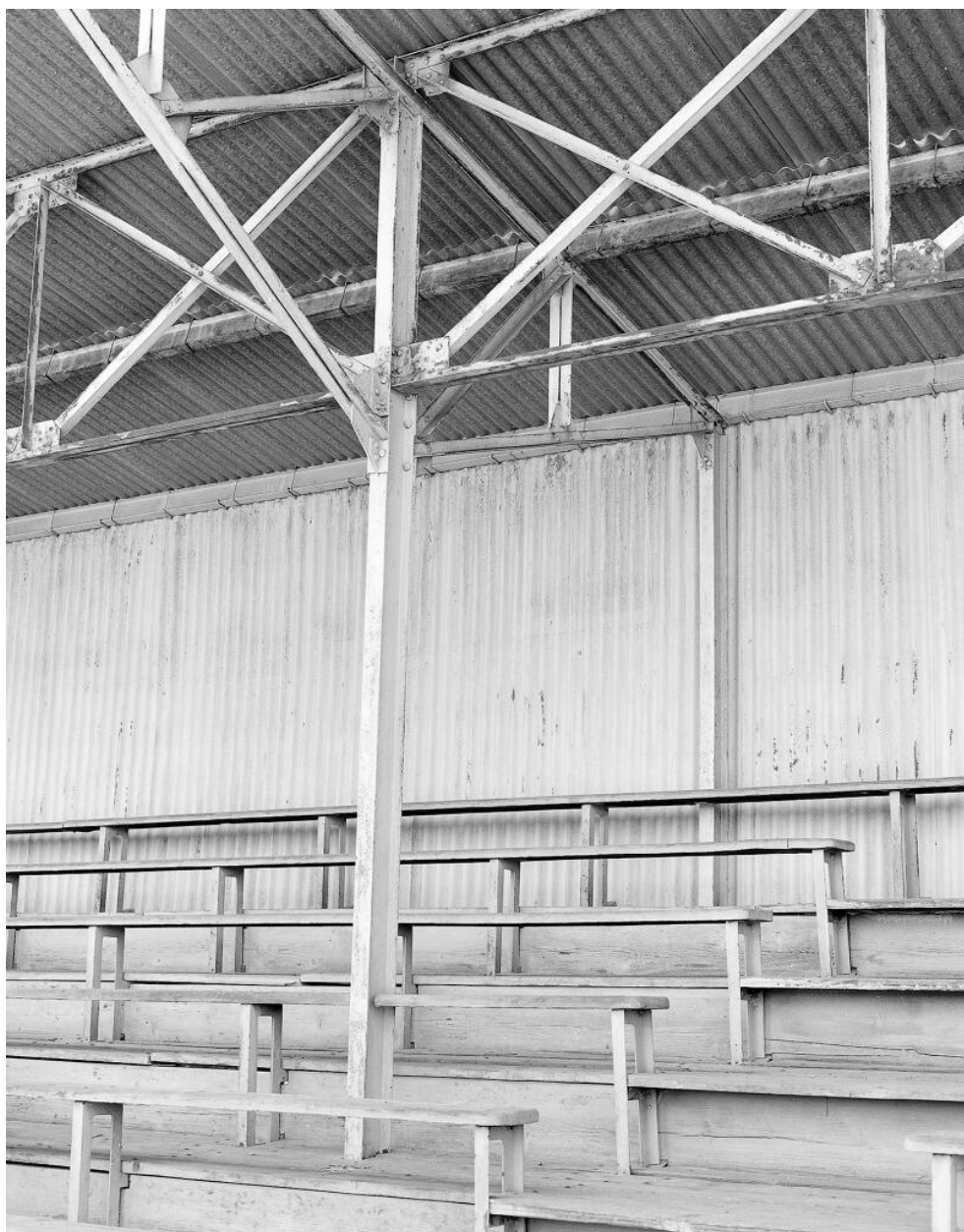
Détail des gradins en bois et de la charpente métallique des tribunes. Stade Jack-Baudequin
