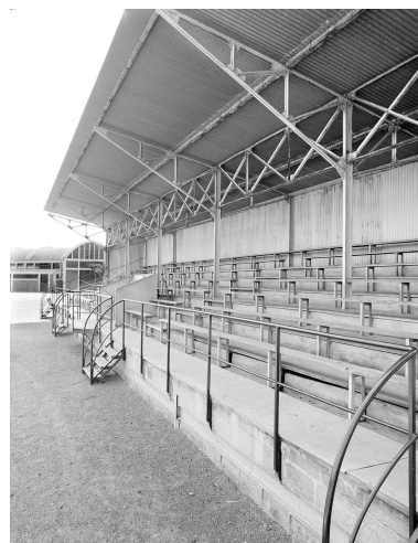
Vue des tribunes. Stade Jack-Baudequin Phot. Décamps Christian IVR11_19869400589X
