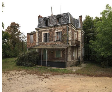
Vue d'ensemble. Phot. Philippe Ayrault IVR11_20089100061NUC4A
