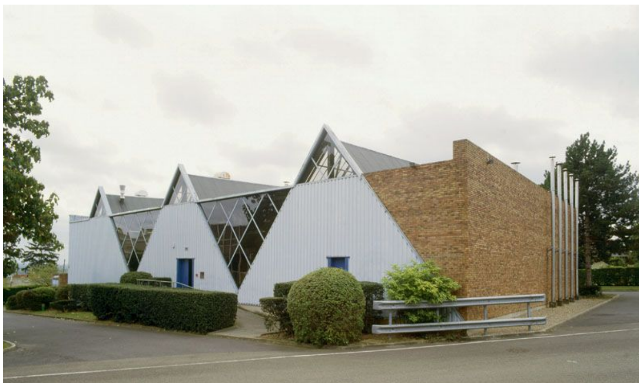
Atelier électro-thermique construit vers 1972.
