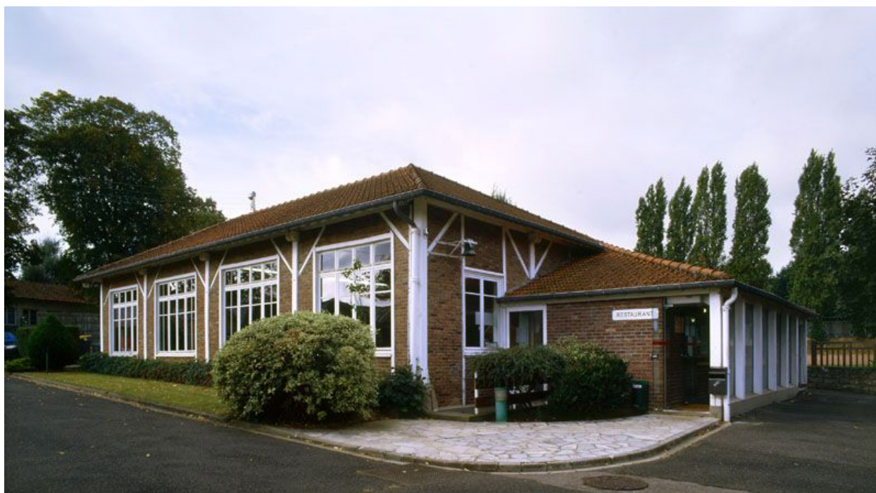
Ancienne salle de cours transformée en réfectoire.
