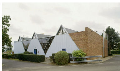
Atelier électro-thermique construit vers 1972. Phot. Laurent Kruszyk IVR11_20067800670XA
