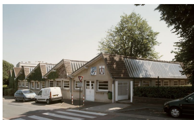
Les ateliers aux toits en sheds se trouvent de l'autre côté de la rue. Phot. Laurent Kruszyk IVR11_20067800662XA
