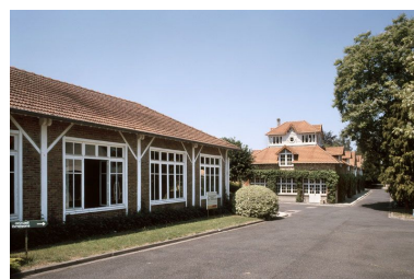
Vue d'ensemble depuis l'entrée ; à gauche d'anciennes salles de cours transformées en réfectoire, au fond l'ancienne ferme.
