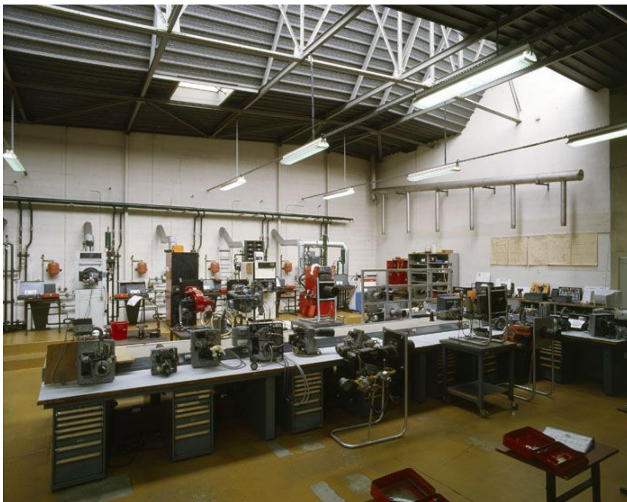
Atelier électro-thermique construit vers 1972 : vue intérieure. On voit les chaudières servant à la formation des élèves.
