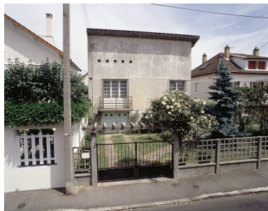
Vue d'ensemble. Phot. Philippe Ayrault IVR11_20019100194XA
