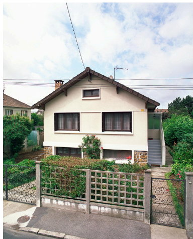
Vue d'ensemble. Phot. Philippe Ayrault IVR11_20049100472XE
