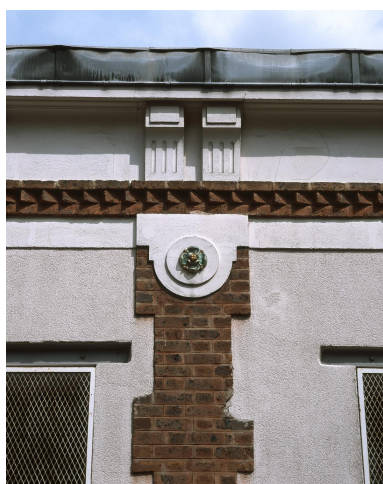
Détail de la façade sur la rue Romain-Rolland : corniche et chaînage de brique. Phot. Laurent Kruszyk IVR11_20049300426XA
