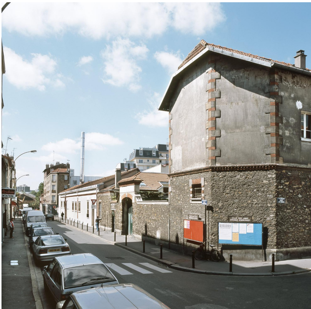
Façade sur la rue Romain-Rolland.
