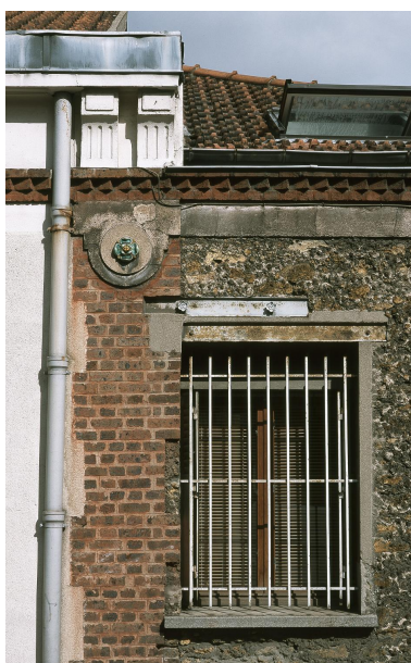
La façade sur la rue Romain-Rolland associe brique et meulière
