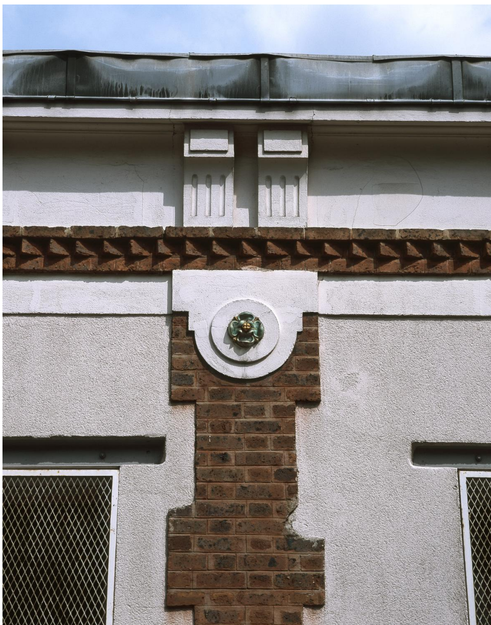
Détail de la façade sur la rue Romain-Rolland : corniche et chaînage de brique.
