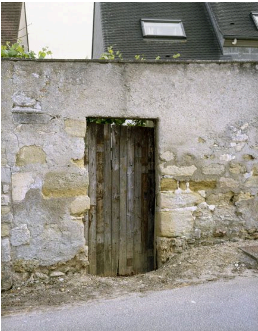
Maurecourt. Une porte d'accès à un ancien clos, sente des basses vignes.
