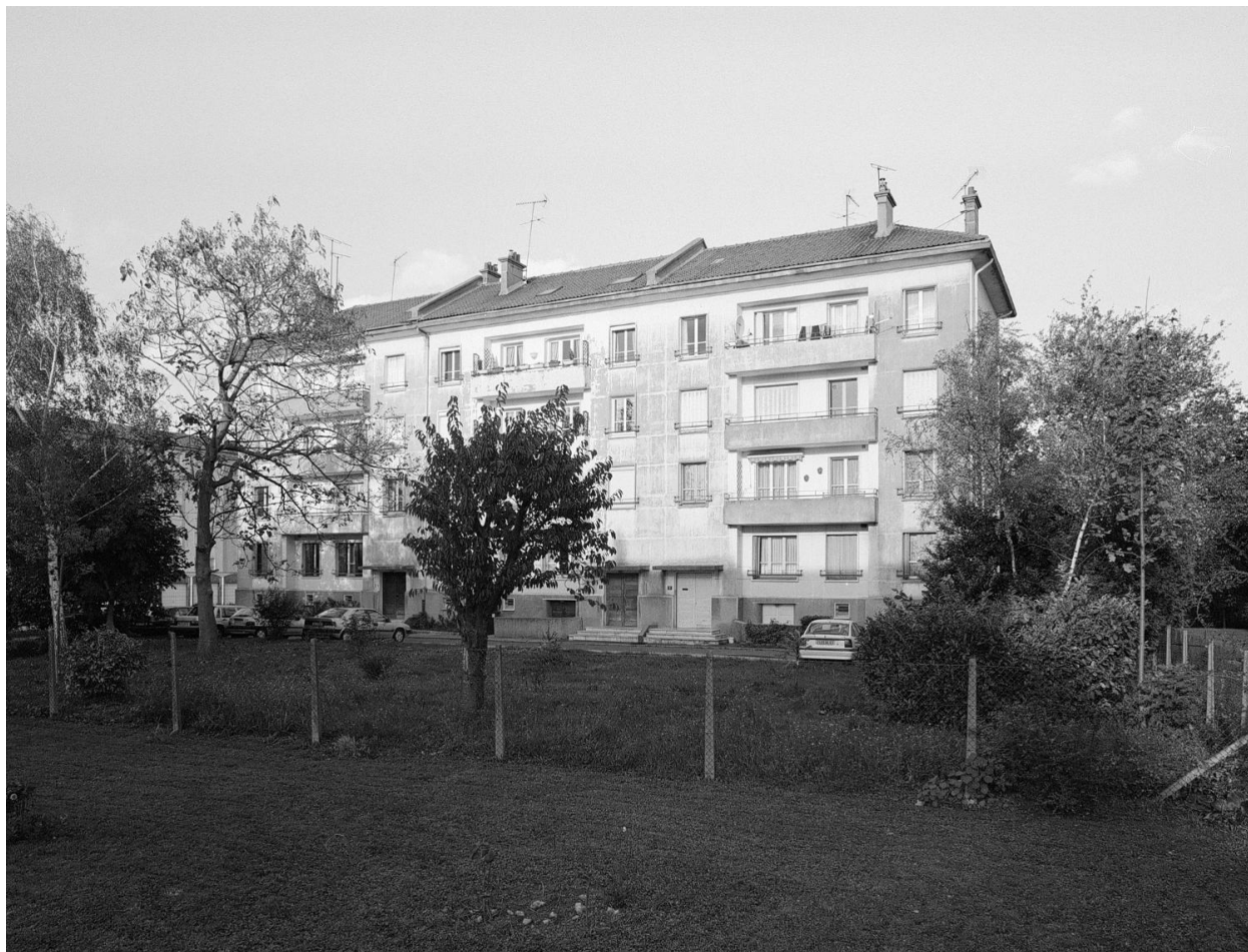
L'immeuble situé à gauche du square (immeuble Sourdeau, Expert et Froment) : façade sud-ouest.
