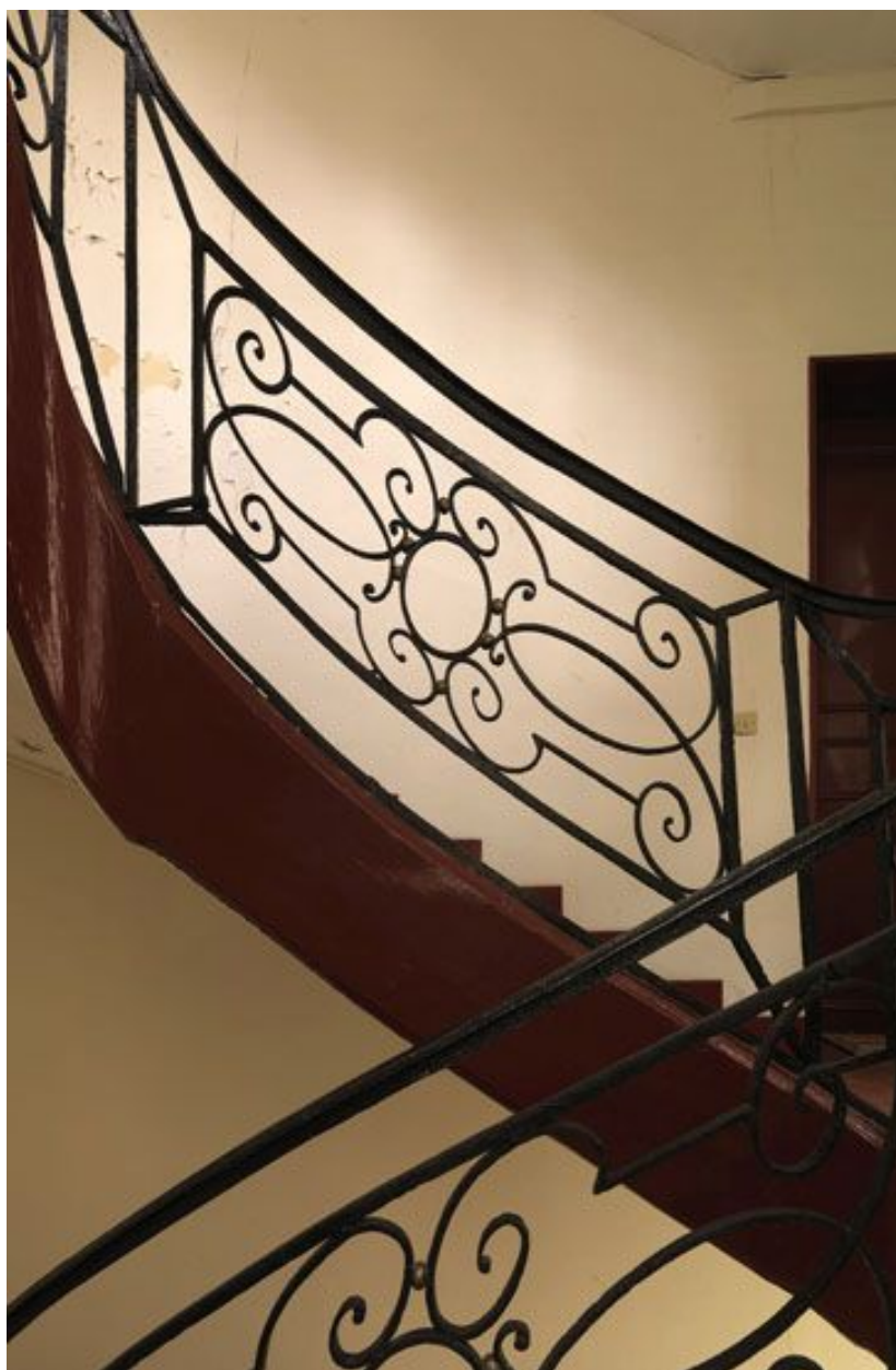
Vue d'un panneau d'un autre escalier de la deuxième cour.
