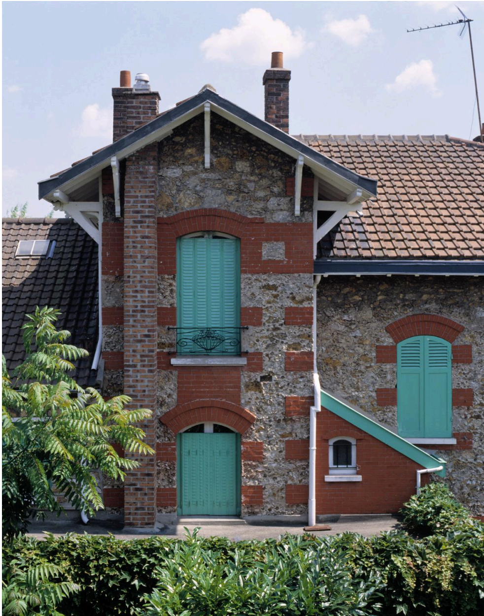
Détail de la façade latérale de la maison du 3, Villa Jeanne.
