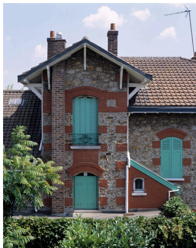
Détail de la façade latérale de la maison du 3, Villa Jeanne. Phot. Philippe Ayrault IVR11_20029101033XA
