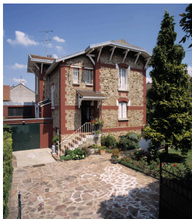
Vue d'ensemble de la maison du n° 5, Villa Jeanne. Phot. Philippe Ayrault IVR11_20029101041XA
