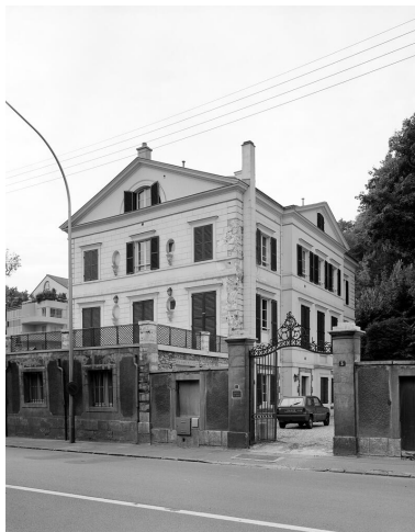
Elévation de la façade latérale sur le quai. Phot. Vialles Jean-Bernard IVR11_19867801185V
