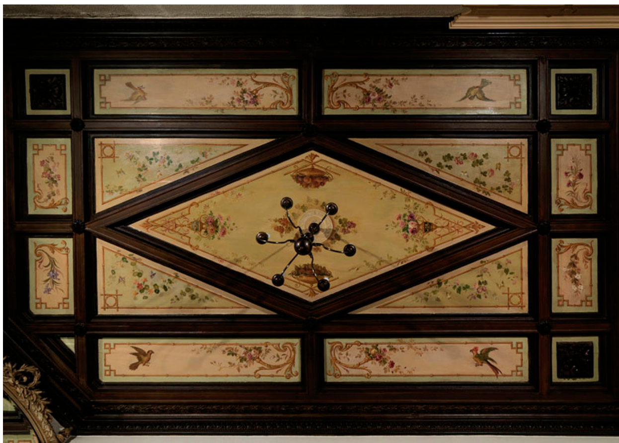
Vue d'ensemble du plafond.
