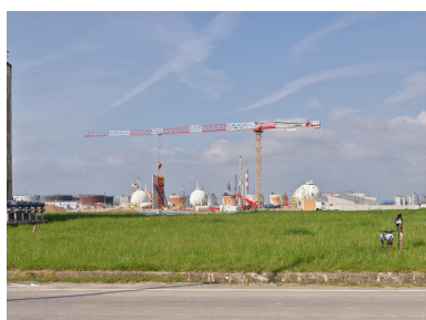
Vue générale de la zone du projet pyrolyse en chantier, depuis la zone du traitement des eaux.
