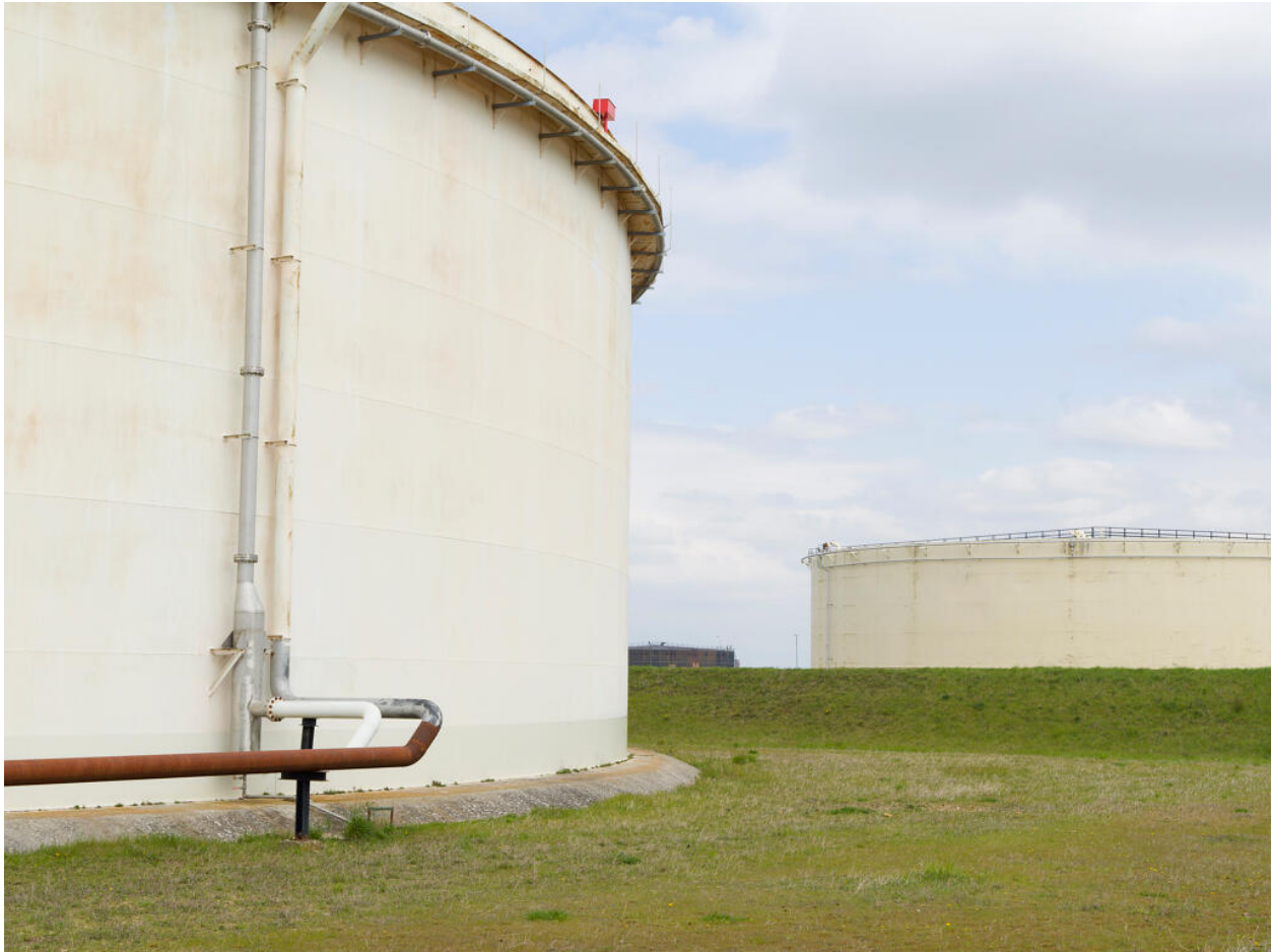
Zone 320, Mouvement de produits. Au premier plan, le bac D 75 (à toit flottant). En arrière-plan, le bac D 74 (à toit fixe).
