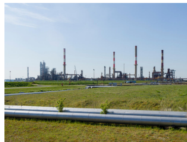
À droite, Unités Ouest (trois cheminées) et à gauche, les Unités Est (une cheminée). Au premier plan, un pipeway dédié au mouvement des produits.
