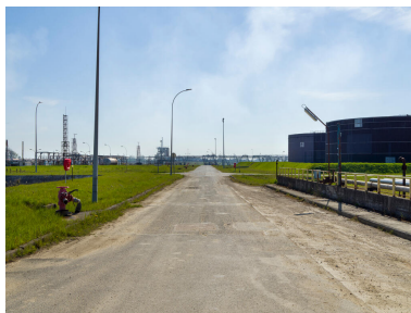
À gauche, la zone de chargement GPL route et fer, au centre, chargement et déchargement de produits noirs route et fer.
