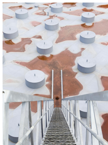
Zone 320, Mouvement de produits. L'escalier menant sur le toit flottant du bac D 75.
