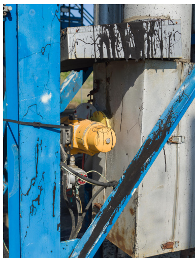
Zone bitume (Unité 570). Quais de chargement bitume. Vanne automatique pour prise d'échantillon bitume. Phot. Stéphane Asseline, Phot. Stéphane Asseline IVR11_20237700335NUC4A
