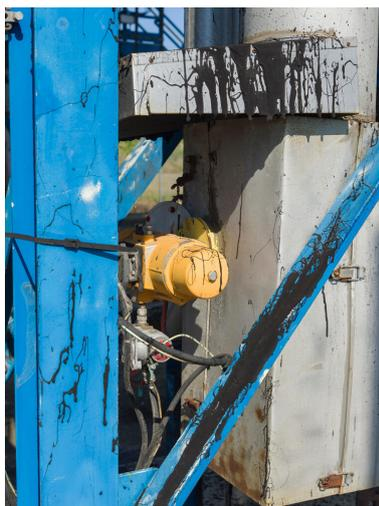
Zone bitume (Unité 570). Quais de chargement bitume. Vanne automatique pour prise d'échantillon bitume.
