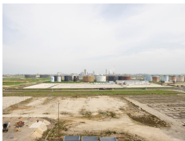
Base de vie Galaxie au second plan, puis les bacs de stockage. À l'arrière-plan, l'usine d'engrais Borealis. Phot. Stéphane Asseline, Phot. Stéphane Asseline IVR11_20237700064NUC4A
