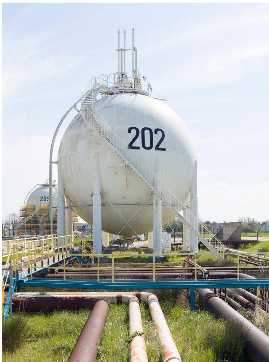
Zone 320, Mouvement de produits. Vue sur la sphère de stockage de gaz D 202.
