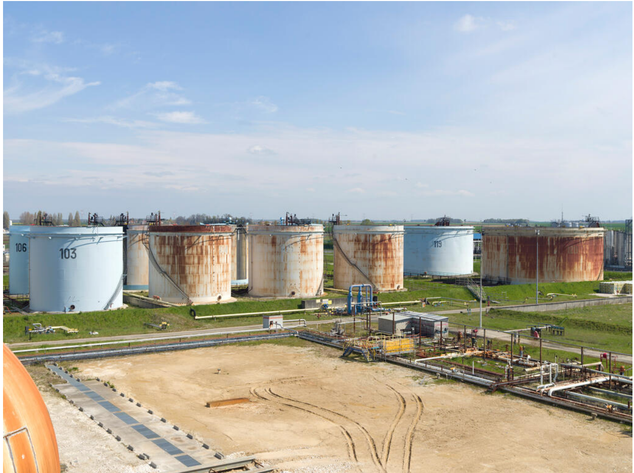
Zone 320, Mouvement de produits. Vue sur les bacs de stockage depuis une sphère D 202 (stockage de GPL).
