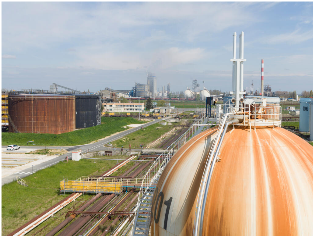
Vue générale depuis le sommet de la sphère GPL D202 sur des stockages et la zone d'expédition.
