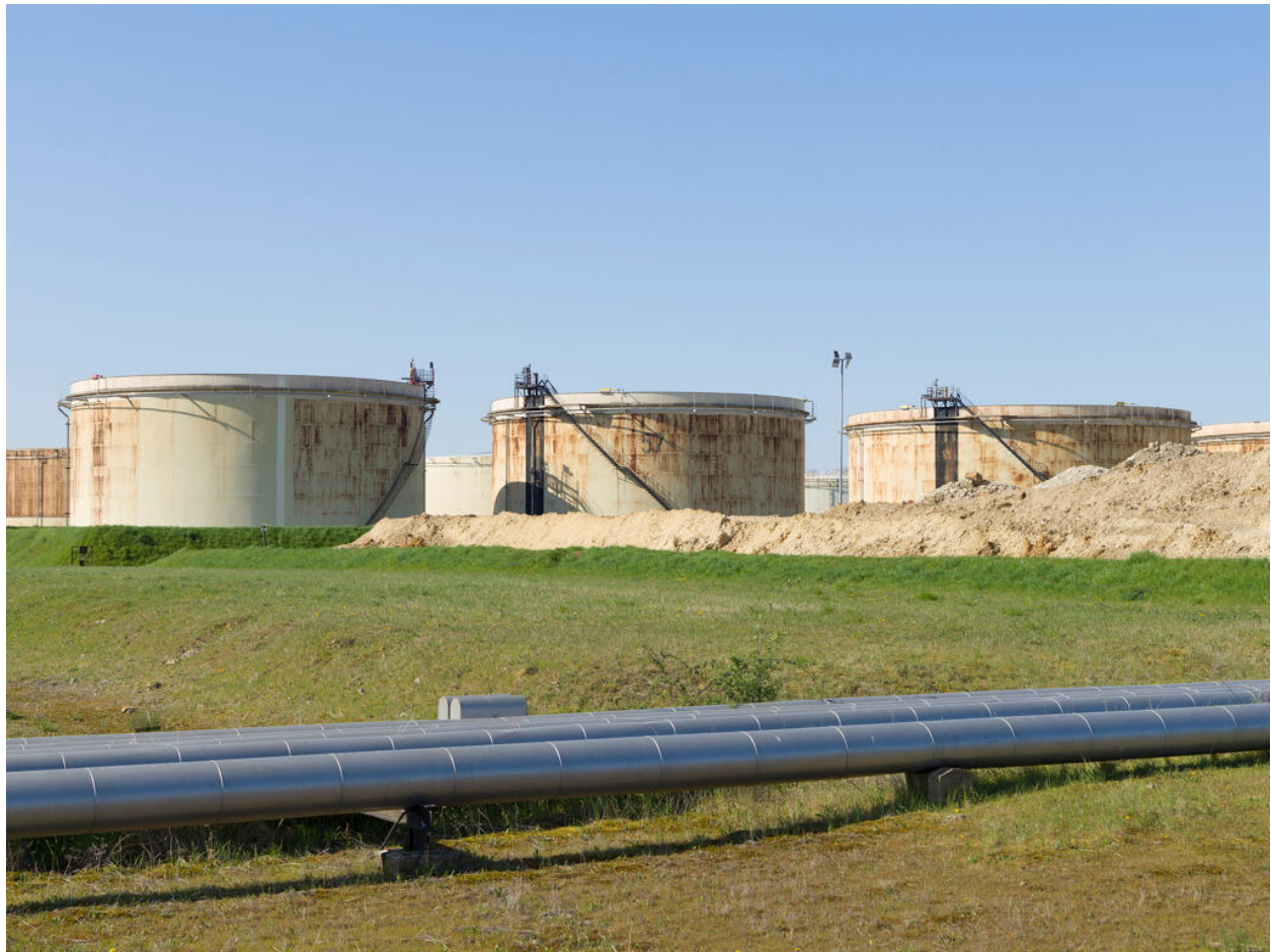
Zone 320, Mouvement de produits. Vue sur les bacs D 56, D 57, et D 59. Au premier plan, le pipeway.
