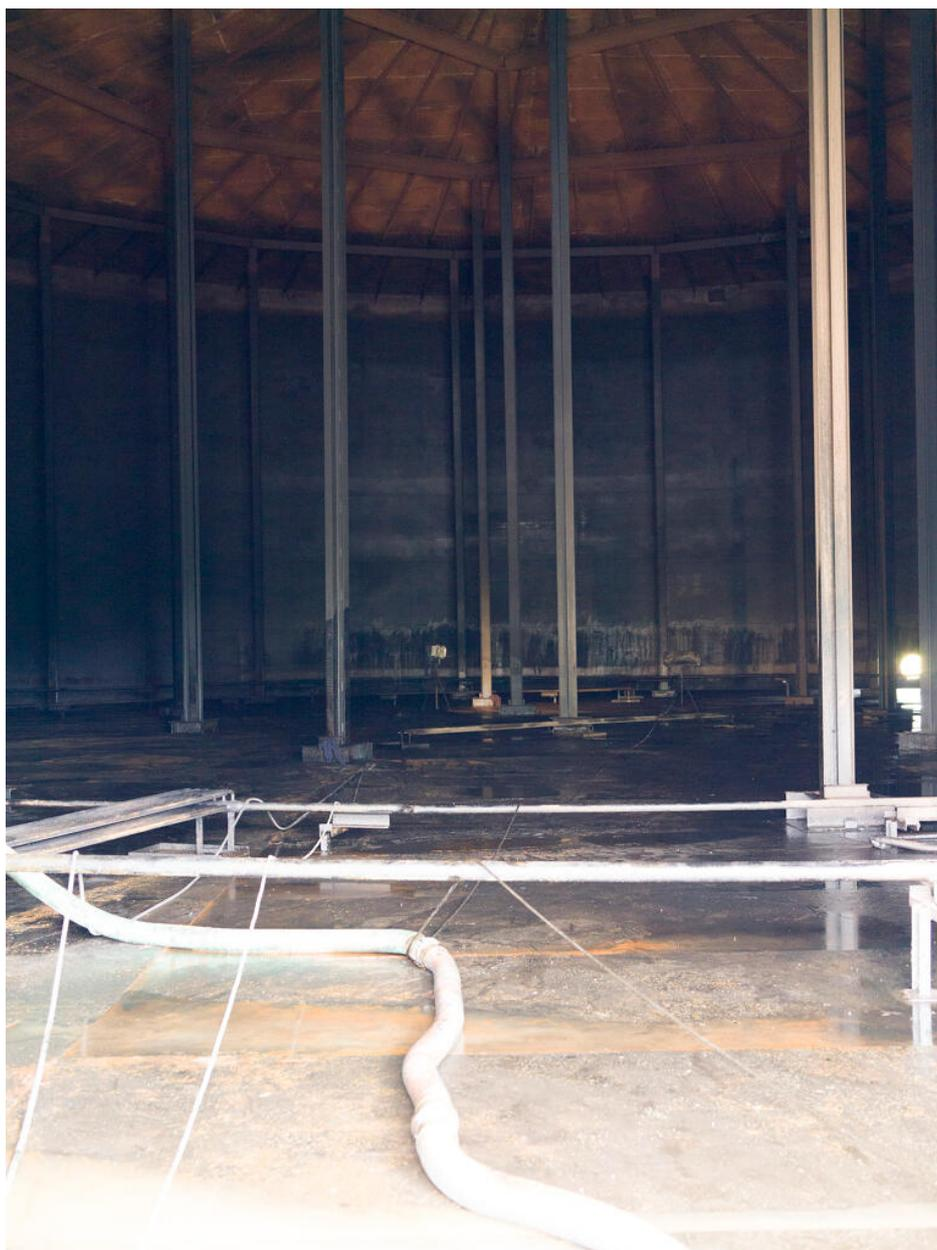
Zone 320, Mouvement de produits. Bac "sur béquilles", qui permettent de tenir le toit flottant quand le bac est vide, en cours de nettoyage.
