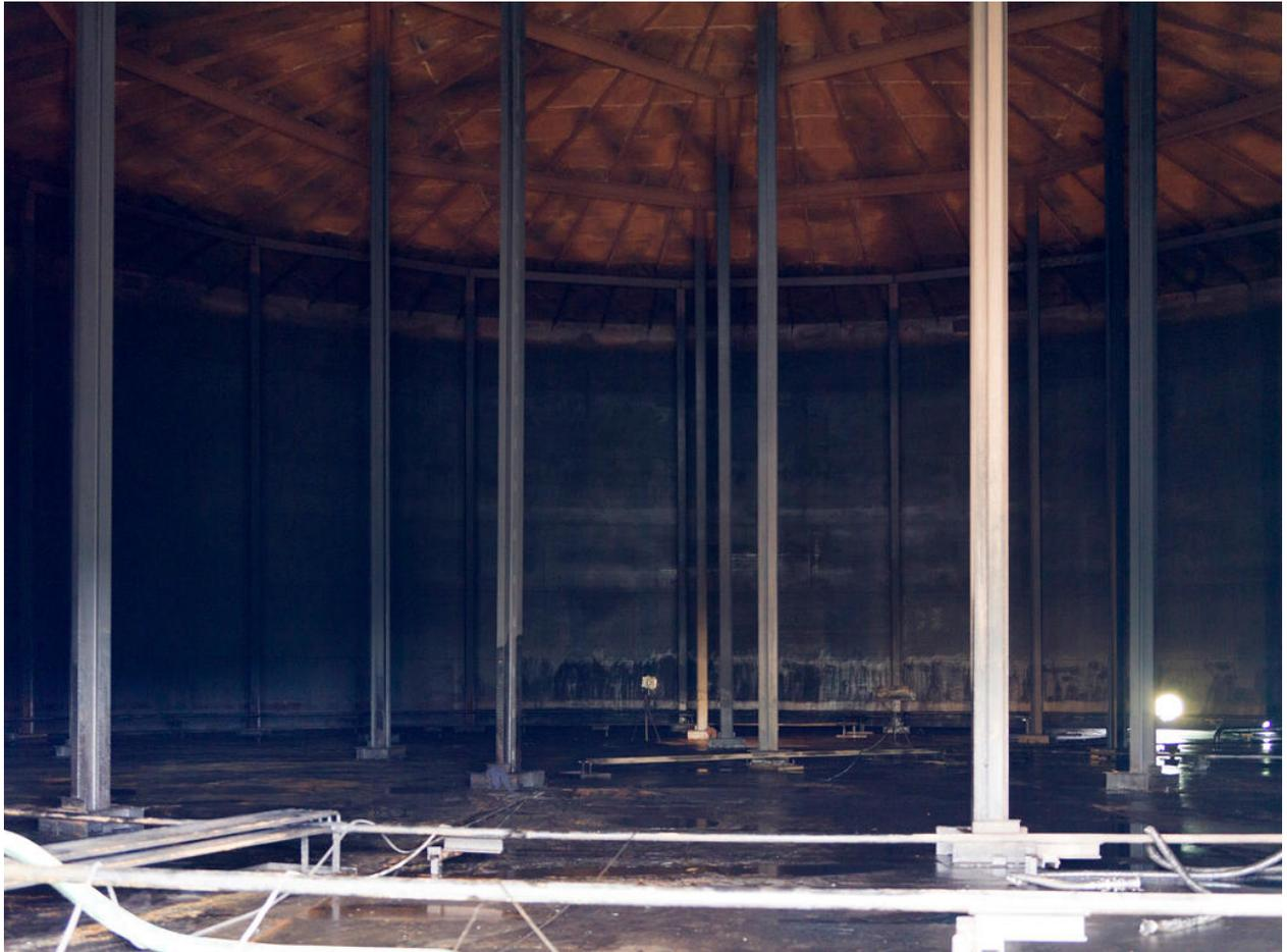
Zone 320, Mouvement de produits. Bac "sur béquilles", qui permettent de tenir le toit flottant quand le bac est vide, en cours de nettoyage.
