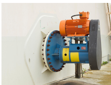
Zone 320, Mouvement de produits. Agitateur du bac D 75.
