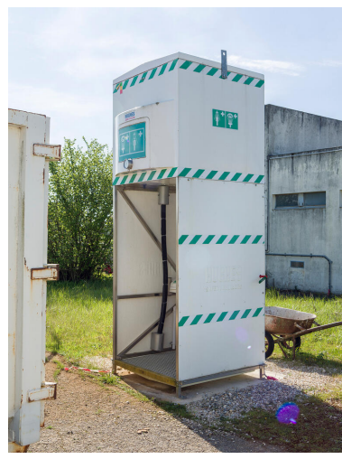
Zone bitume (Unité 570). Douche Autonome de Sécurité (DAP), utilisée en cas d'incident. Phot. Stéphane Asseline, Phot. Stéphane Asseline IVR11_20237700337NUC4A
