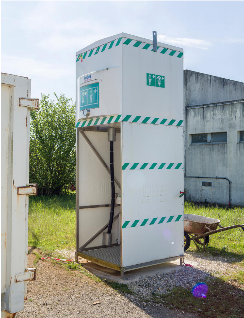
Zone bitume (Unité 570). Douche Autonome de Sécurité (DAP), utilisée en cas d'incident.
