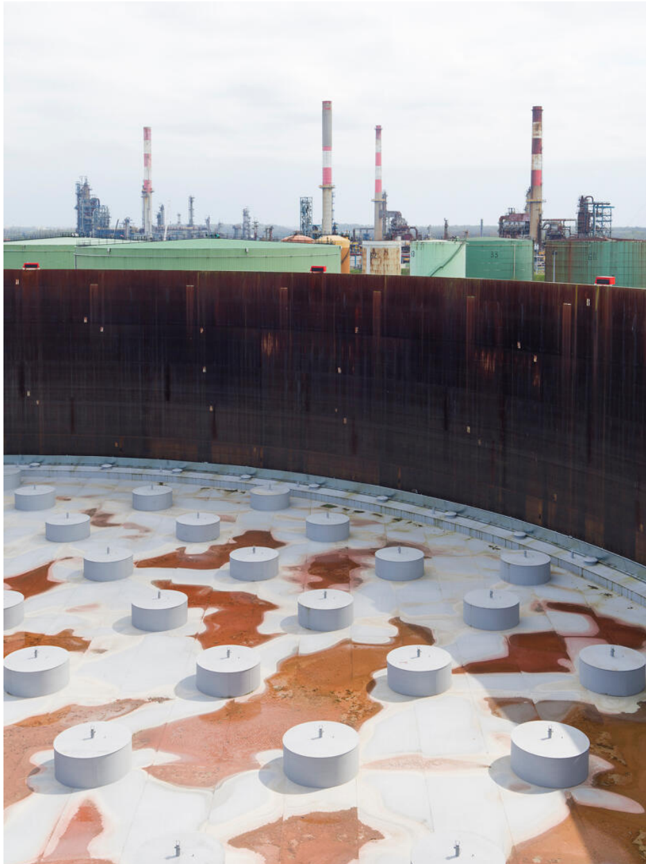
Zone 320, Mouvement de produits. Au premier plan, toit flottant du bac D 75. Au fond à droite, les unités de production.
