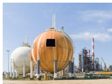
Zone 320, Mouvement de produits. Vue sur la sphère de stockage de gaz D 201 depuis le sommet de la sphère D 202. Une première "fenêtre" a été ouverte au chalumeau, en vue de son démantèlement. Phot. Stéphane Asseline, Phot. Stéphane Asseline
