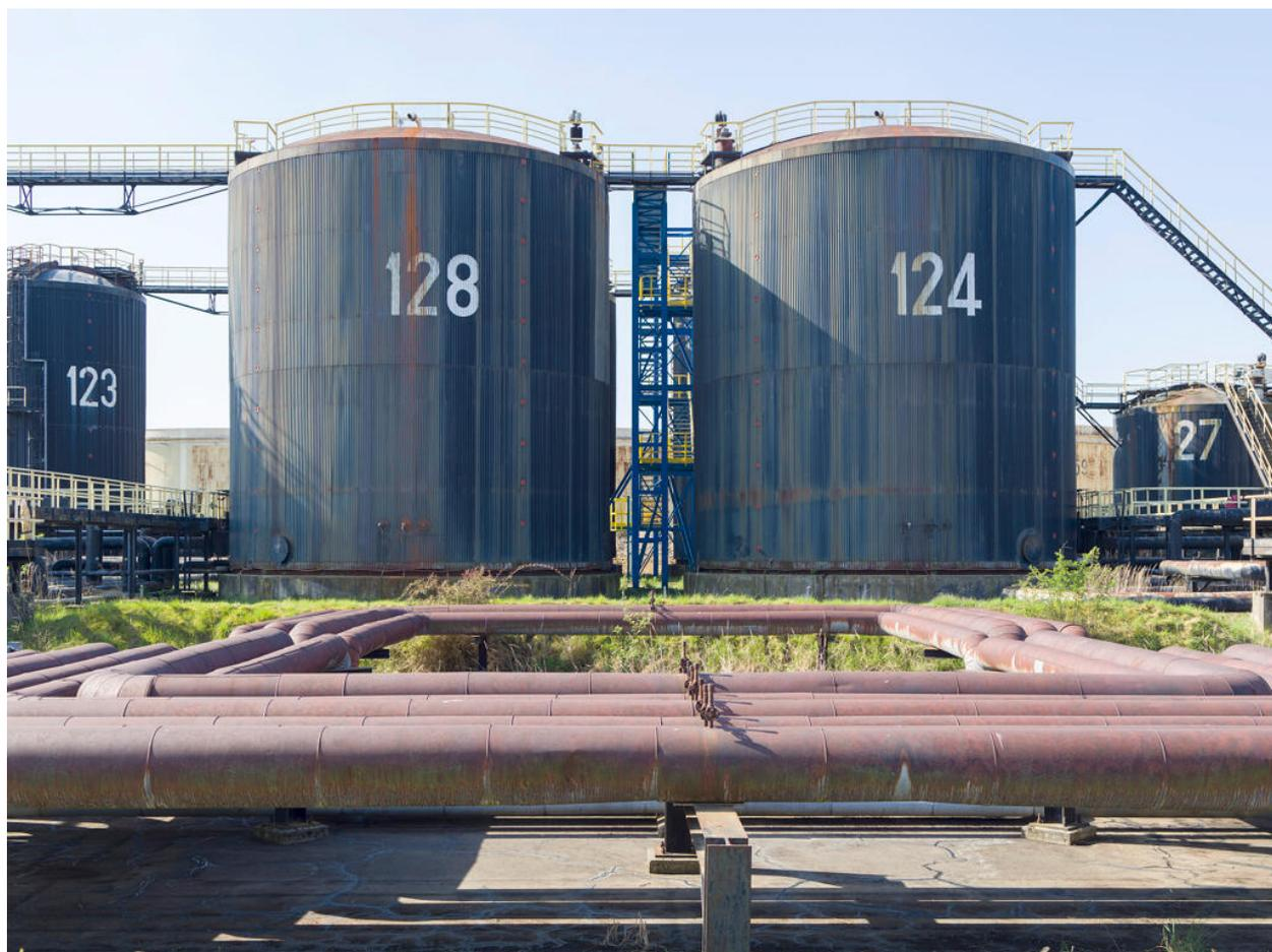
Zone bitume (Unité 570). Bacs de stockage (prêts à expédier) bitume 122 (160 220) et 128 (35 50). Les chiffres correspondent au nombre de millimètre qui pénètrent dans le bitume à un moment donné (par rapport à l'utilité des bitumes : différentes qualités selon les routes). Les bacs sont en acier, puis laine de roche. Réchauffage à bain d'huile (+ de 170°C). Les canalisations devant correspondent à la lyre de dilatation (circulation de bitume, tuyauterie pour le transport de bitume).
