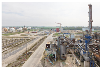
Vue générale des stockages de gaz liquéfié depuis le troisième étage du FCC. Phot. Stéphane Asseline, Phot. Stéphane Asseline IVR11_20237700063NUC4A
