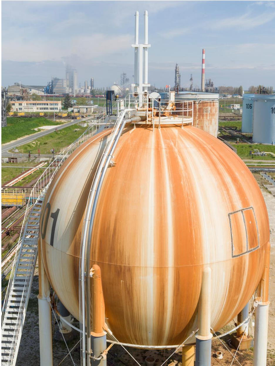
Zone 320, Mouvement de produits. Vue sur la sphère de stockage de gaz D 201 depuis le sommet de la sphère D 202. Une première "fenêtre" a été ouverte au chalumeau, en vue de son démantèlement.
