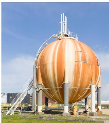
Zone 320, Mouvement de produits. Vue sur la sphère de stockage de gaz D 201. Une première "fenêtre" a été ouverte au chalumeau, en vue de son démantèlement.
