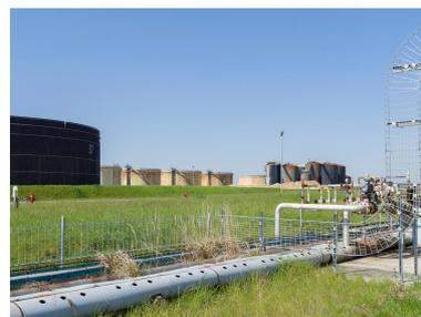
Zone 320, Mouvement de produits. Vue sur les bacs de bitume, à droite. Au premier plan, pipeway et chemin de câbles.
