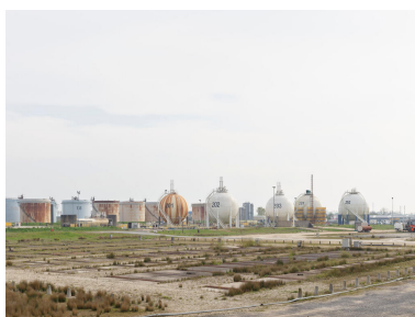
Vue générale des stockages de gaz liquéfié depuis les Unités Est.
