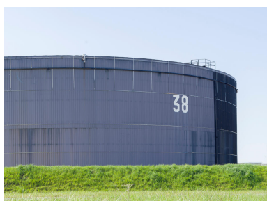
Zone 320, Mouvement de produits. Bac de produits noirs. Les bacs sont calorifugés (isolés avec de la laine de roche), afin de maintenir la chaleur dans le bac.
