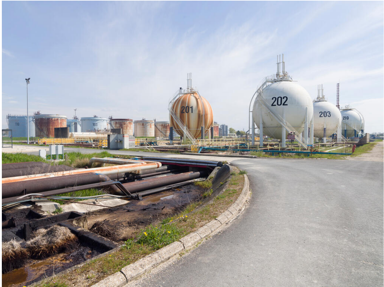
Zone 320, Mouvement de produits. Vue sur la zone des sphères de stockage de gaz.
