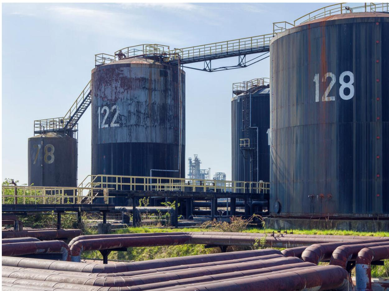
Zone bitume (Unité 570). Bacs de stockage (près à expédier) bitume 122 (160 220) et 128 (35 50). Les chiffres correspondent au nombre de millimètre qui pénètrent dans le bitume à un moment donné (par rapport à l'utilité des bitumes, différentes qualités selon les routes). Les bacs sont en acier, puis laine de roche. Réchauffage à bain d'huile (+ de 170°C). Les canalisations devant : lyre de dilatation (circulation de bitume, tuyauterie pour le transport de bitume).
