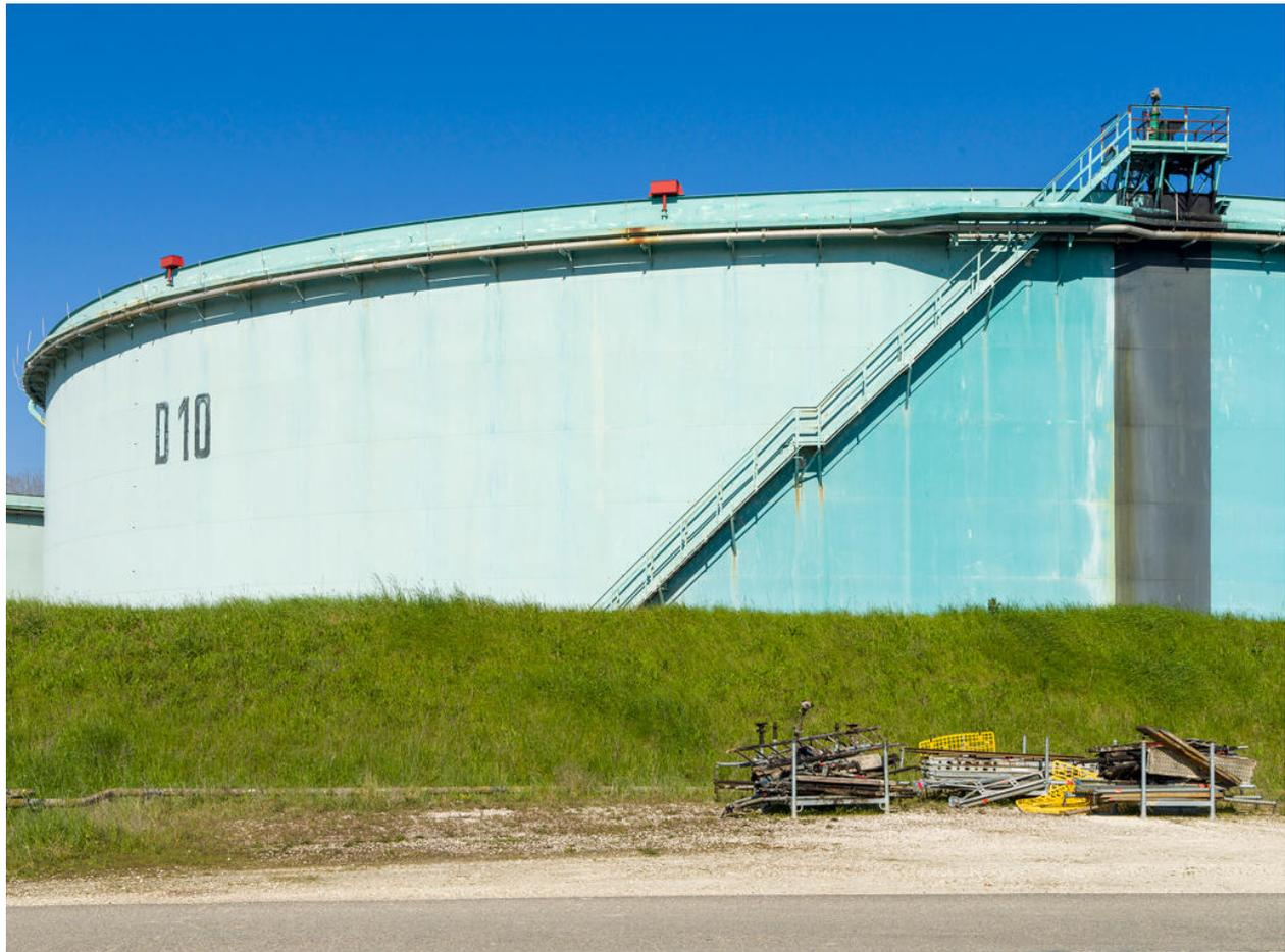
Zone 320, Mouvement de produits. Vue sur le bac de pétrole brut D 10, un des plus gros bac de stockage (60 000 m<sup>3</sup>)
