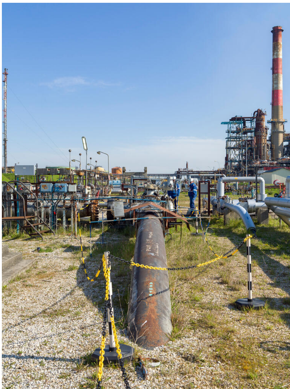
Arrivée du pipe (Unité 560). Arrivée du pipeline d'Île-de-France sur le site de Grandpuits. Fin d'exploitation en 2021.
