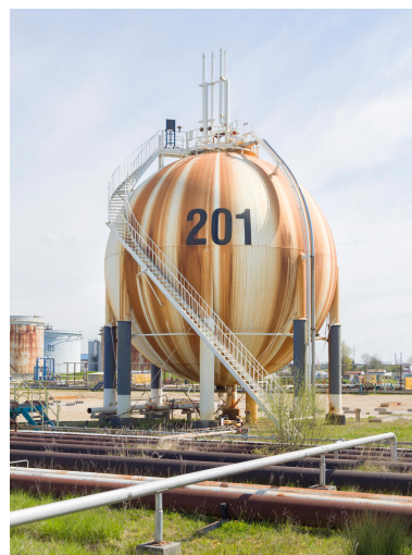
Zone 320, Mouvement de produits. Vue sur la sphère de stockage de gaz D 201. Cette sphère ne sera pas conservée. Phot. Stéphane Asseline, Phot. Stéphane Asseline IVR11_20237700318NUC4A
