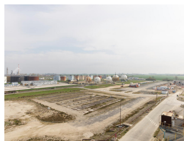
Vue de la construction du projet pyrolyse, au fond à droite, depuis le troisième étage du FCC.
