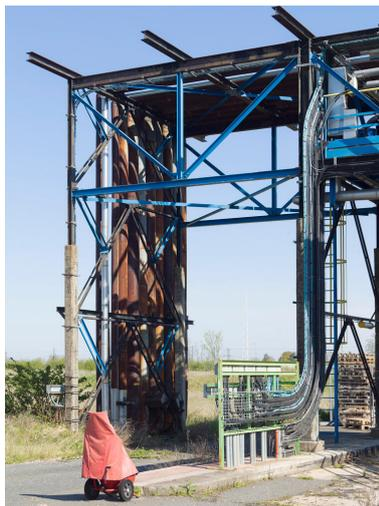
Zone bitume (Unité 570). Quais de chargement bitume. Ligne d'arrivée bitume. Prise d'échantillon bitume. Égouttures du bras de chargement bitume (envoi à la destruction, déchets pétroliers).
