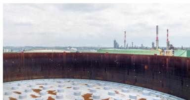
Zone 320, Mouvement de produits. Au premier plan, toit flottant du bac D 75. Au fond à droite, les unités de production.
