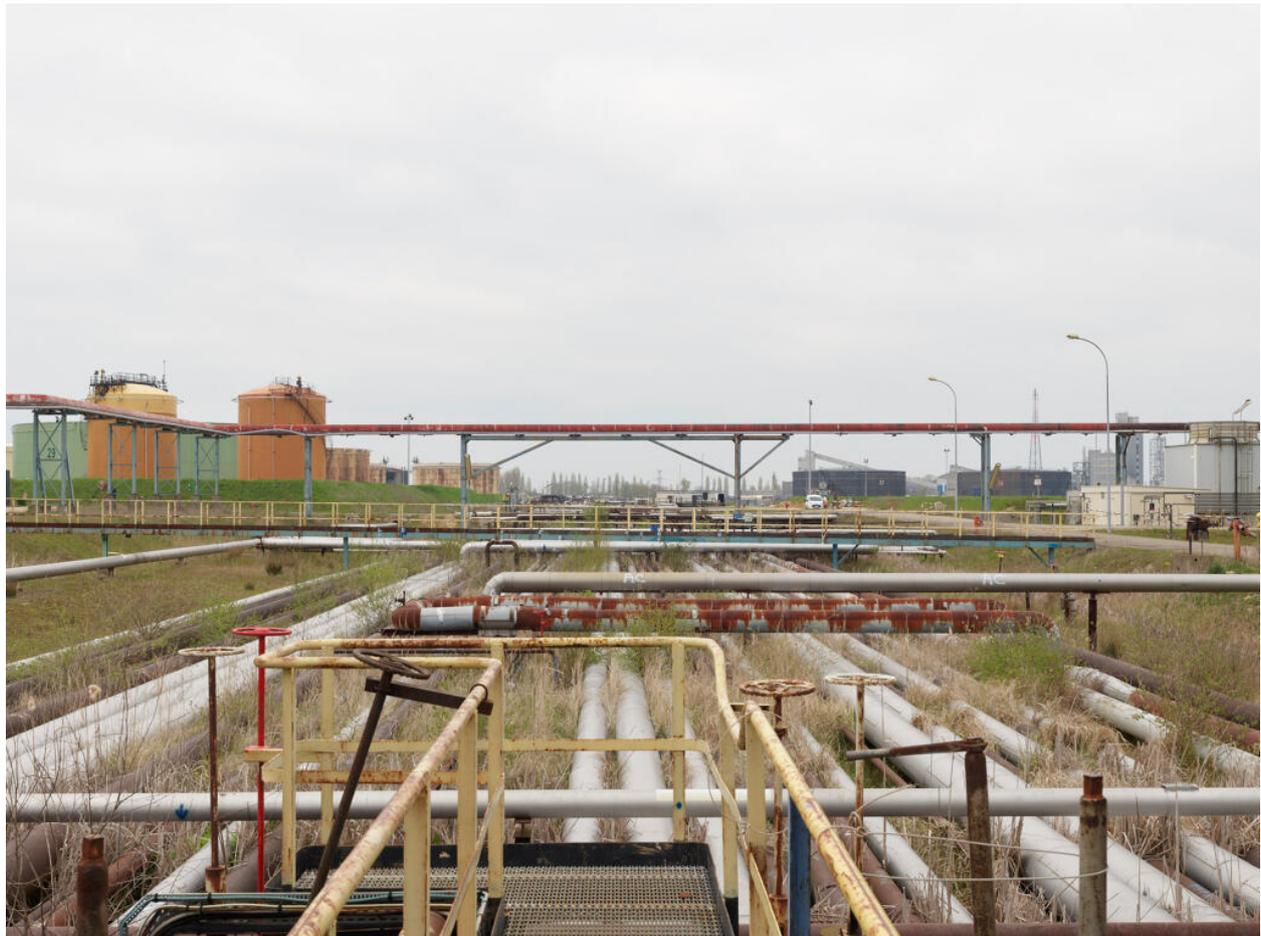
À l'ouest des Unités Ouest. Au premier plan, pipeway destiné à la distribution de différentes qualités de GPL vers le stockage. Au fond, ligne de torches (pour combustion des gaz résiduels) sur structure métallique.
