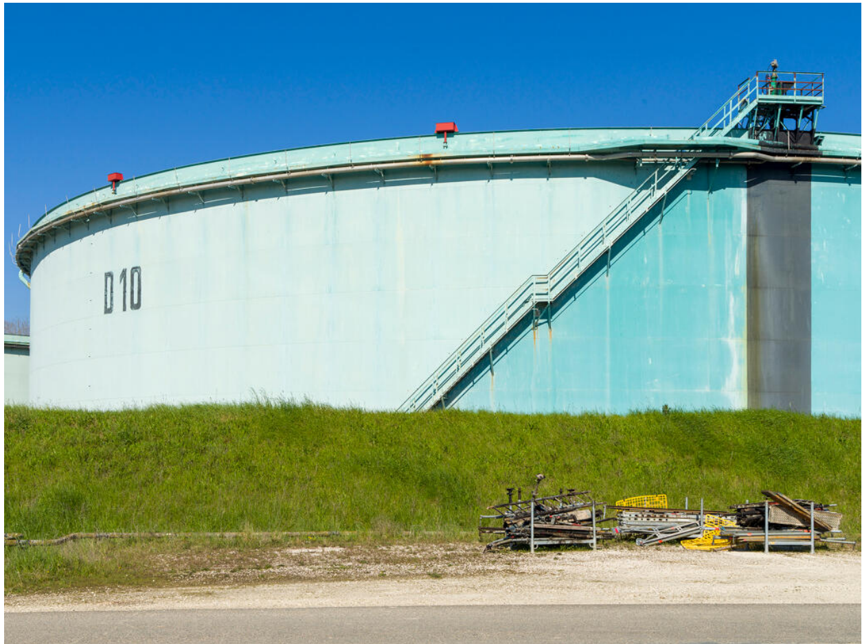
Zone 320, Mouvement de produits. Vue sur le bac de pétrole brut D 10, un des plus gros bac de stockage (60 000 m 3 )
