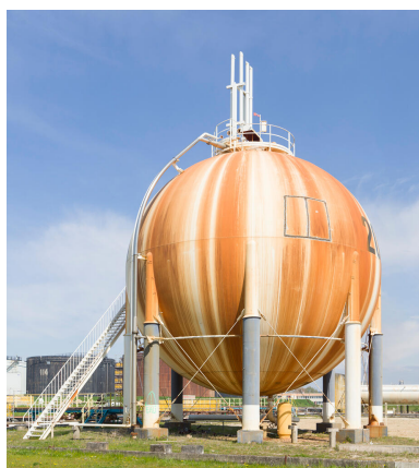
Zone 320, Mouvement de produits. Vue sur la sphère de stockage de gaz D 201. Une première "fenêtre" a été ouverte au chalumeau.
