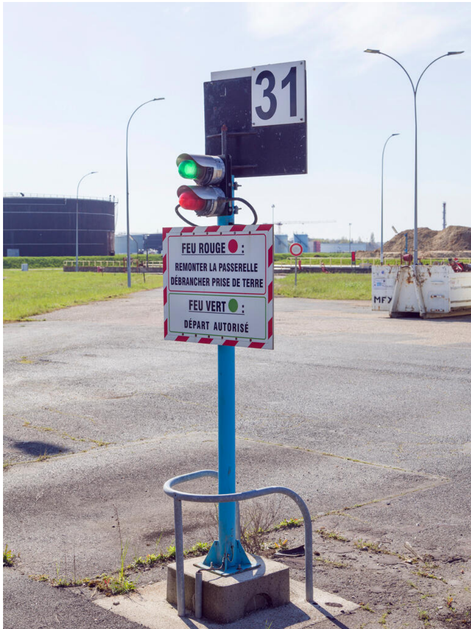
Zone bitume (Unité 570). Signalétique de mise à la terre des véhicules pendant leur chargement.
