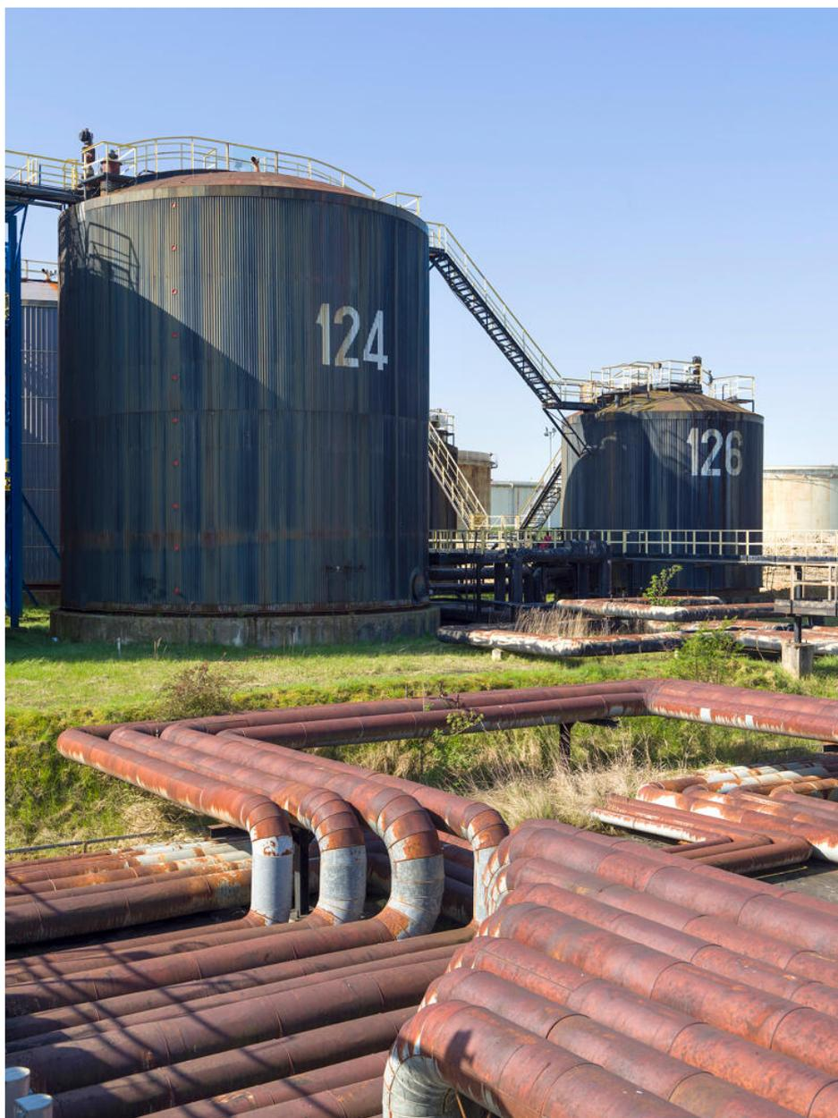
Zone bitume (Unité 570). Bacs de stockage (prêts à expédier) bitume 122 (160 220) et 128 (35 50). Les chiffres correspondent au nombre de millimètre qui pénètrent dans le bitume à un moment donné (par rapport à l'utilité des bitumes : différentes qualités selon les routes). Les bacs sont en acier, puis laine de roche. Réchauffage à bain d'huile (+ de 170°C). Les canalisations devant correspondent à la lyre de dilatation (circulation de bitume, tuyauterie pour le transport de bitume).
