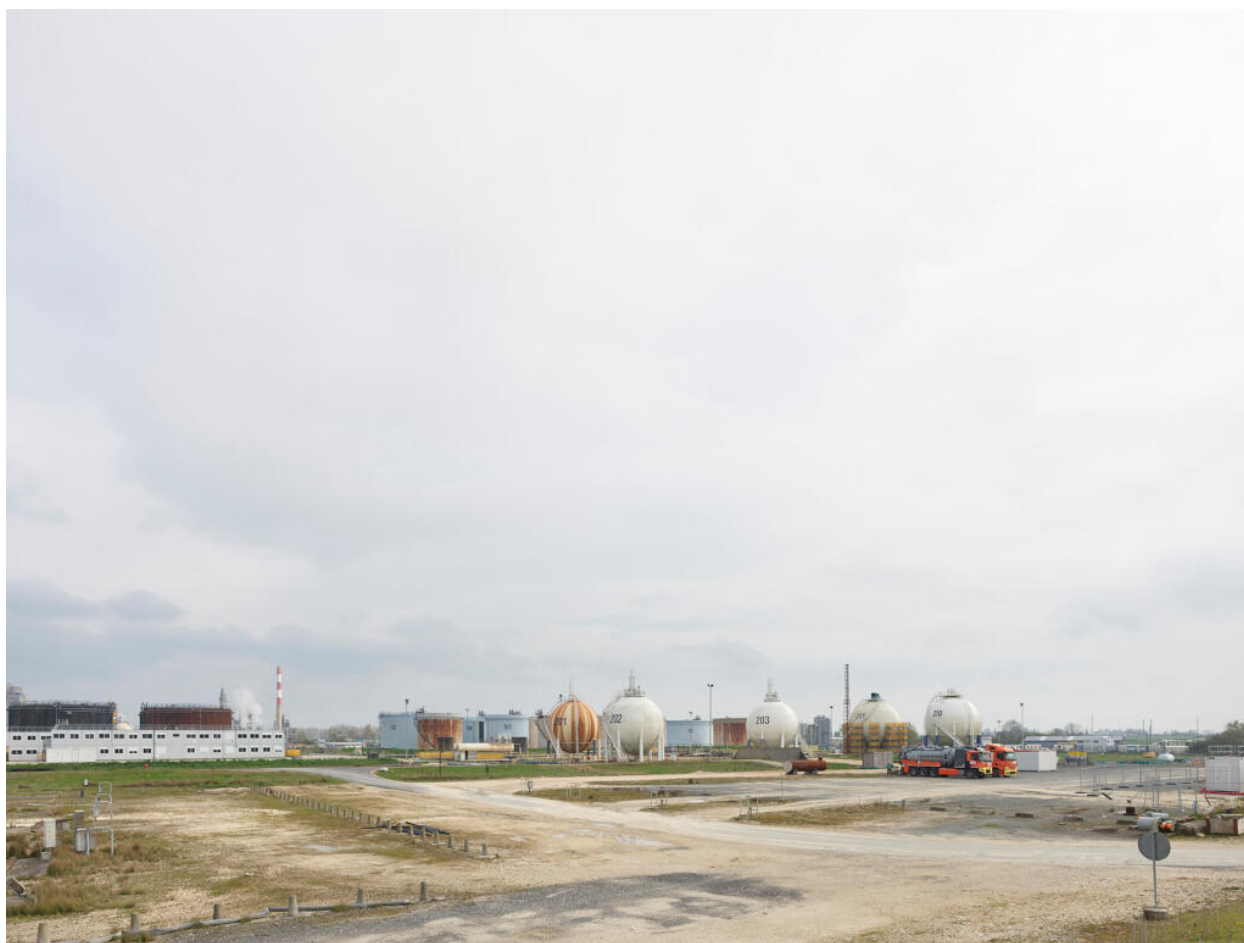
Vue générale des stockages de gaz liquéfié depuis les Unités Est.
