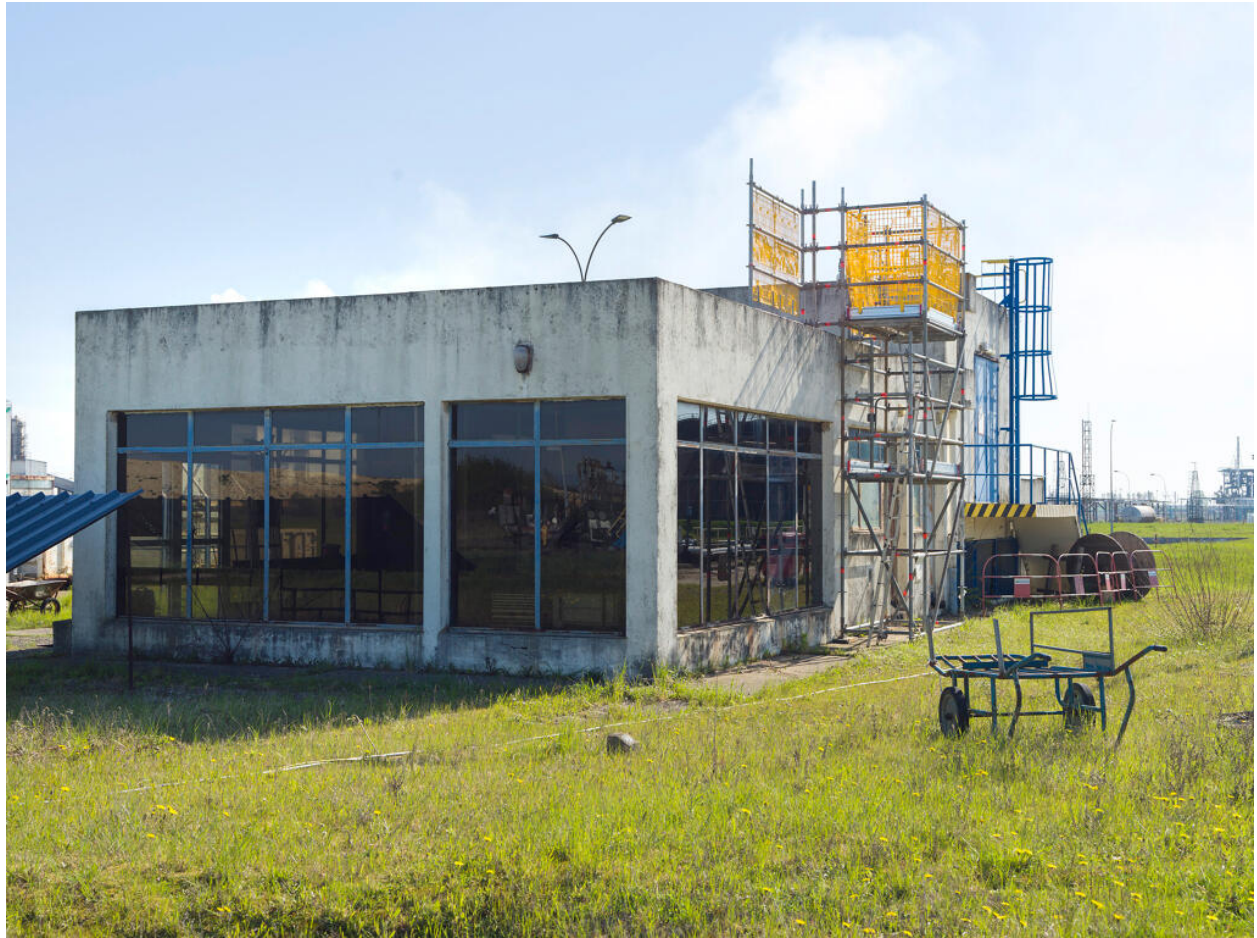
Zone bitume (Unité 570). Ancienne salle de contrôle bitume, encore en service entre 1994 et 2000. Désaffectée à la fin des années 1990, avant la fusion (fusion Elf et Total en 2001). Salle d'archives temporaires, puis espace de stockage.
