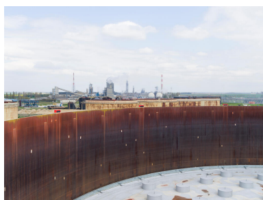
Zone 320, Mouvement de produits. Le toit flottant du bac D 75. Au fond, l'usine d'engrais Boréal.
