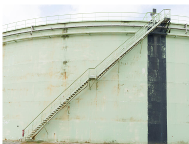
Zone 320, Mouvement de produits. Escalier menant sur le toit du bac D 79.
