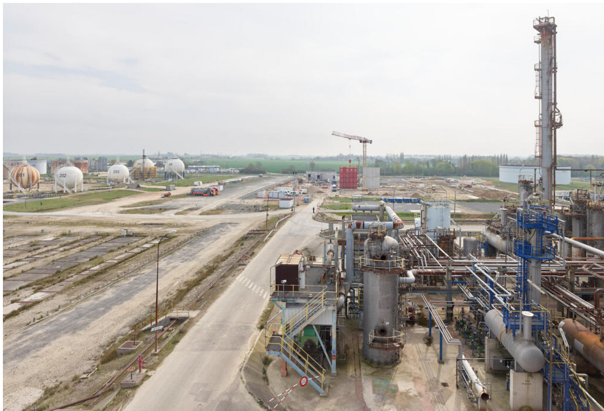
Vue générale des stockages de gaz liquéfié depuis le troisième étage du FCC.
