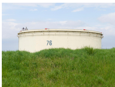
Zone 320, Mouvement de produits. Le bac D 76 et son merlon (talus entourant le bac afin de contenir une éventuelle fuite de ce dernier).
