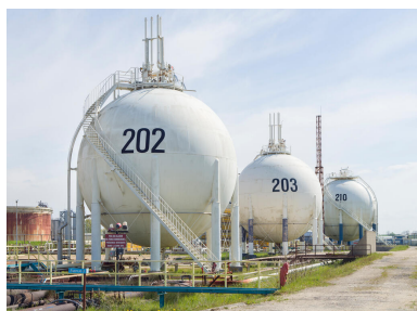
Zone 320, Mouvement de produits. Vue sur la zone des sphères de stockage de gaz. Ces sphères seront conservées pour les futurs projets de la plateforme. Phot. Stéphane Asseline, Phot. Stéphane Asseline IVR11_20237700316NUC4A
