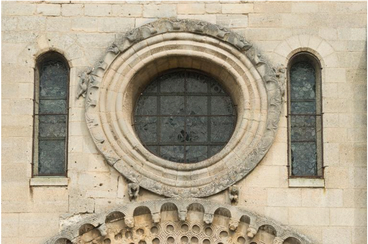
La rose occidentale et les vestiges de la roue de Fortune.
