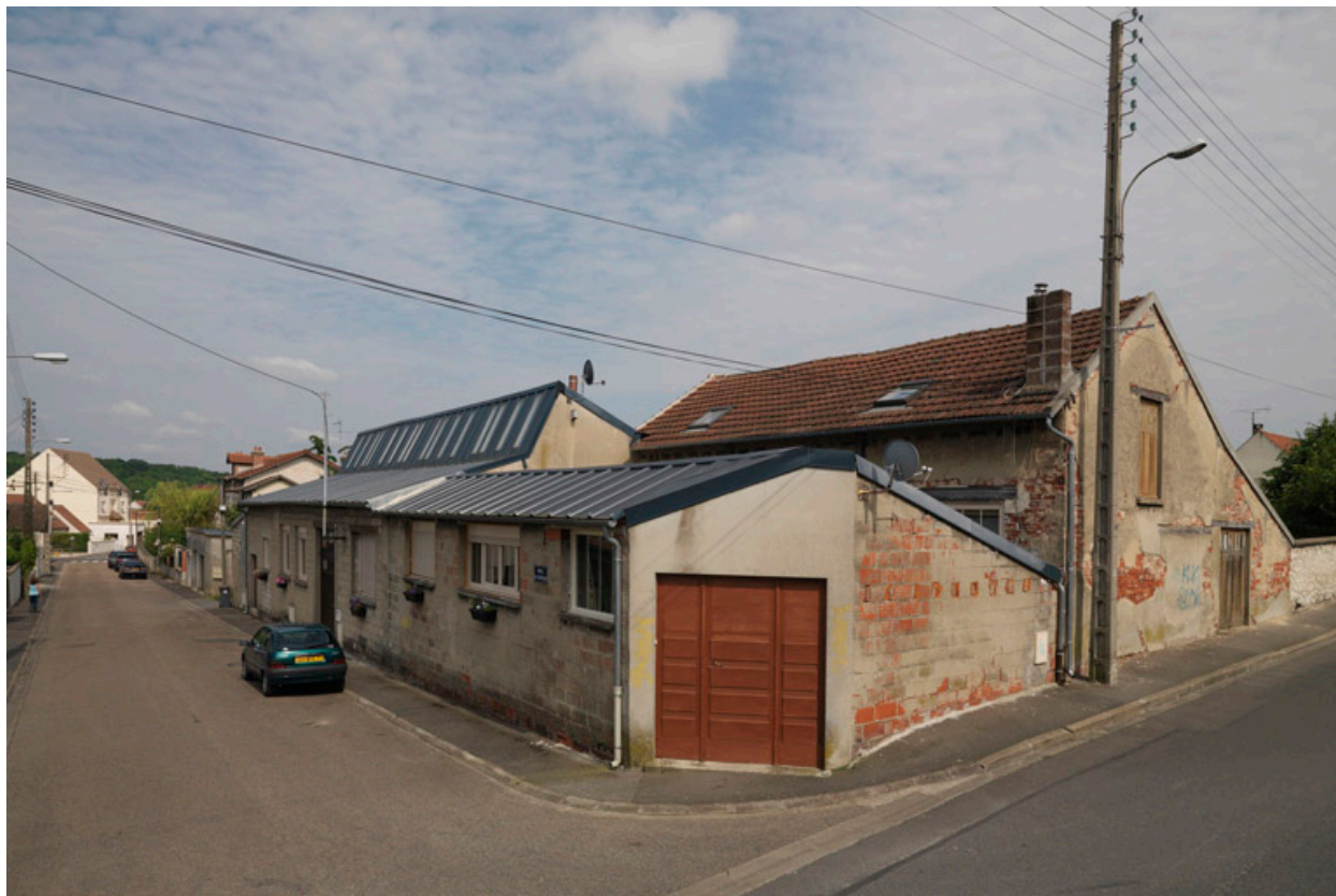
Vue extérieure du bâtiment.
