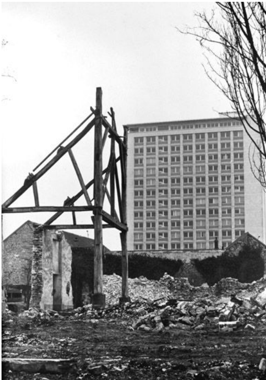
La manutention militaire en cours de démolition. A l'arrière plan, la cité administrative. Photographie. (Musée municipal de Melun)
