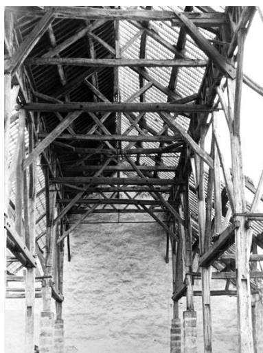
La manutention militaire en cours de démolition : vue de la charpente. Photographie. (Musée municipal de Melun) Phot. Philippe Ayrault, Autr. René (photographe) Thomain IVR11_20047700136X
