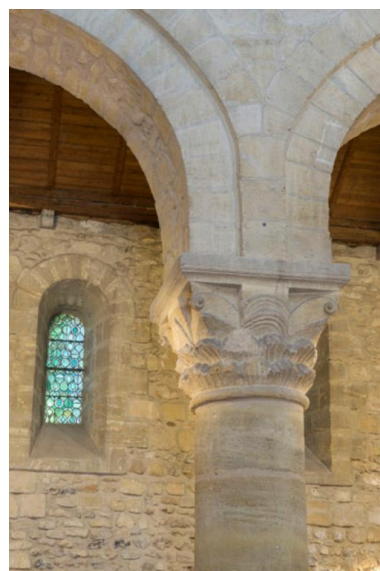
Vue du troisième chapiteau nord. Comme dans le précédent, le dé central présente une variante de lignes concentriques.
