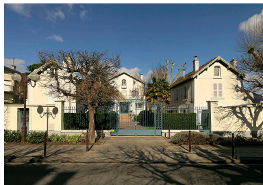
Vue d'ensemble depuis la rue. Phot. Jean-Bernard Vialles IVR11_20089500126NUC4A
