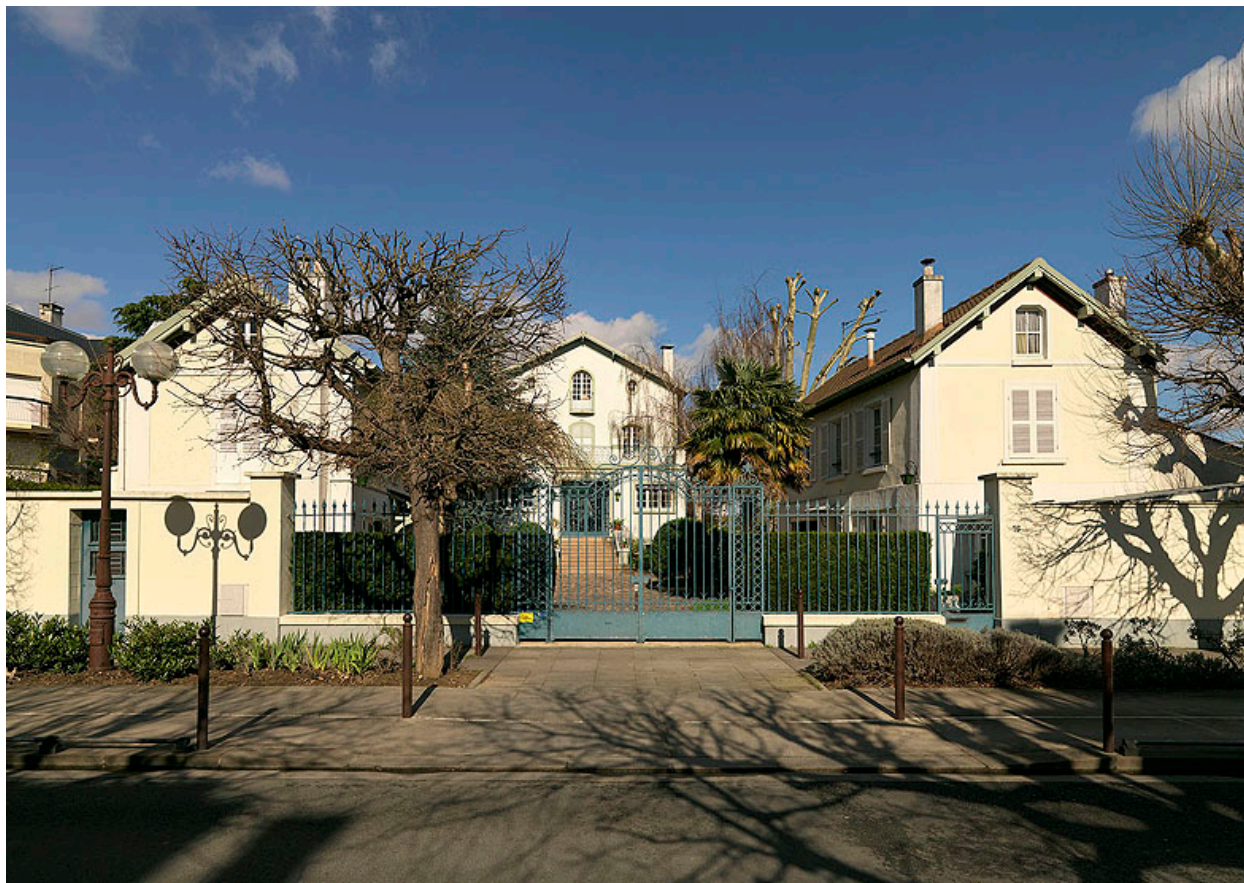
Vue d'ensemble depuis la rue.
