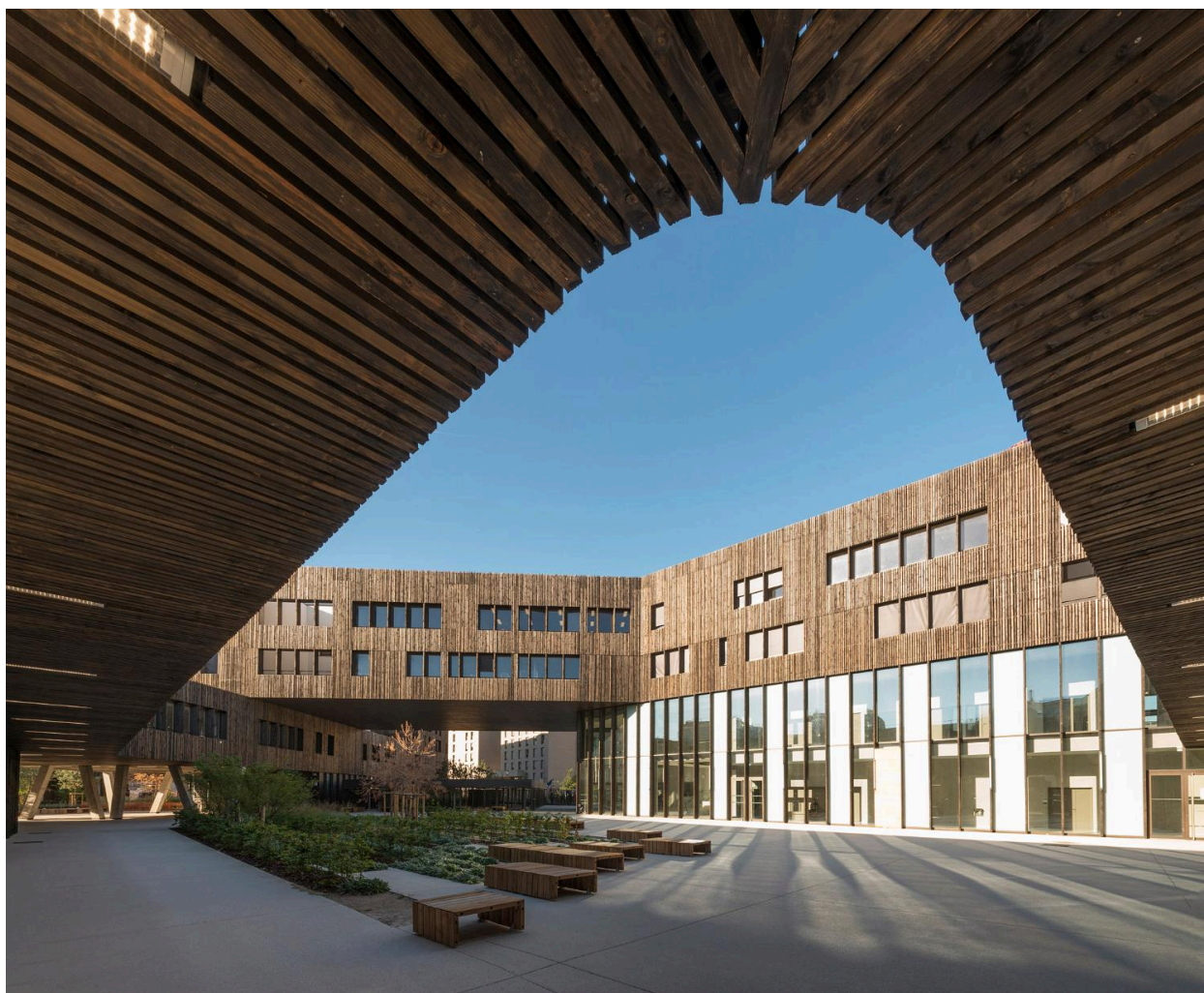
Saint-Denis (Seine-Saint- Denis), lycée La Plaine. Vue sur la cour intérieure. Les parements de bois gris, destinés à se patiner avec le temps, donnent, par leurs variations, une consistance tridimensionnelle aux parois.
