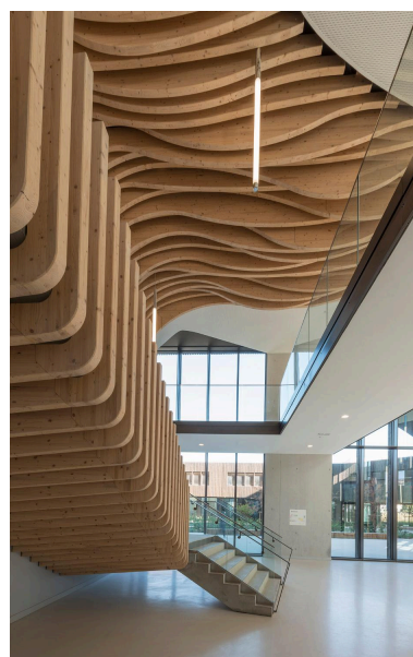
Saint-Denis (Seine-Saint- Denis), lycée La Plaine. Les effets ondoyants des façades se retrouvent dans les boiseries du hall. Phot. Laurent Kruszyk IVR11_20189300106NUC4A
