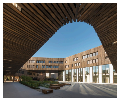
Saint-Denis (Seine-Saint- Denis), lycée La Plaine. Vue sur la cour intérieure. Les parements de bois gris, destinés à se patiner avec le temps, donnent, par leurs variations, une consistance tridimensionnelle aux parois. Phot. Laurent Kruszyk IVR11_20189300097NUC4A
