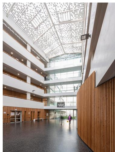
Courbevoie (Hauts-de-Seine), lycée Lucie-Aubrac. La rue intérieure est surmontée d'une verrière pixellisée, composée de piles photovoltaïques, qui filtre la lumière et projette ses jeux d'ombres sur les parois.
