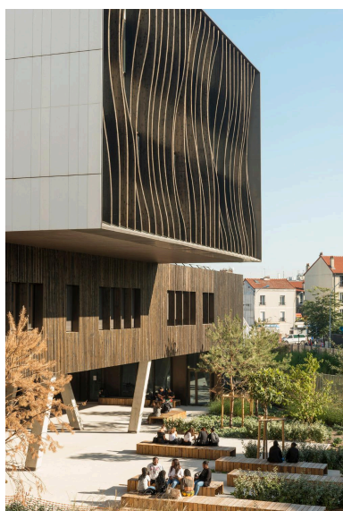
Saint-Denis (Seine-Saint- Denis), lycée La Plaine. Cet établissement se veut aussi à énergie zéro. Les façades sont traitées comme un entrelac de rubans, qui produit un effet ondoyant. Phot. Laurent Kruszyk IVR11_20189300099NUC4A
