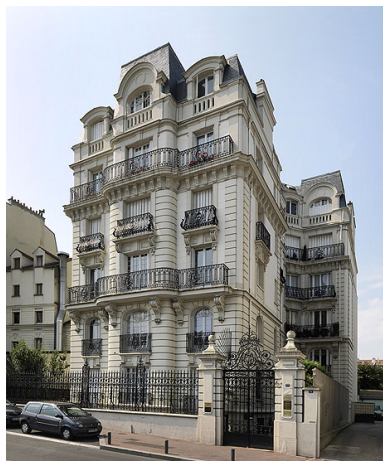
Vue d'ensemble depuis la rue Phot. Jean-Bernard Vialles IVR11_20089500357NUC4A
