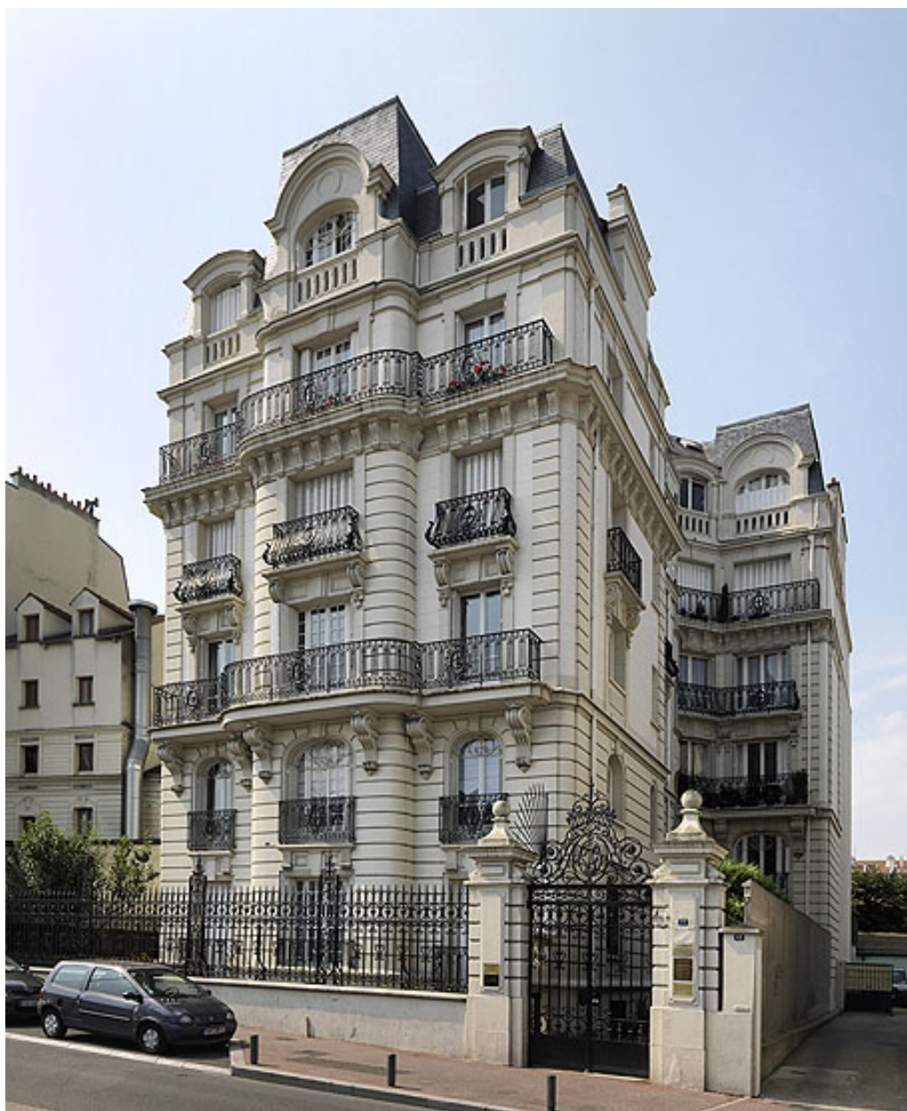
Vue d'ensemble depuis la rue
