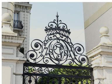
Détail du couronnement du portail en ferronnerie : monogramme du propriétaire (G de M. Geogr) dans un cartouche entouré de volutes et surmonté d'un motif de couronne.
